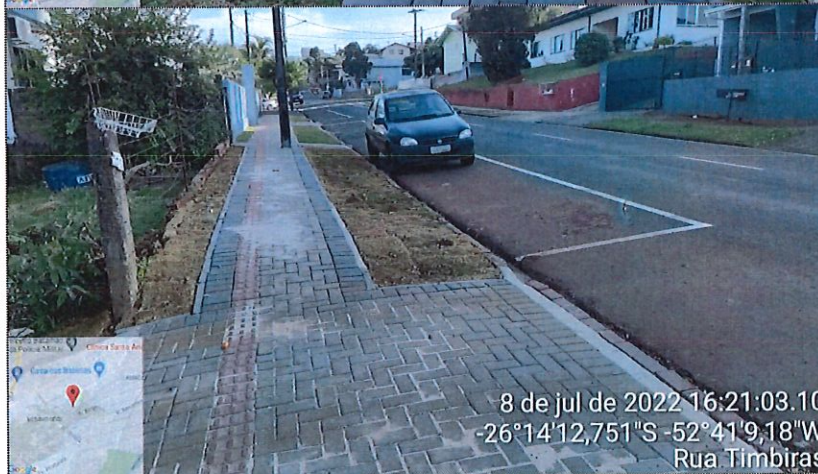
Imagem 09: Pavimentação CBUQ / Sinalização / Calçadas
