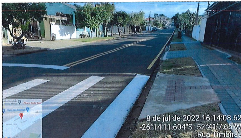
Imagem 07: Pavimentação CBUQ / Sinalização / Calçadas
