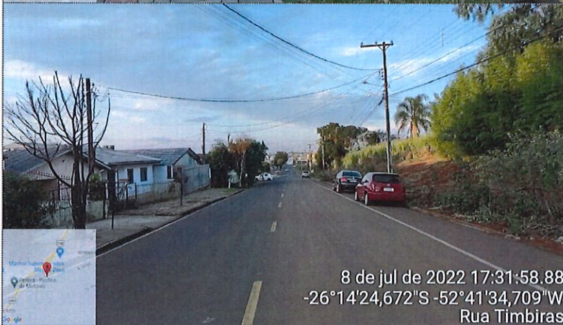
Imagem 23: Pavimentação CBUQ / Sinalização
