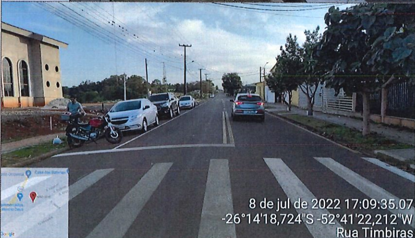
Imagem 18: Pavimentação CBUQ / Sinalização / Calçadas
