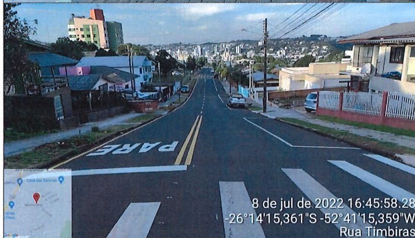
Imagem 14: Pavimentação CBUQ / Sinalização / Calçadas
