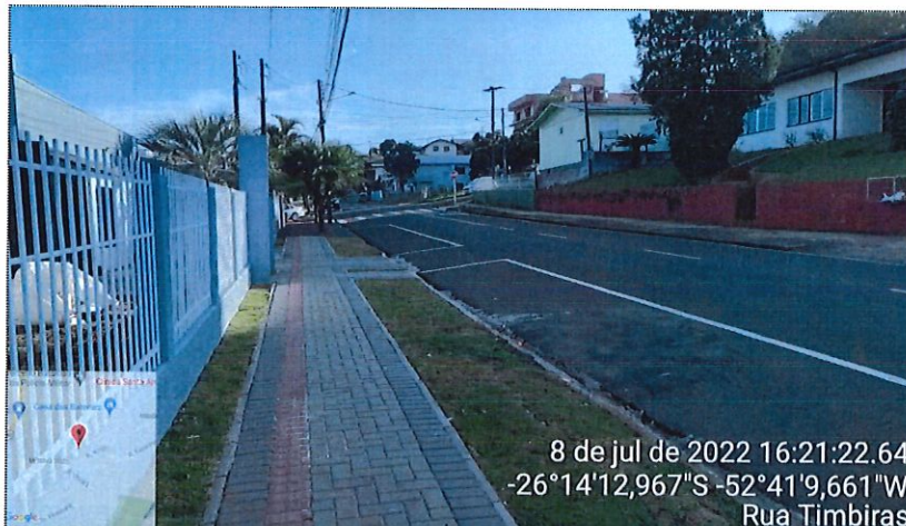
Imagem 10: Pavimentação CBUQ / Sinalização / Calçadas
