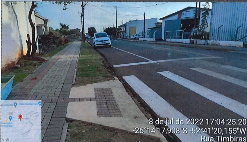
Imagem 17: Pavimentação CBUQ / Sinalização / Calçadas
