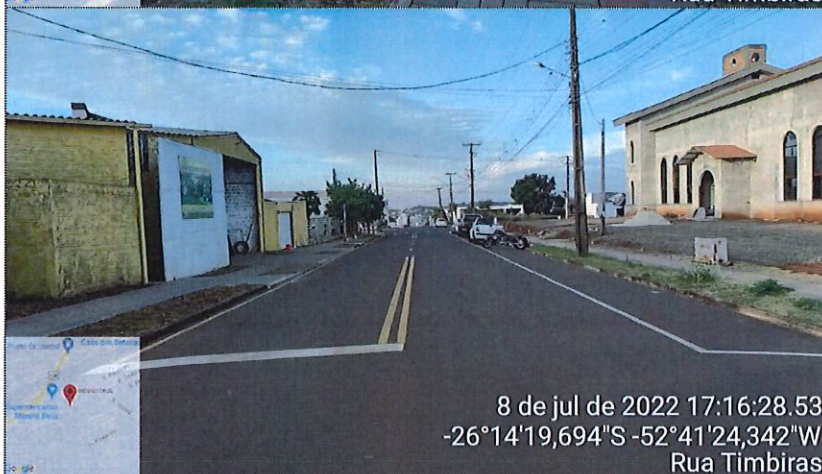
Imagem 20: Pavimentação CBUQ / Sinalização / Calçadas
