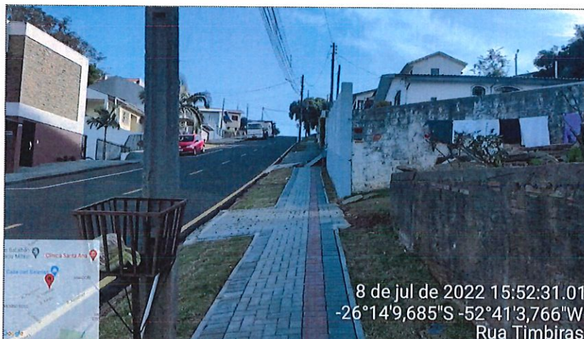
Imagem 04: Pavimentação CBUQ / Sinalização / Calçadas
