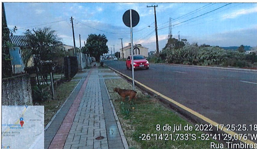
Imagem 22: Pavimentação CBUQ / Sinalização / Calçadas
