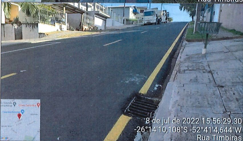
Imagem 05: Pavimentação CBUQ / Sinalização / Drenagem
