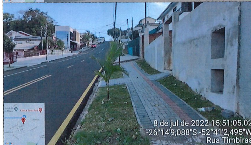
Imagem 03: Pavimentação CBUQ / Sinalização / Calçadas
