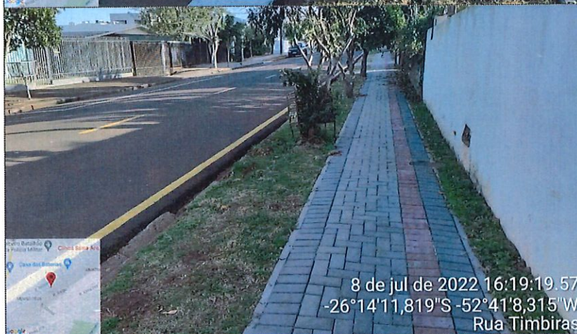
Imagem 08: Pavimentação CBUQ / Sinalização / Calçadas
