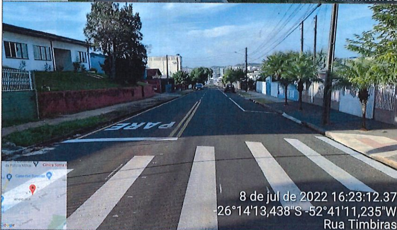
Imagem 11: Pavimentação CBUQ / Sinalização
