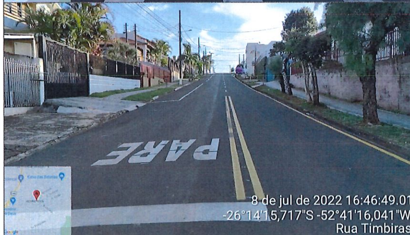
Imagem 15: Pavimentação CBUQ / Sinalização / Calçadas
