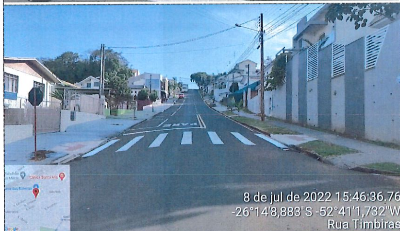
Imagem 02: Pavimentação CBUQ / Sinalização / Calçadas
