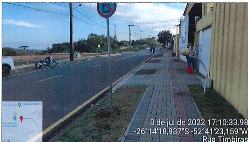
Imagem 19: Pavimentação CBUQ / Sinalização / Calçadas
