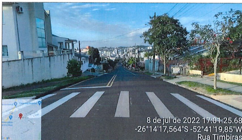
Imagem 16: Pavimentação CBUQ / Sinalização / Calçadas
