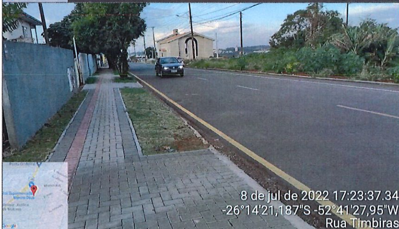
Imagem 21: Pavimentação CBUQ / Sinalização / Calçadas
