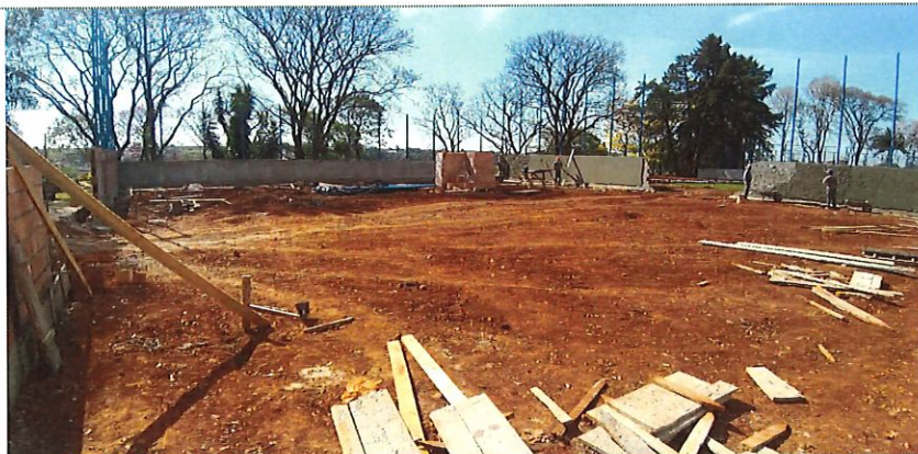
Revestimento da mureta da quadra de vôlei
