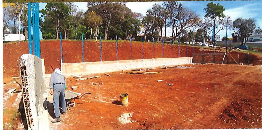
Revestimento da mureta da quadra de vôlei
