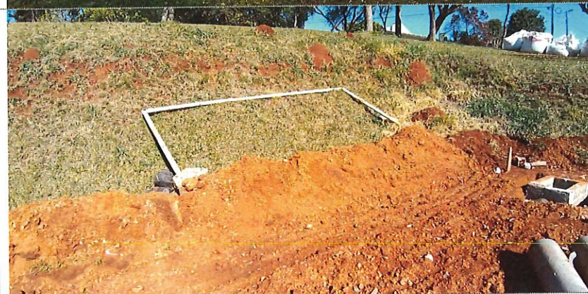
Retirada das traves
