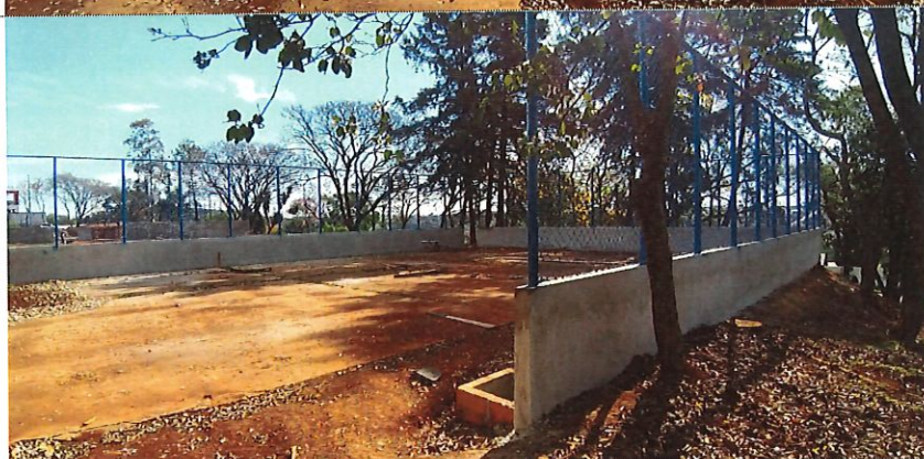
Revestimento da mureta da quadra de basquete e do campo
