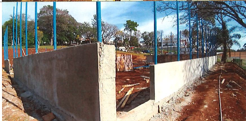
Revestimento da mureta da quadra de vôlei
