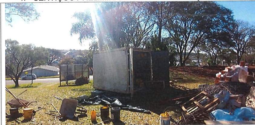
Container para barracão de obra
