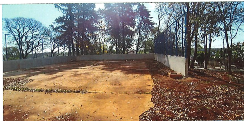
Revestimento da mureta da quadra de basquete
