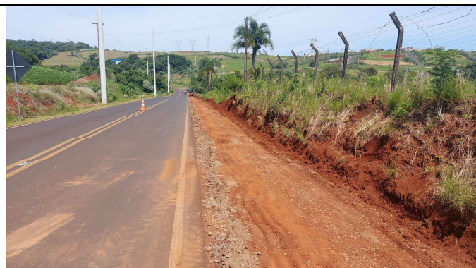
FOTO 03: ESCAVAÇÃO, COMPACTAÇÃO E REGULARIZAÇÃO
