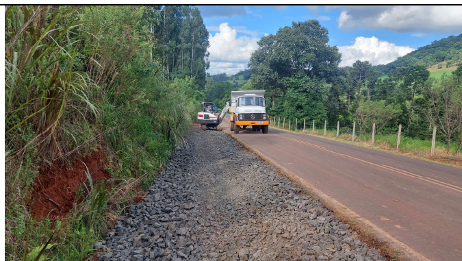
FOTO 09: SUB-BASE EM MACADAME
