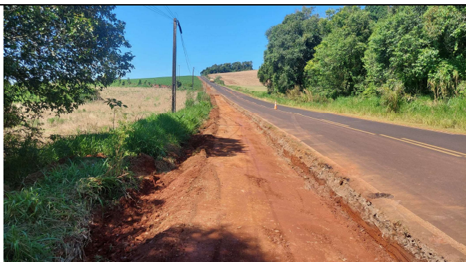
FOTO 02: ESCAVAÇÃO, COMPACTAÇÃO E REGULARIZAÇÃO
