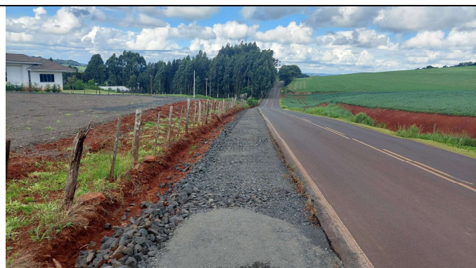
FOTO 06: SUB-BASE EM MACADAME
