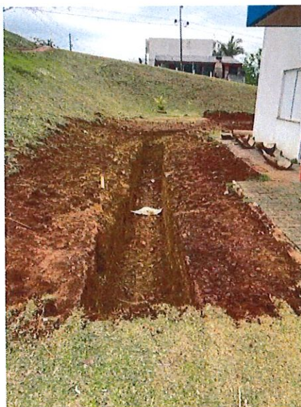
Foto 4: Abertura das trincheiras
