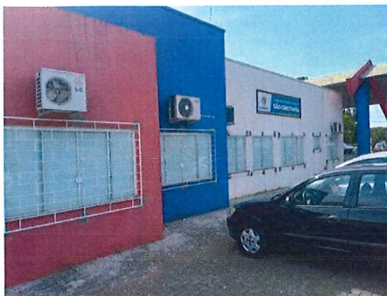
Foto 7: grades nas janelas
