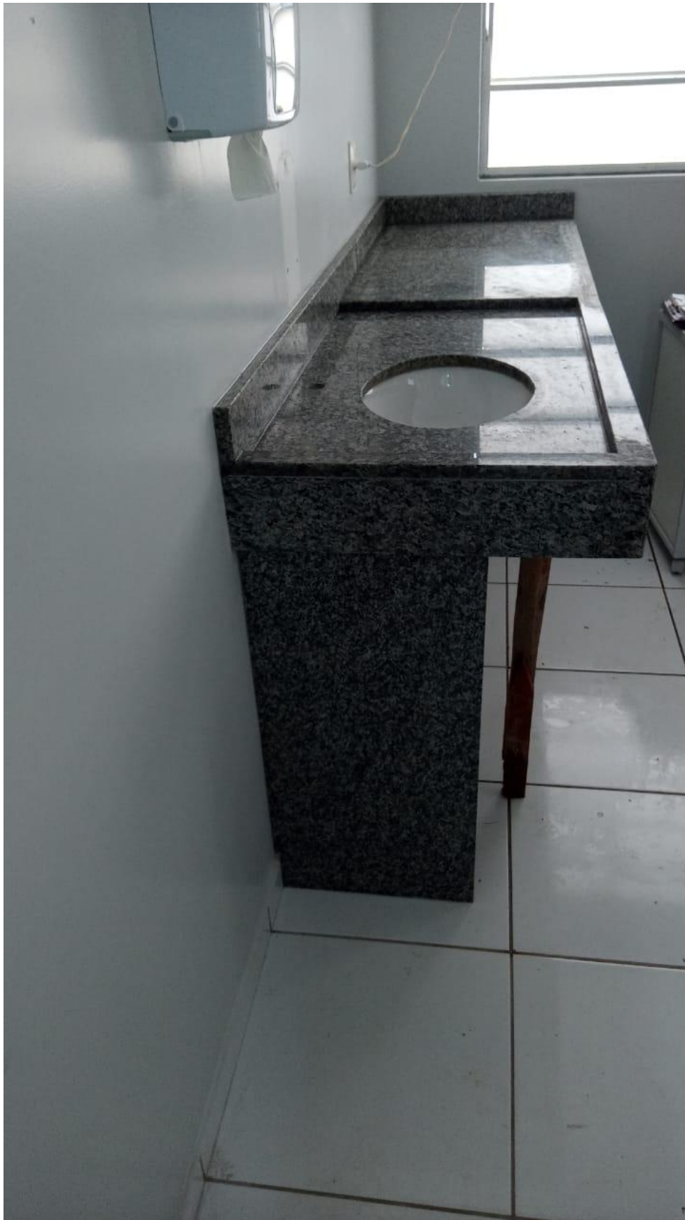
Foto 5: Instalação de bancada.
