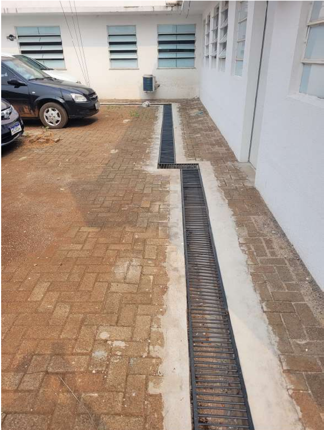
Foto 1: Pintura externa. Canaleta de Drenagem.
