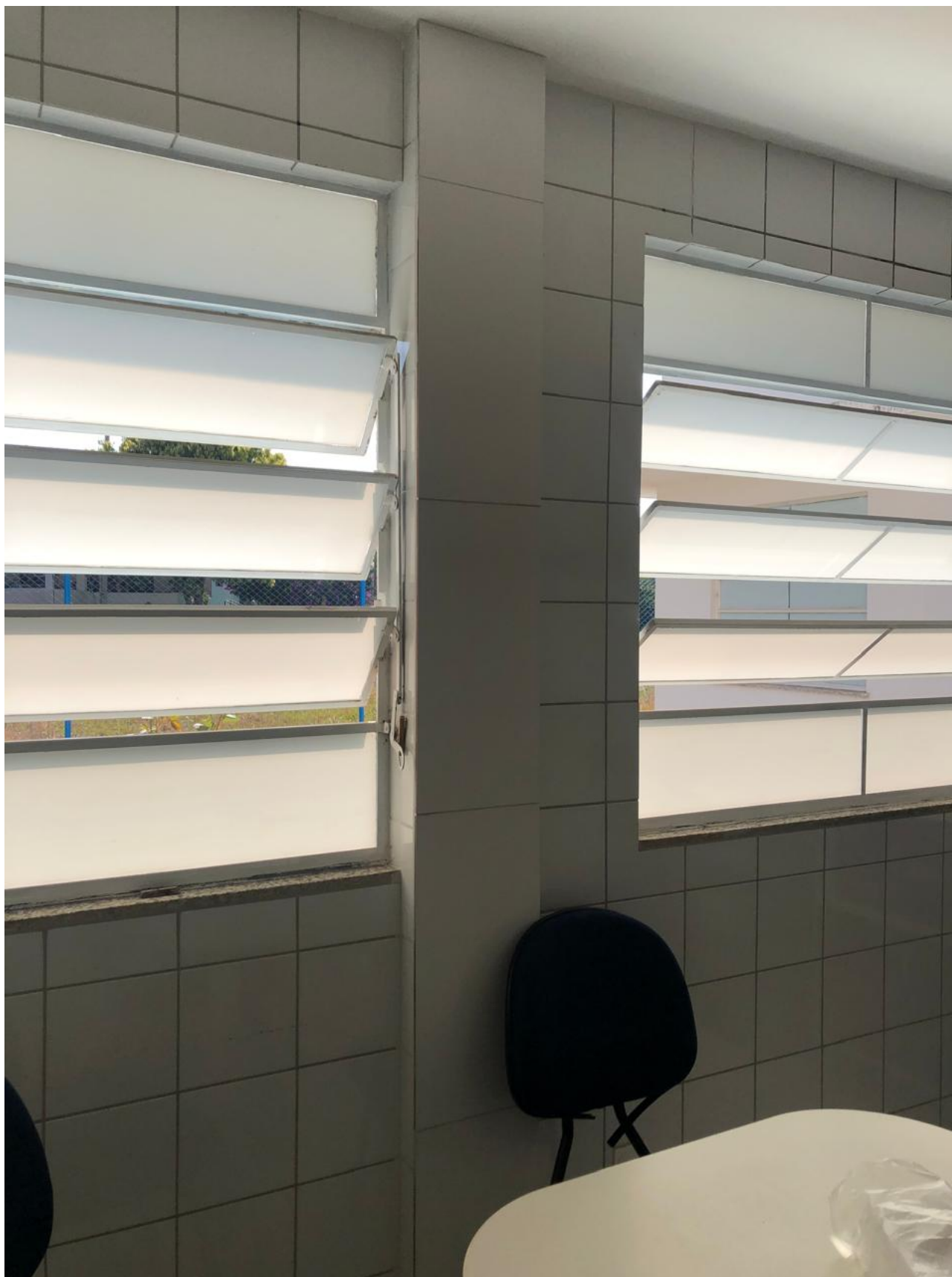
Foto 4: Revestimento em paredes internas.
