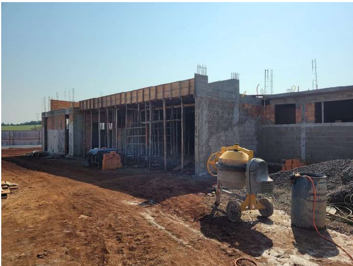
Foto 1: Fachada da Obra.
