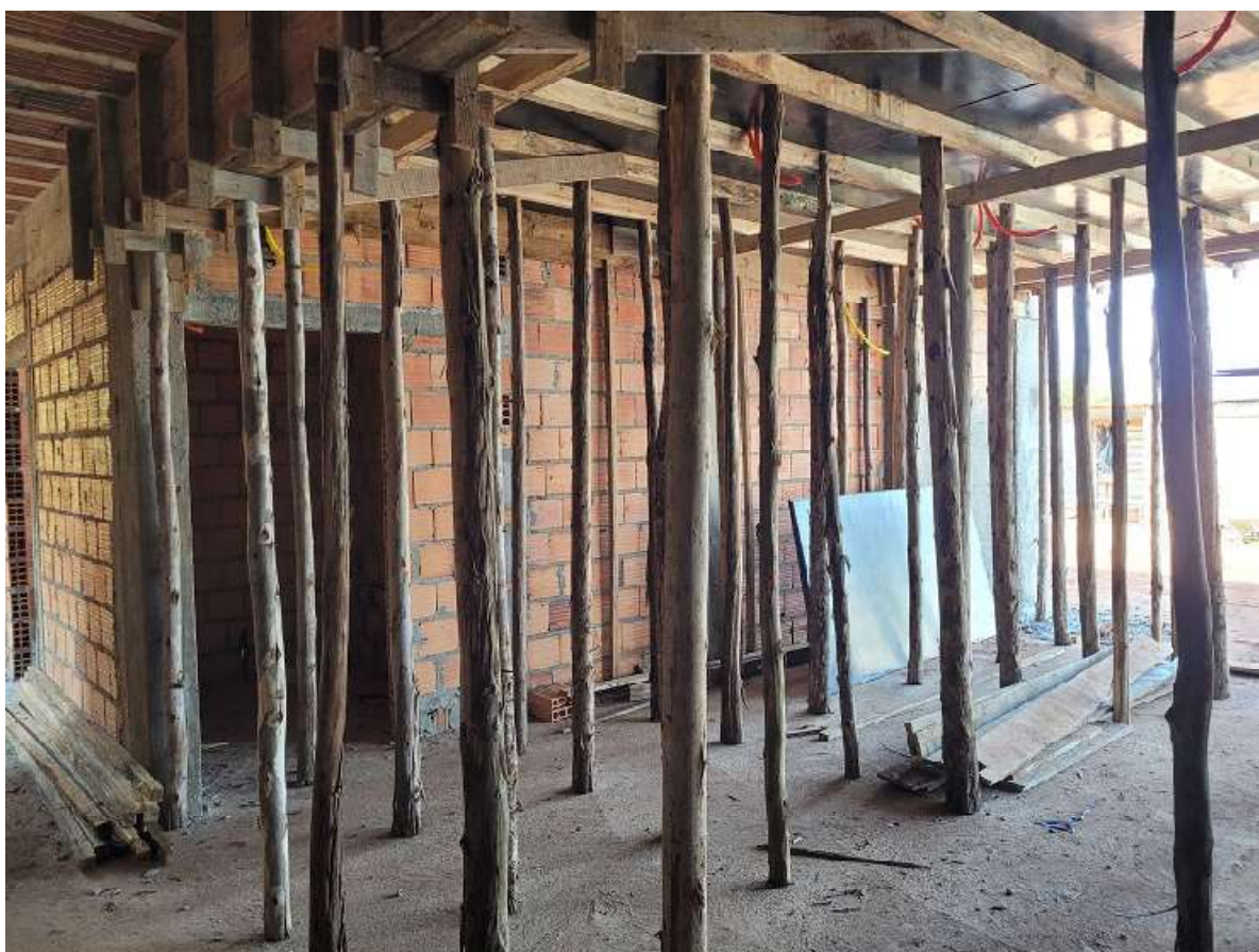
Foto 6: Recepção. Laje e alvenarias.
