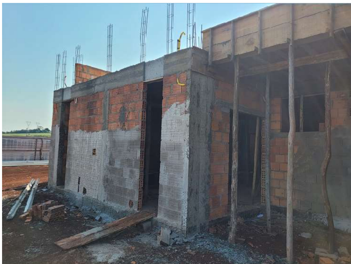
Foto 2: Formas vigas, alvenarias e platibandas.
