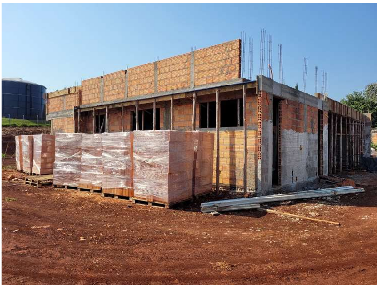
Foto 5: Lateral da Obra. Alvenarias, platibandas.
