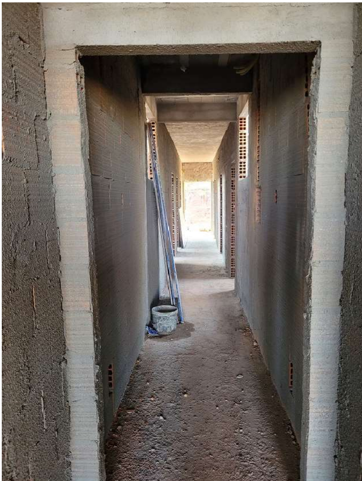
Foto 7: Chapisco e Reboco Interno.
