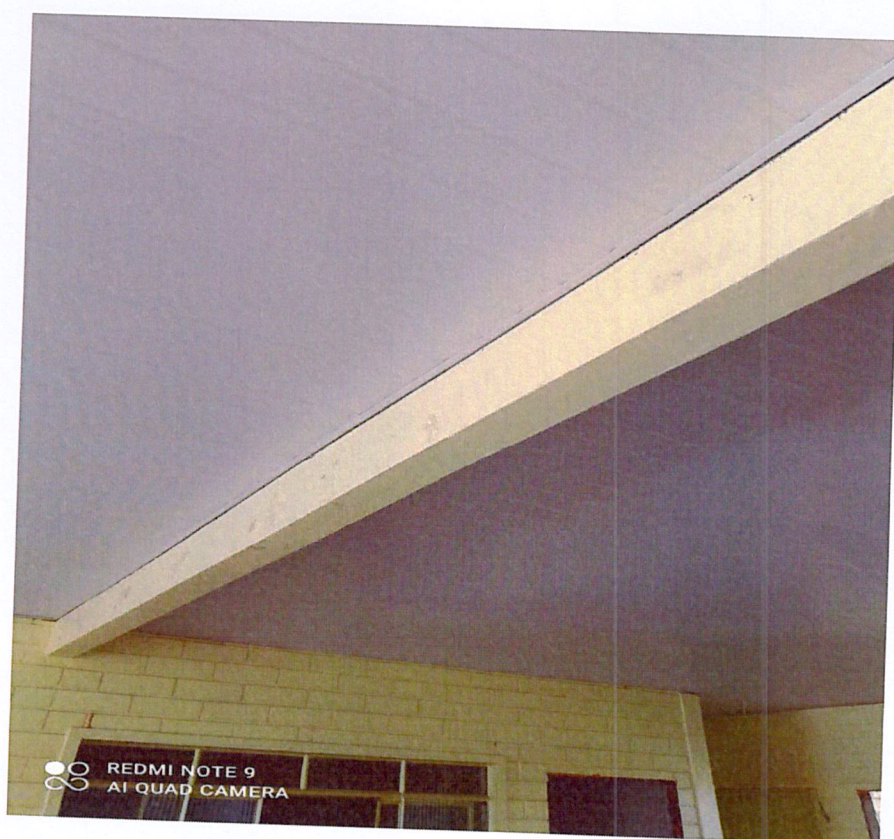
Foto 06: Forro PVC salas de aula.
