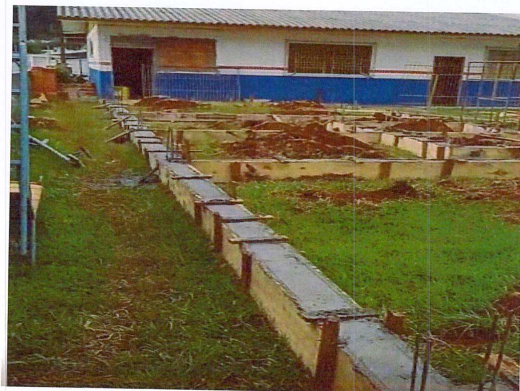
Foto 10: Vigas baldrame salas de aula concretadas.
