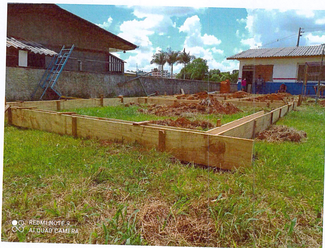
Foto 07: Caixaria vigas baldrame construção salas de aula.
