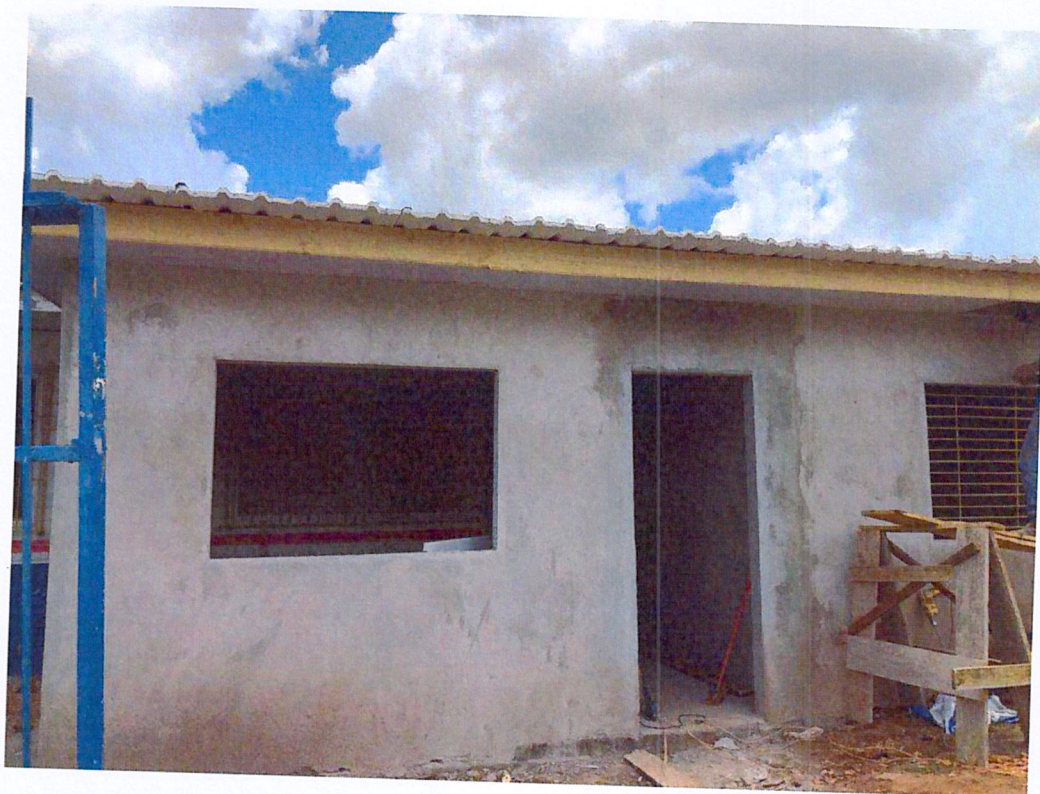
Foto 11: Finalização emboço, cobertura e telhamento ampliação brinquedoteca.
