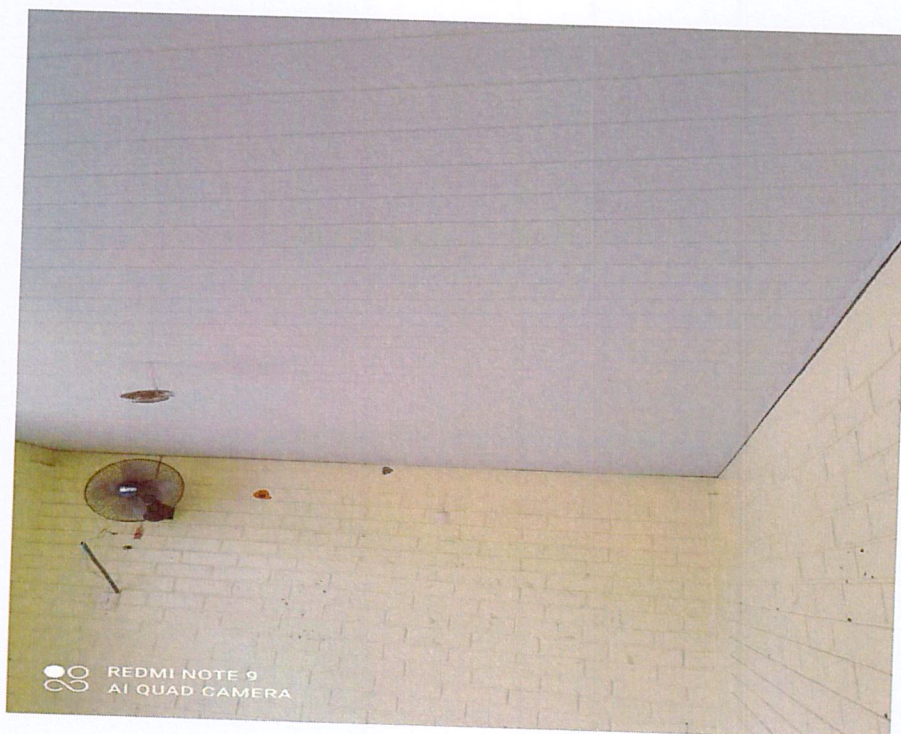
Foto 05: Forro PVC salas de aula.
