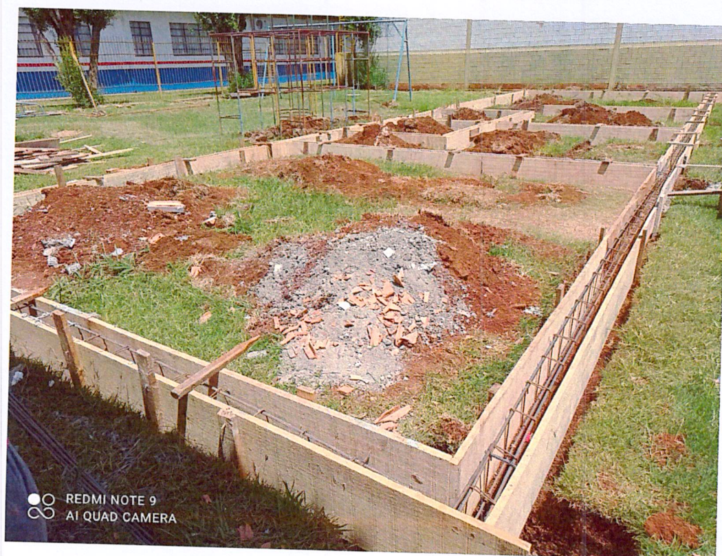
Foto 08: Caixaria vigas baldrame construção salas de aula.
