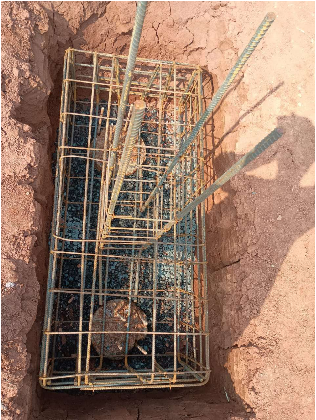
Foto 7: Armadura blocos de fundações.
