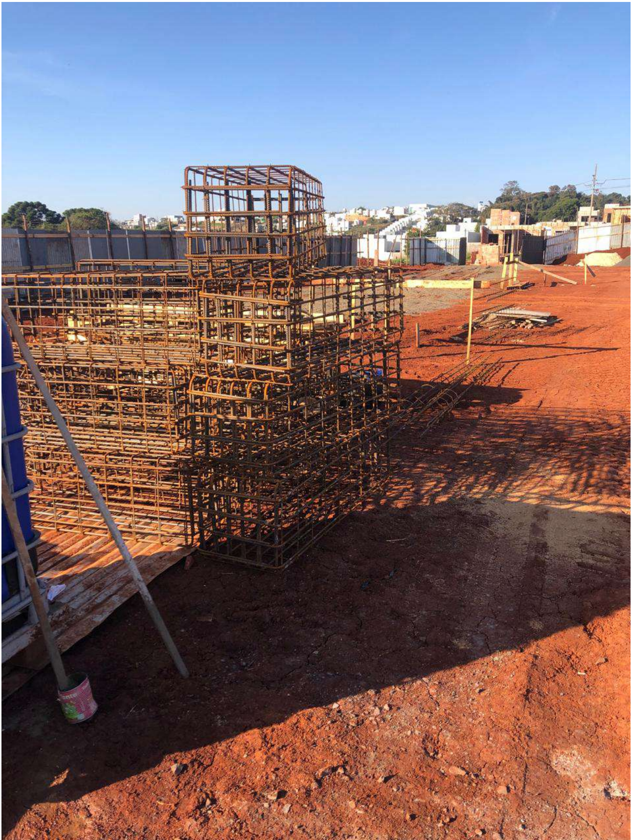
Foto 4: Armação blocos de fundações.
