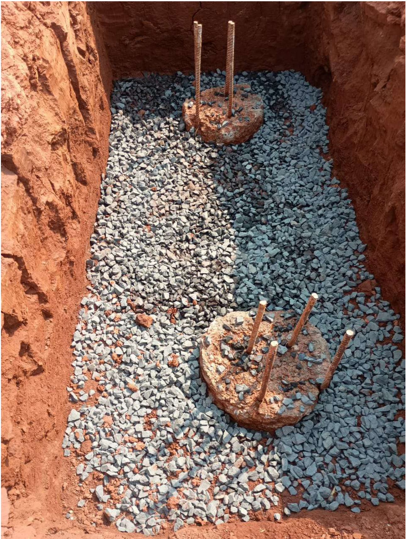
Foto 6: Estacas concretadas, lastro de material granular.
