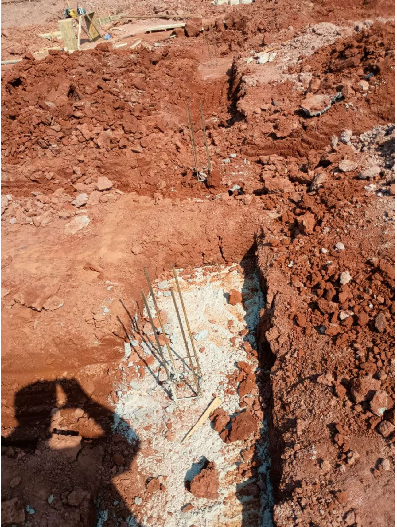
Foto 8: Blocos de fundação concretados.
