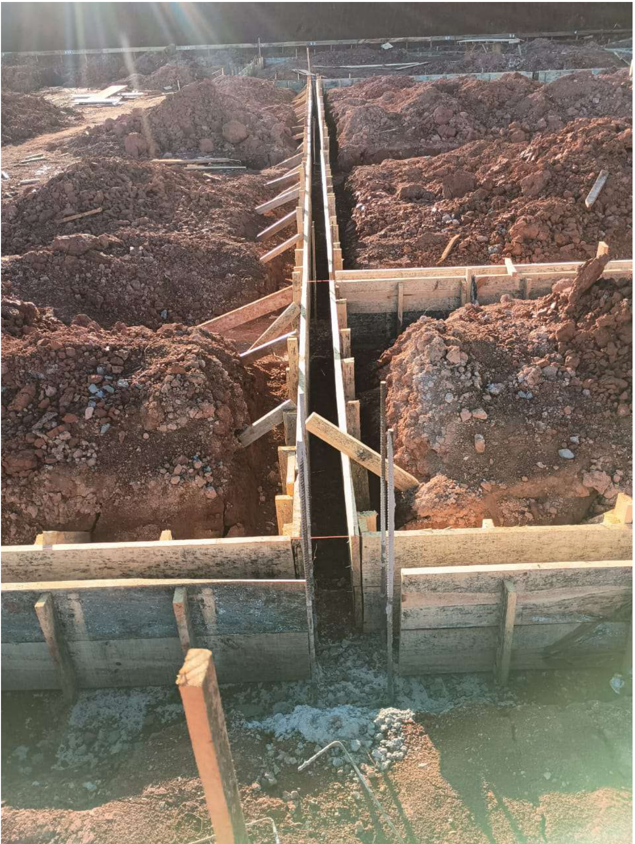
Foto 9: Caixaria para vigas baldrames.
