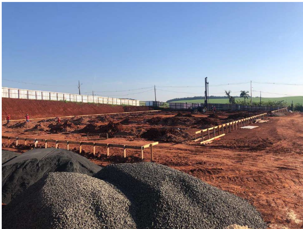
Foto 2: Localização e escavação de estacas e blocos.
