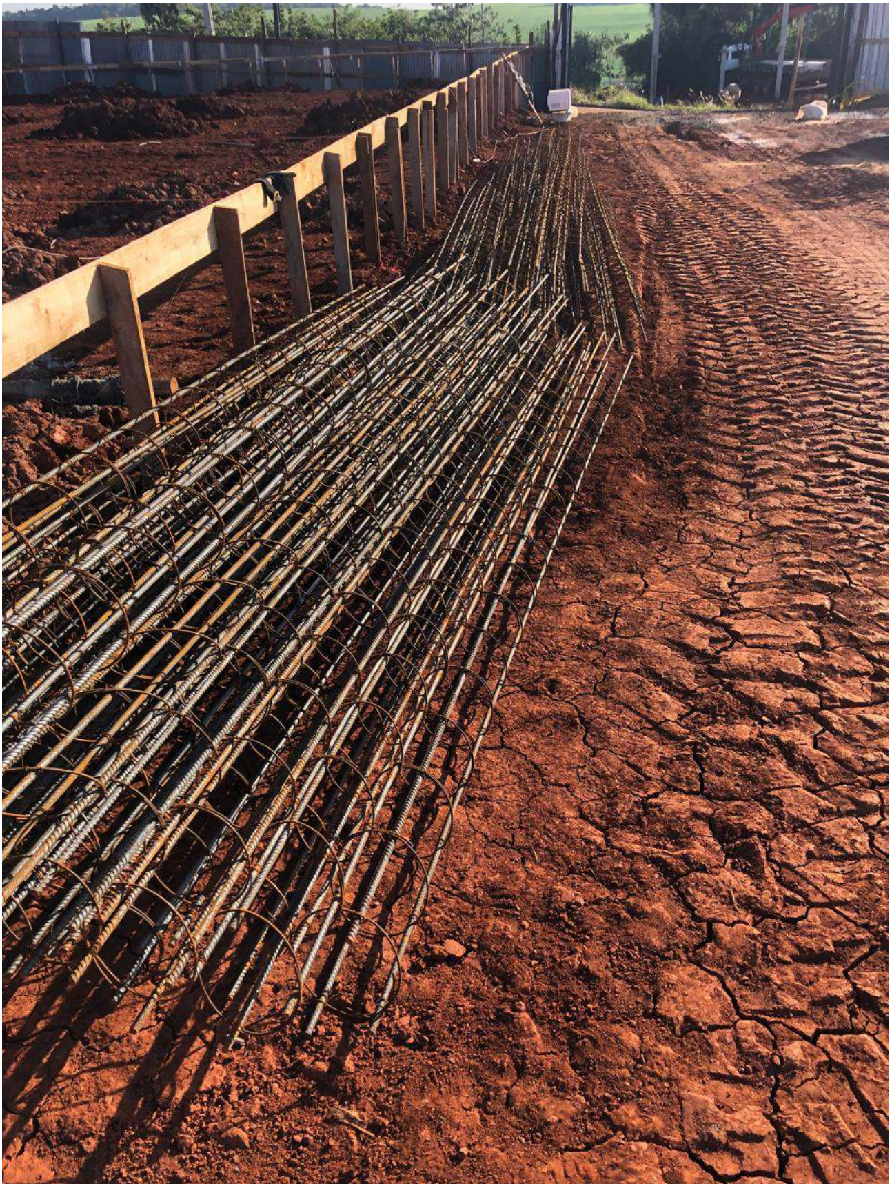
Foto 3: Armação das Estacas.
