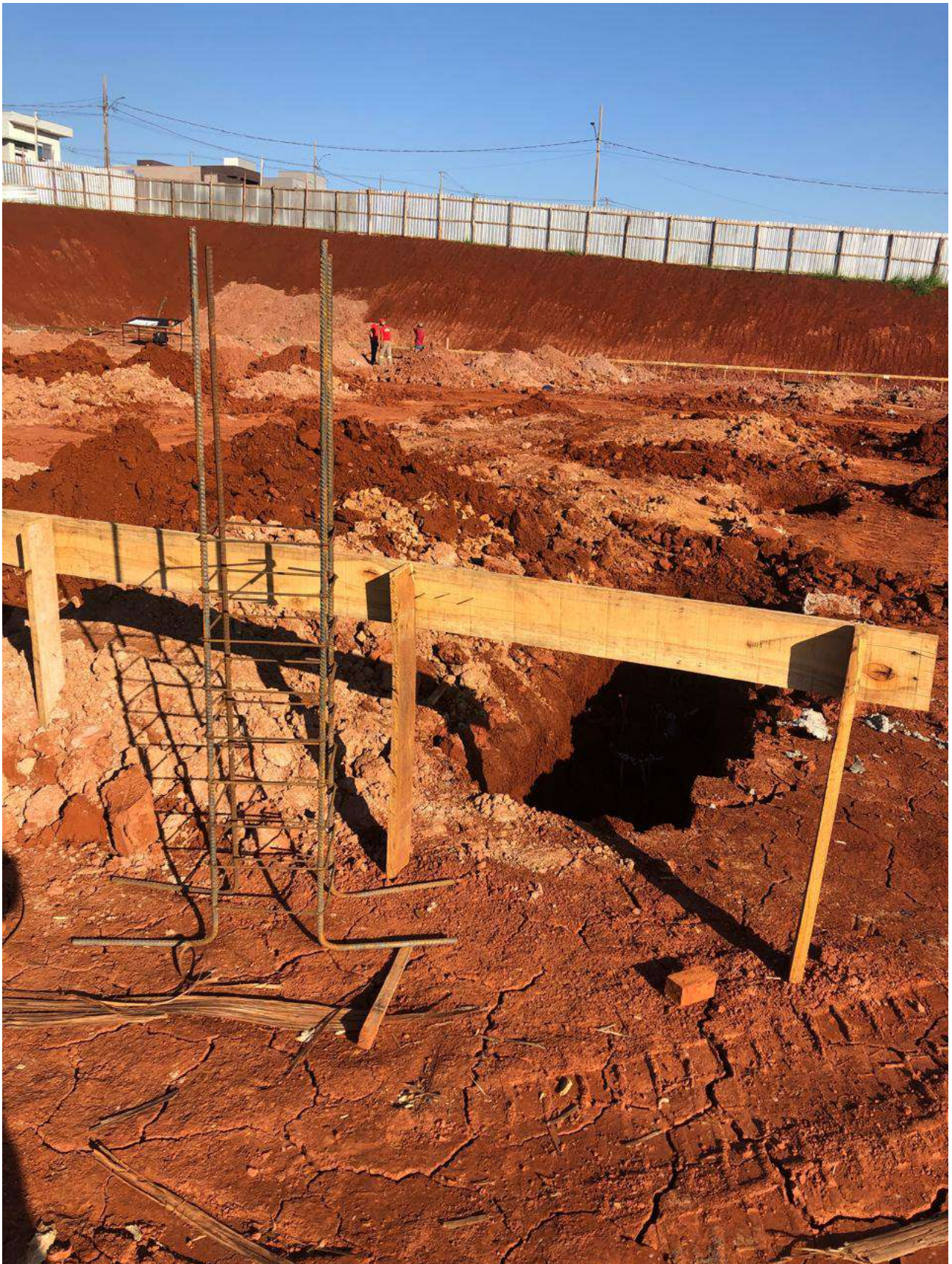
Foto 5: blocos e arranque de pilares.
