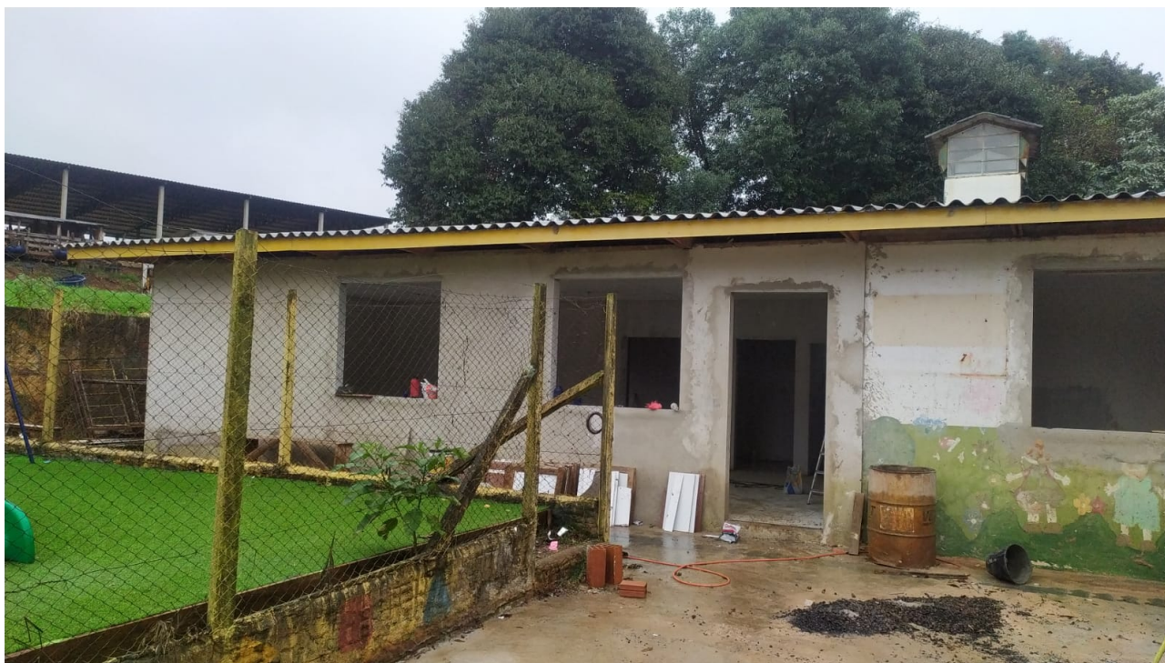
Foto 5: Revestimento externo (chapisco/emboço).
