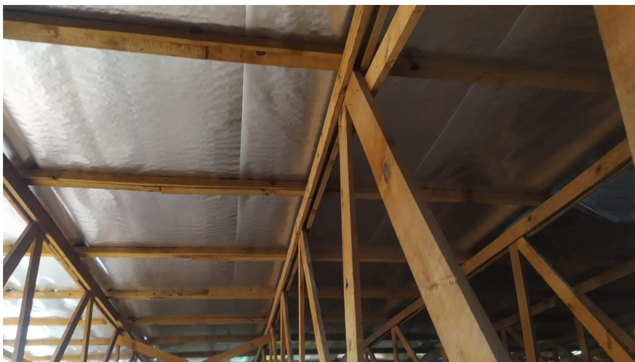
Foto 4: Manta na subcobertura.
