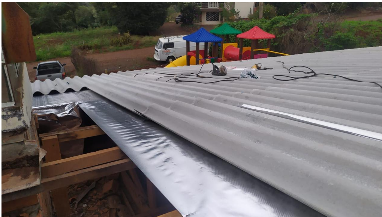
Foto 1: Telhamento e manta.
