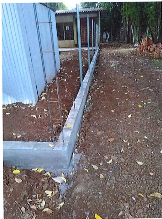
Foto 3: Construção do cercamento
