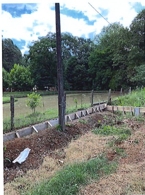
Foto 4: Construção do cercamento
