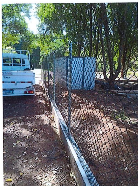
Foto 6: Finalização do cercamento
