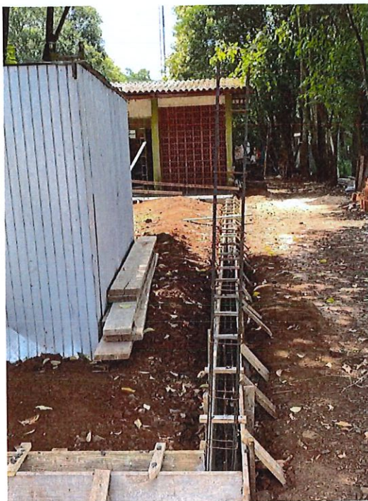
Foto 1: Construção do cercamento
