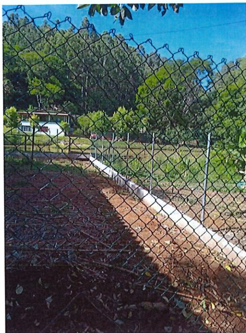
Foto 5: Finalização do cercamento
