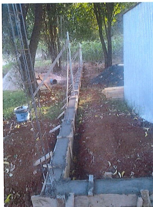
Foto 2: Construção do cercamento
