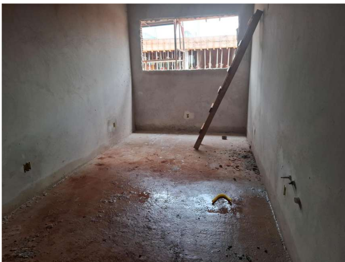
Foto 14 – Bloco Consultórios Especializados
