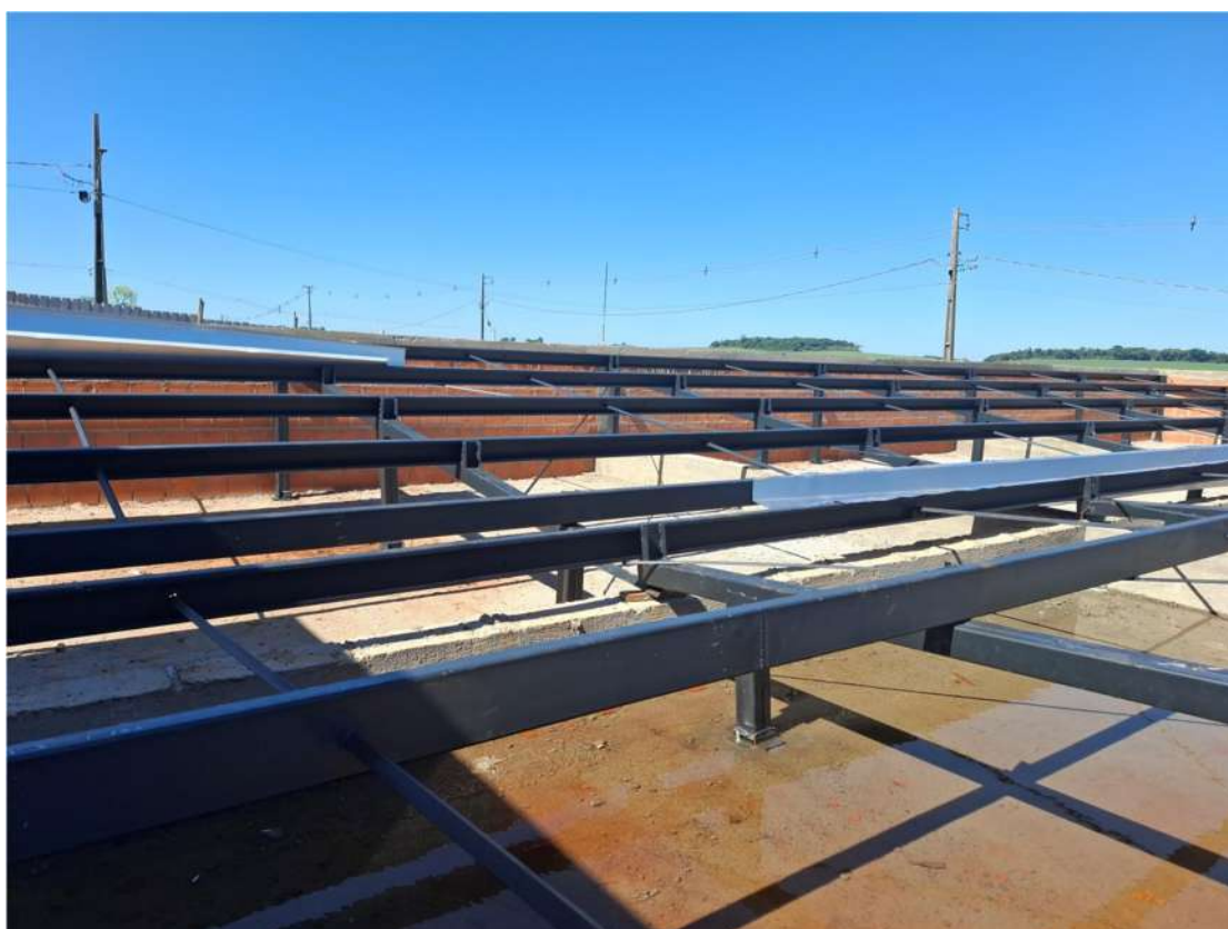
Foto 8 – Estrutura Metálica Bloco Salas de Terapia
