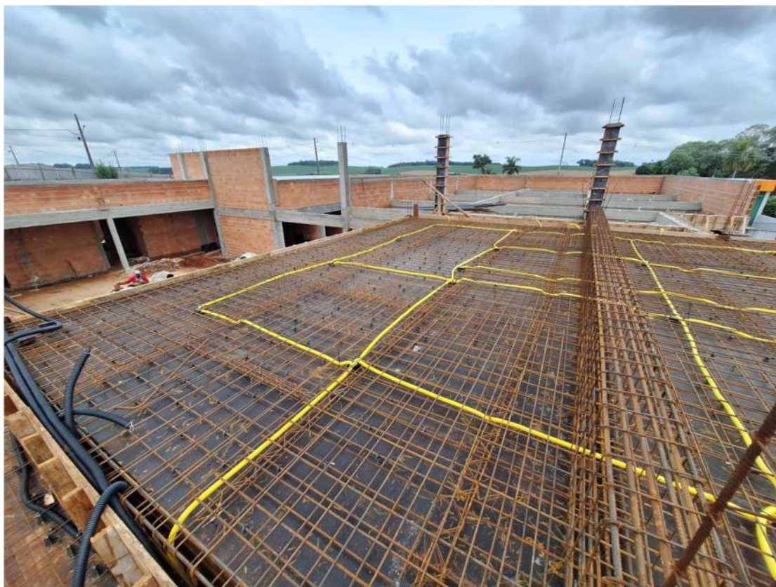
Foto 19 – Laje da Recepção/Espera
