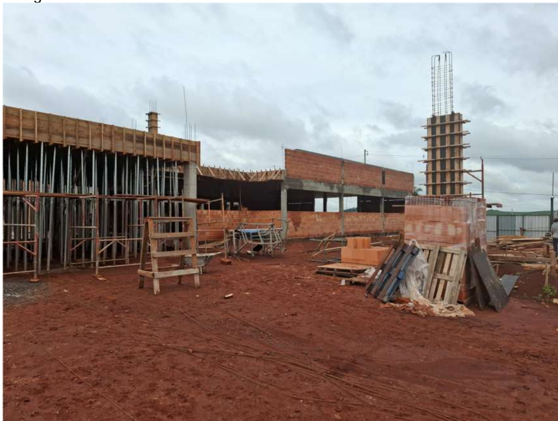
Foto 1: Bloco Salas CST. Clínico – Vista Externa
