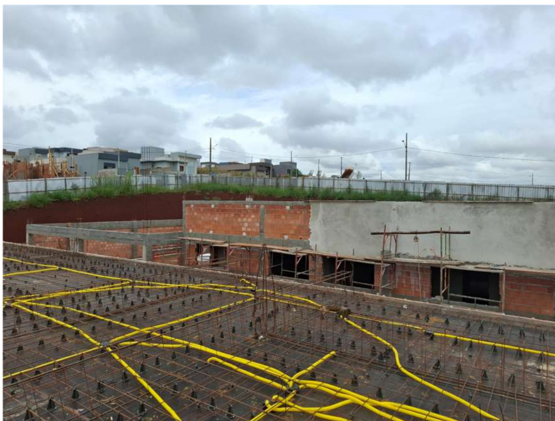
Foto 11 – Bloco Consultórios Especializados – Vista Externa
