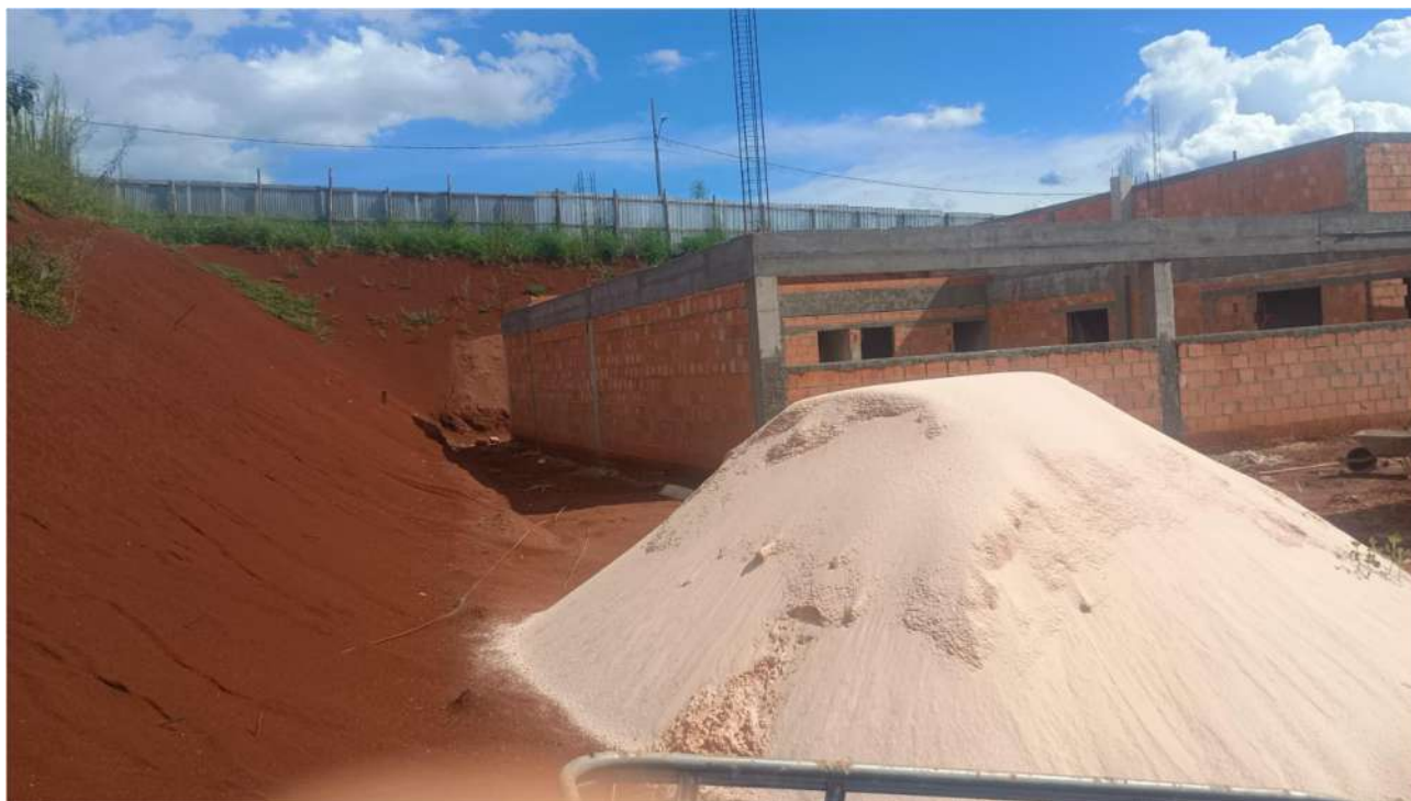
Foto 15 – Bloco Ginásio/ Box Terapia – Vista Externa
