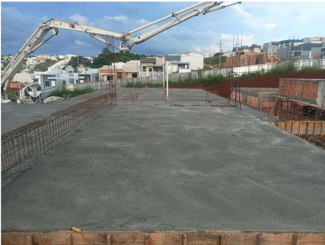
Foto 21 – Concretagem da Laje do Bloco Administrativo e Recepção/Espera
