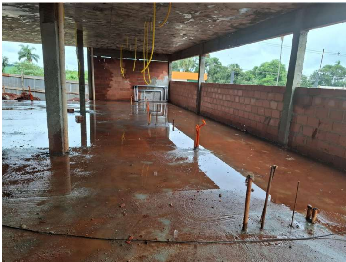
Foto 3 – Bloco Salas CST. Clínico
