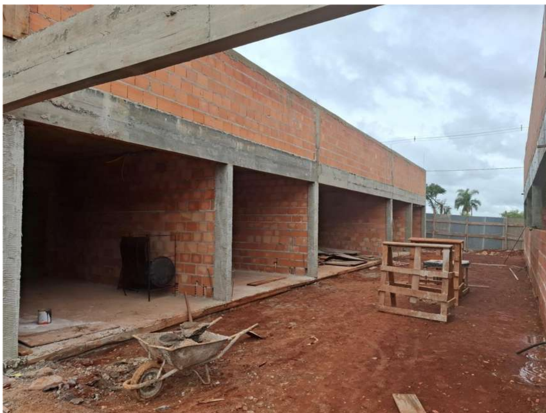
Foto 4 – Bloco Salas de Terapia – Vista Externa
