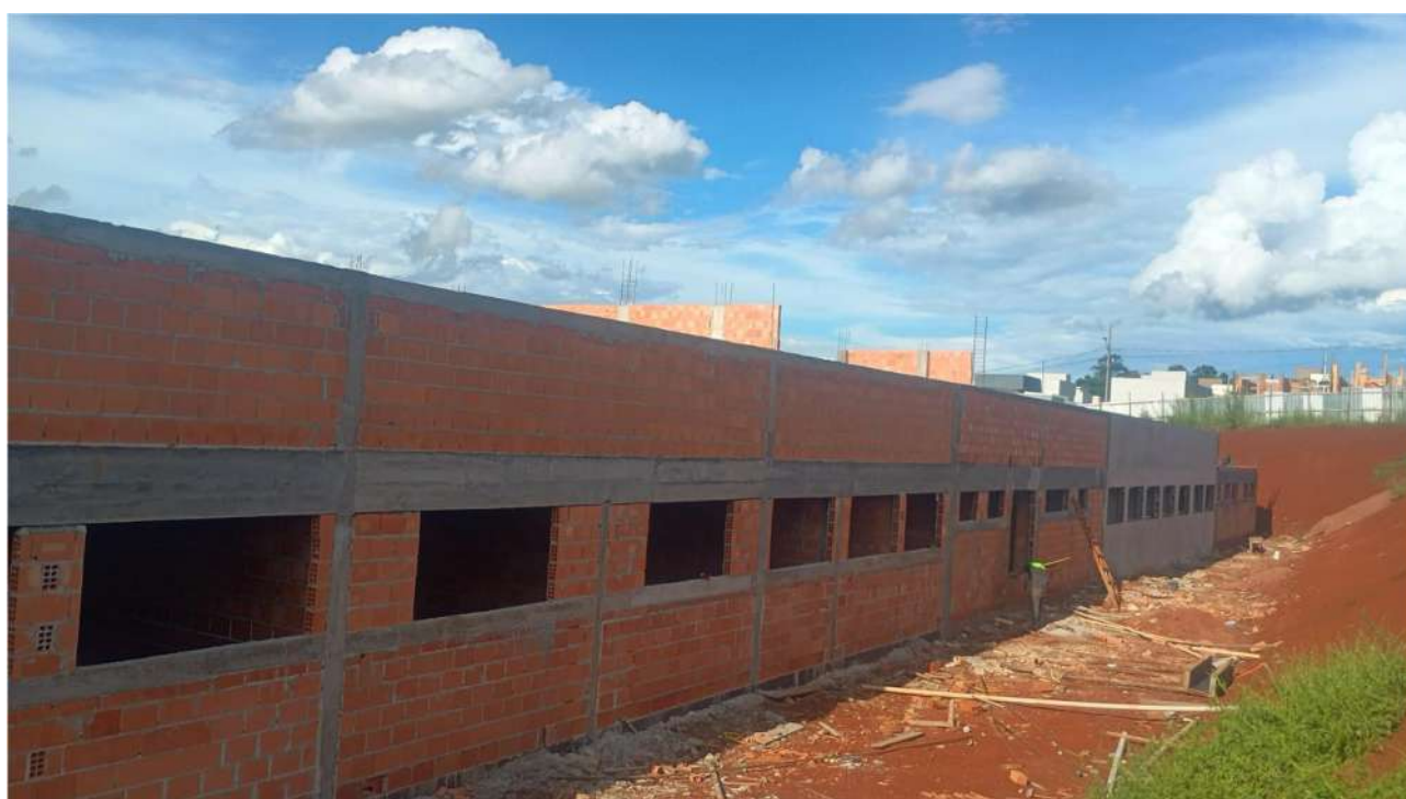
Foto 12 – Bloco Consultórios Especializados – Vista Externa
