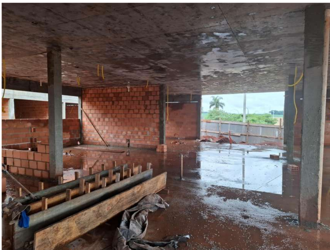
Foto 2 – Bloco Salas CST. Clínico
