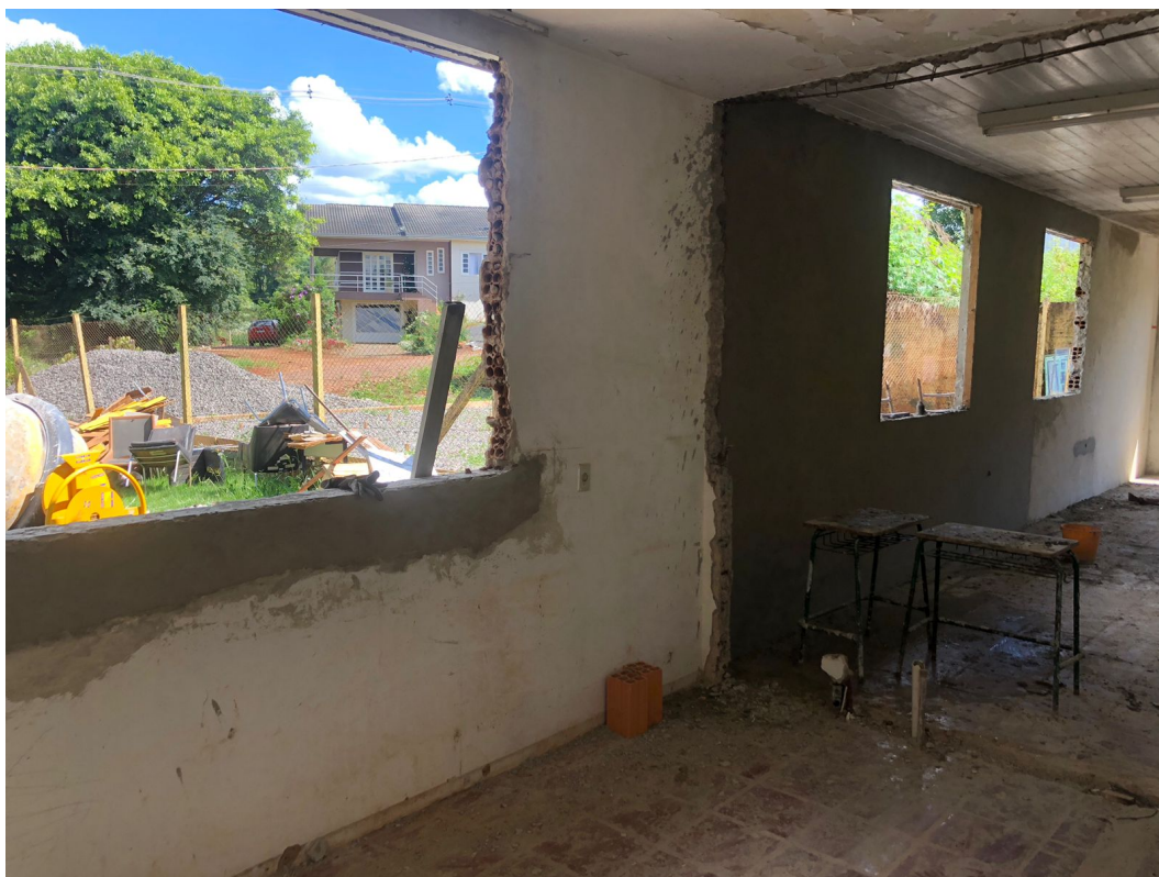
Foto 3: Remoção de Aberturas. Revestimentos internos. Remoção de paredes internas.
