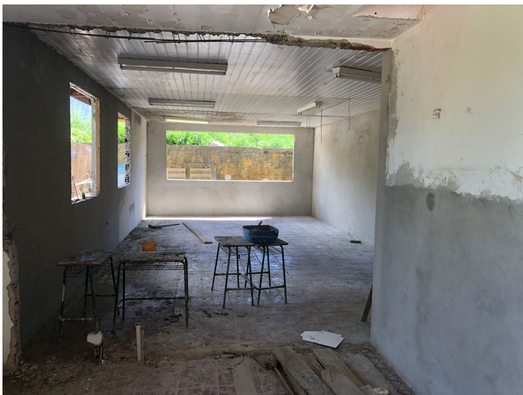
Foto 4: Remoção de Aberturas. Revestimentos internos. Remoção de paredes internas.
