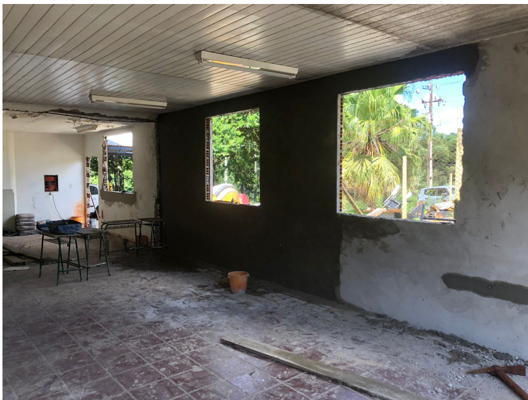
Foto 2: Remoção de Aberturas. Revestimentos internos.
