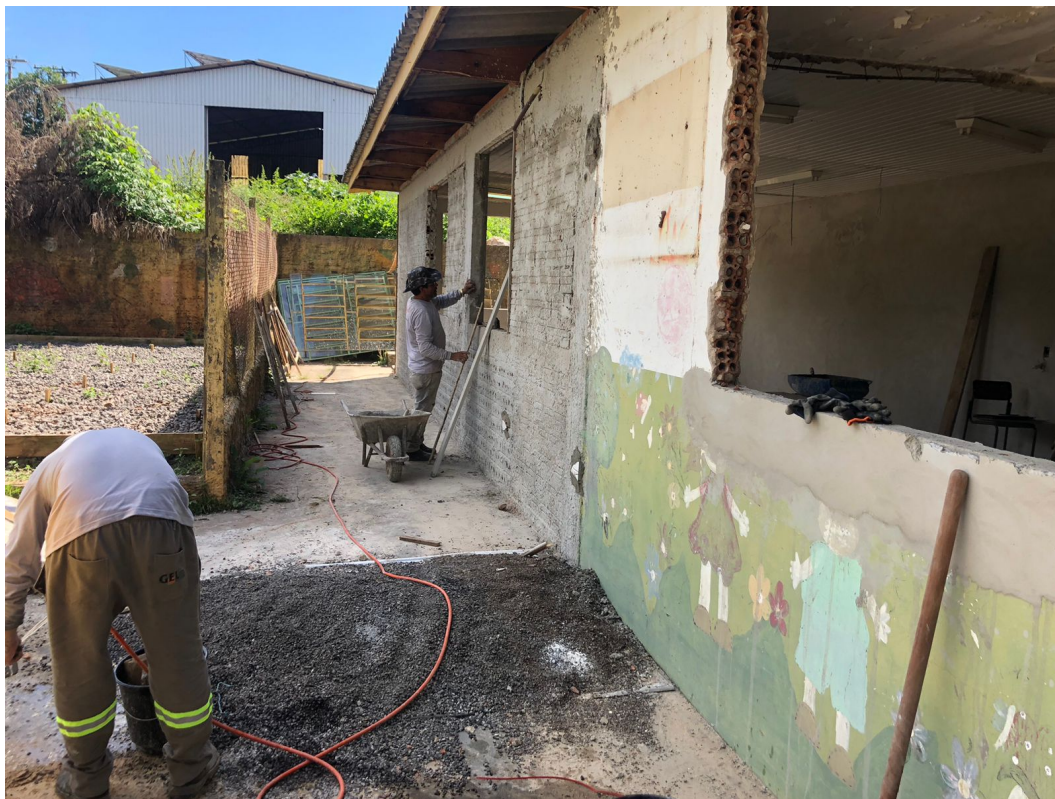
Foto 1: Remoção de Aberturas. Revestimentos externo.
