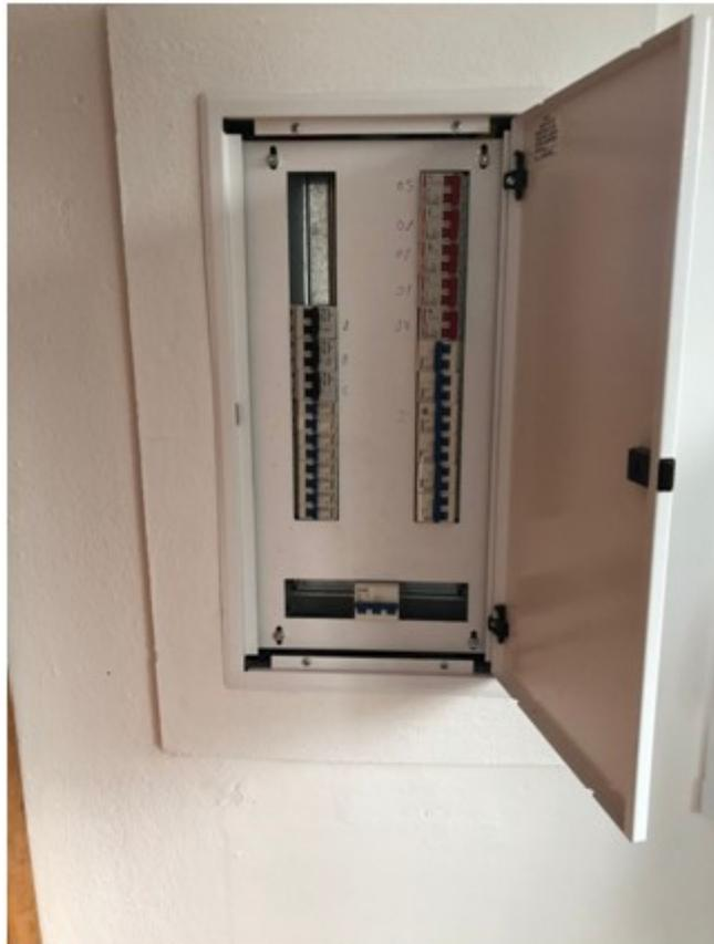
**Foto 2: Quadro de energia elétrica (disjuntores).**
