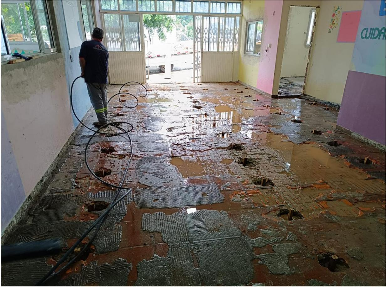
**Foto 1: Remoção de revestimento cerâmico.**
