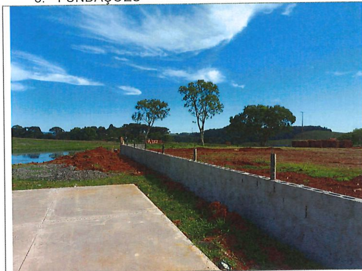
Estaca broca campo
