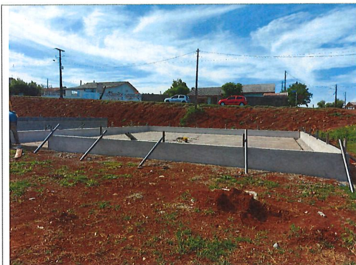
Execução de pilares e vigas do playground
