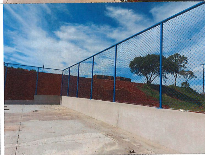
Execução de pilares e vigas da quadra
