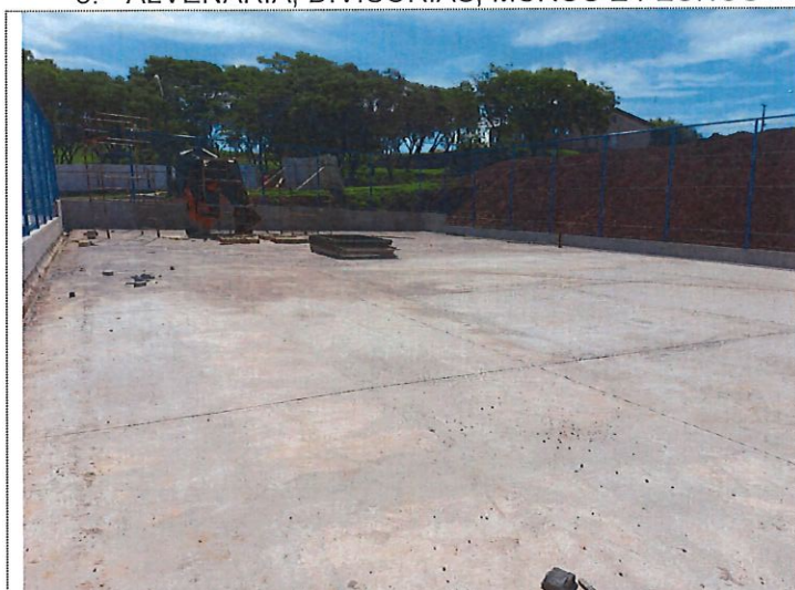
Alvenaria de vedação da quadra
