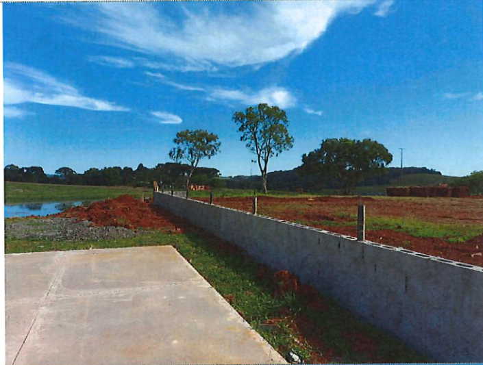
Alvenaria de vedação da mureta do campo
