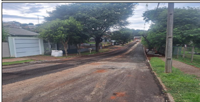
12 | FRESAGEM RUA TEÓFILO A. LOIOLA
