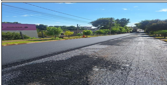
14 | PAVIMENTAÇÃO RUA TEÓFILO A. LOIOLA
