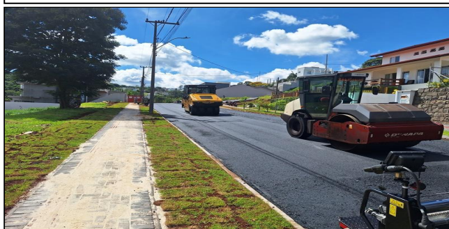
16 | PAVIMENTAÇÃO RUA IGUAÇU
