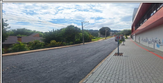
9 | REPERFILAGEM RUA IGUAÇU
