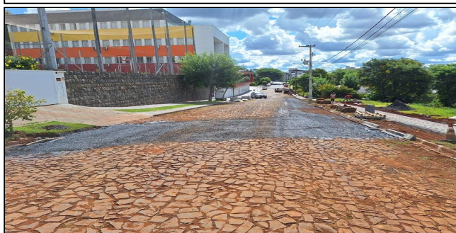
8 | REFORÇO DE BASE E IMPRIMAÇÃO RUA IGUAÇU
