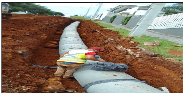
2 | DRENAGEM RUA OLINDO SETTI
