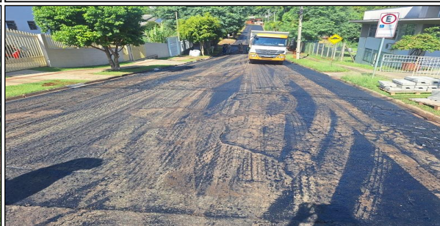
13 | PINTURA DE LIGAÇÃO RUA TEÓFILO A. LOIOLA
