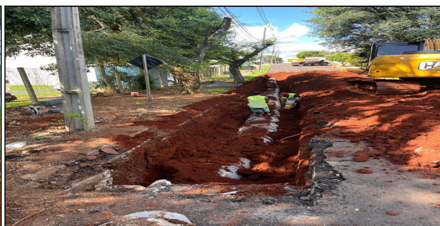
3 | DRENAGEM RUA TEÓFILO A. LOIOLA
