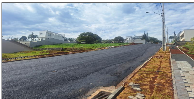
10 | REPERFILSGEM RUA OLINDO SETTI
