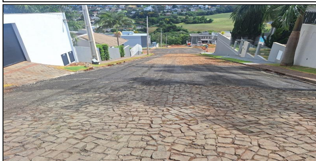
6 | REFORÇO DE BASE RUA OLINDO SETTI
