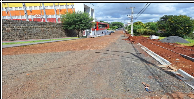
5 | DRENAGEM RUA IGUAÇU
