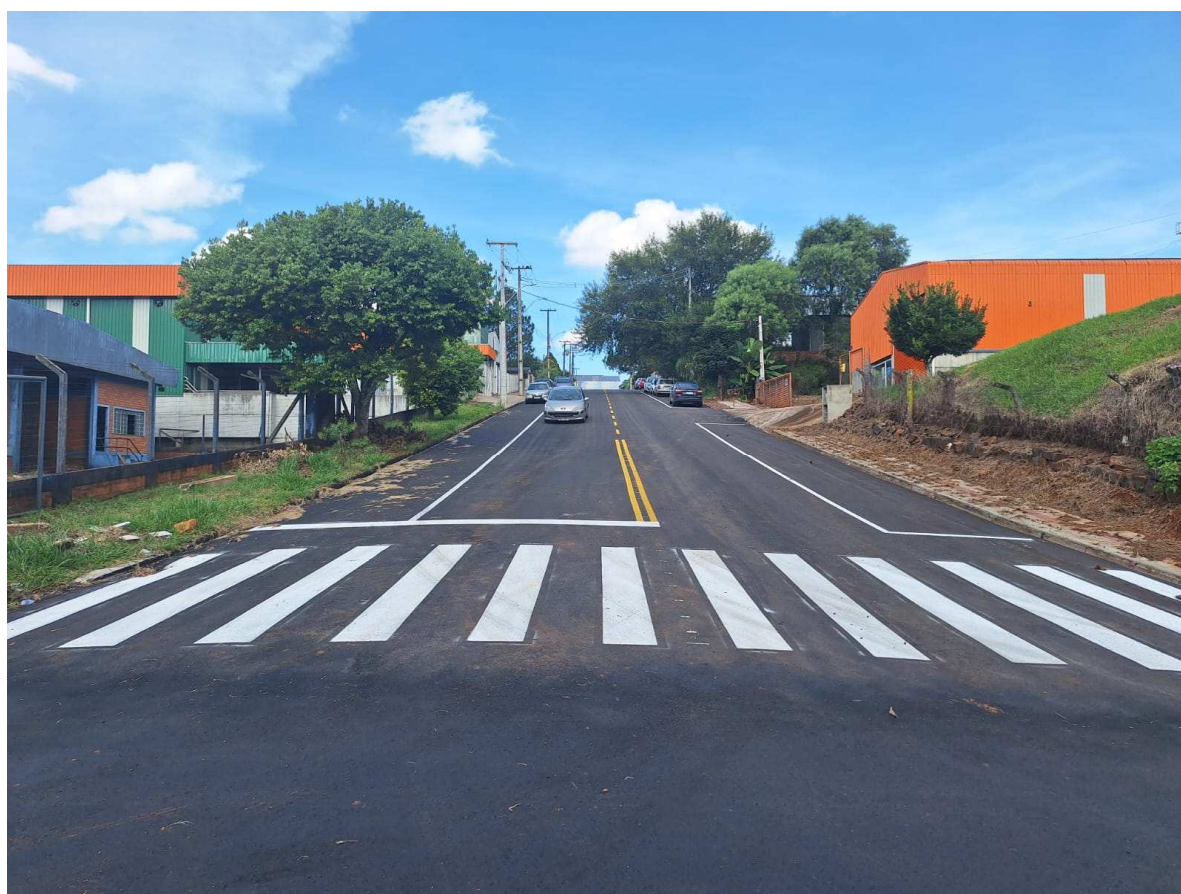
Foto 30: Sinalização Rua Pedro Detoni Trecho 1.
