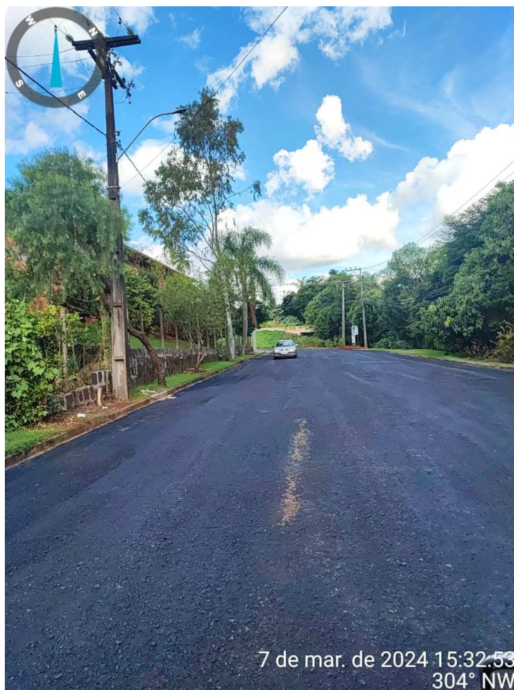
Foto 02: Reperfilagem Rua Getúlio Dal Pasquale Trecho 1.
