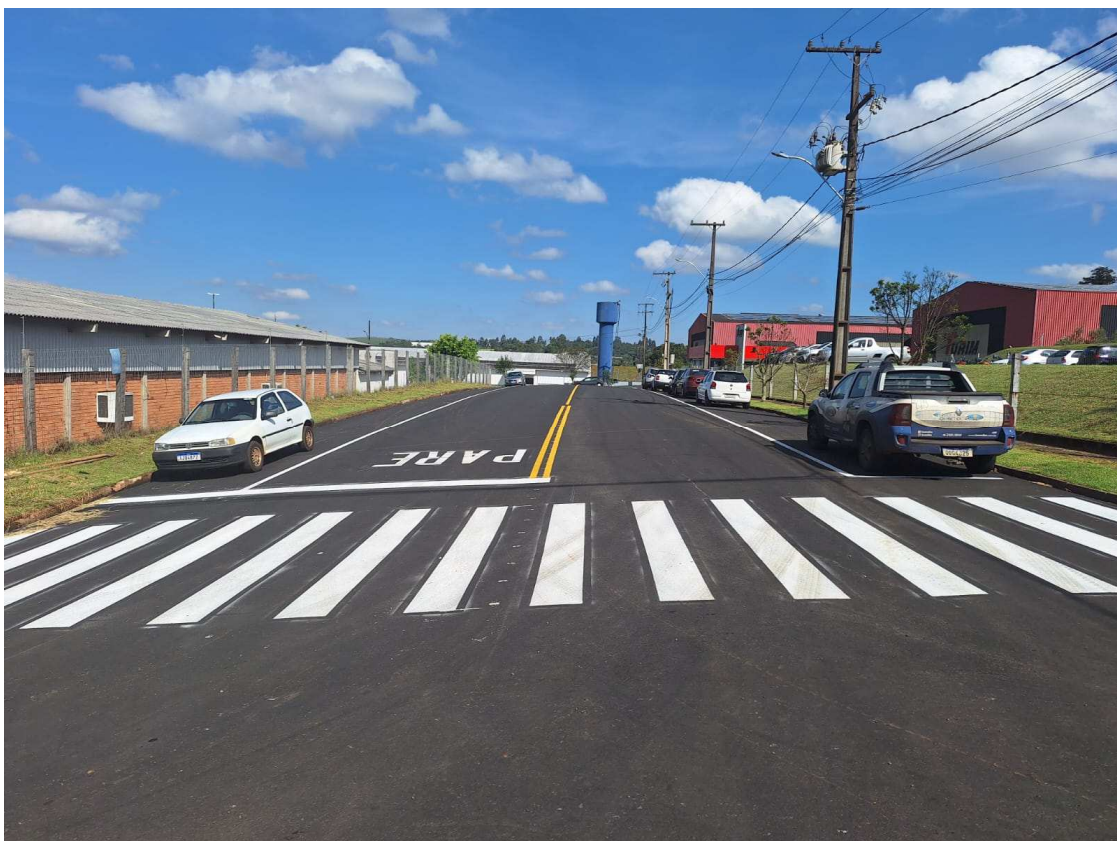
Foto 21: Sinalização Travessa Ademar Cantu.
