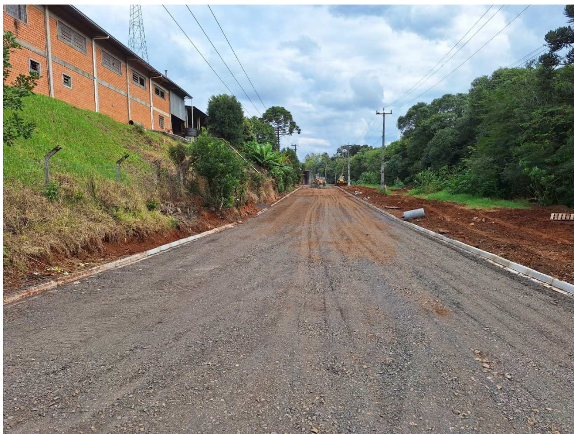
Foto 10: Execução de Base Rua Pedro Detoni Trecho 2.
