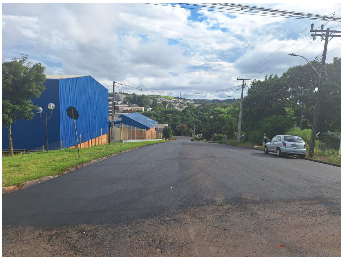
Foto 08: Execução de CBUQ Rua Ulisses Viganó.
