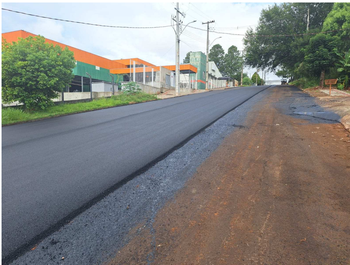
Foto 09: Execução de CBUQ Rua Pedro Detoni Trecho 1.
