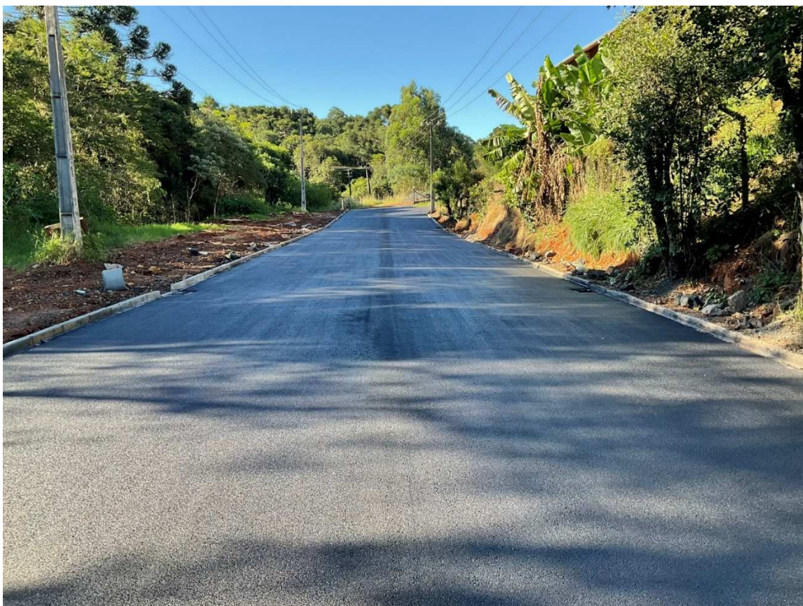
Foto 19: Execução de CBUQ Rua Pedro Detoni Trecho 2.
