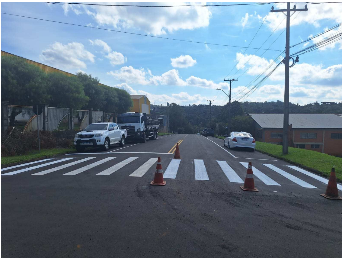
Foto 27: Sinalização Rua Pedro Detoni Trecho 1.
