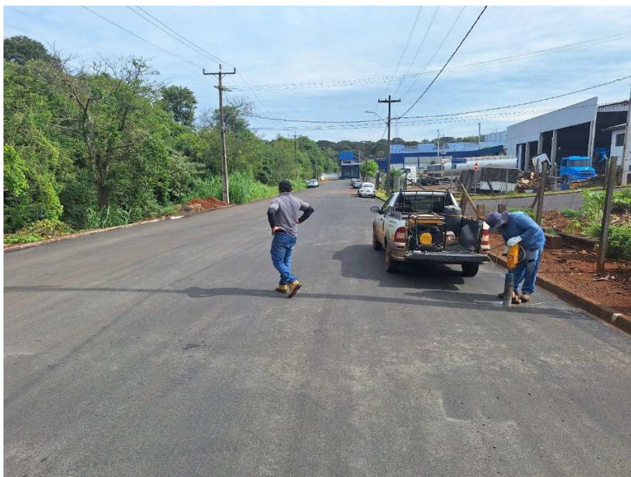
Foto 11: Extração de Corpo de Prova Rua Getulio Dal Pasquale Trecho 1.
