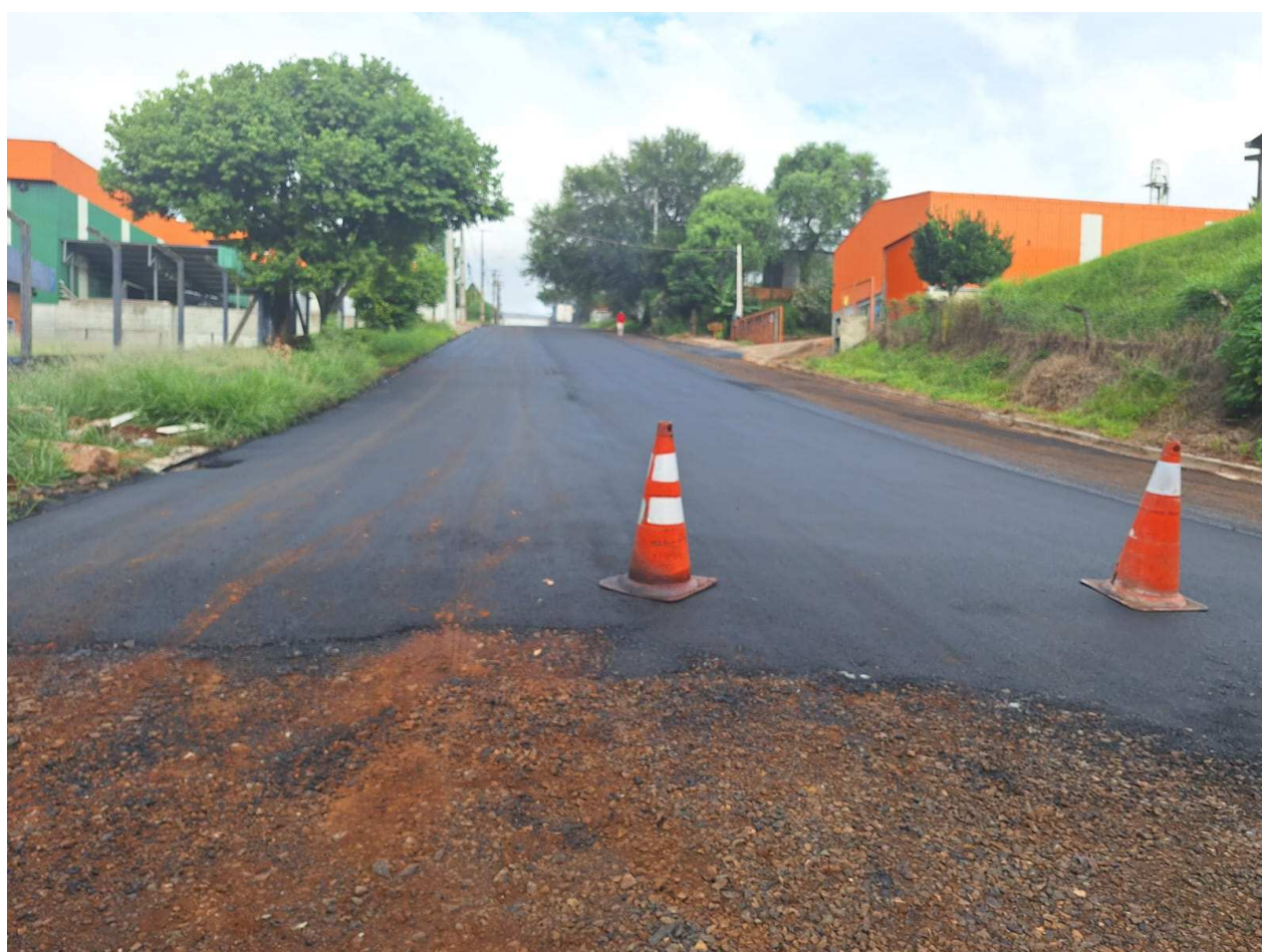
Foto 04: Execução de CBUQ Rua Pedro Detoni Trecho 1.
