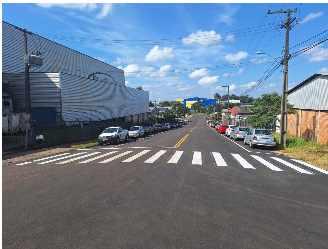
Foto 20: Sinalização Rua Pioneiro Avelino A. Chioquetta.
