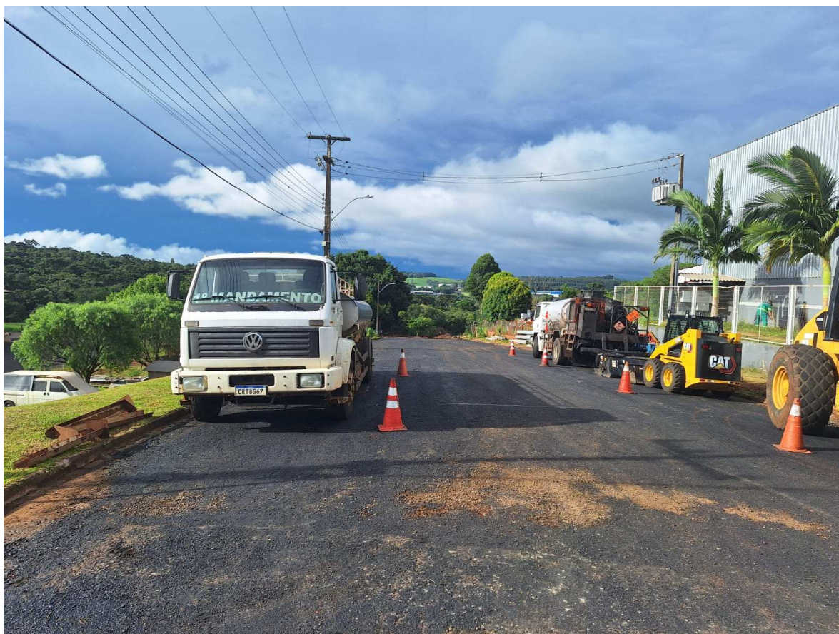
Foto 07: Reperfilagem Rua Ulisses Viganó.
