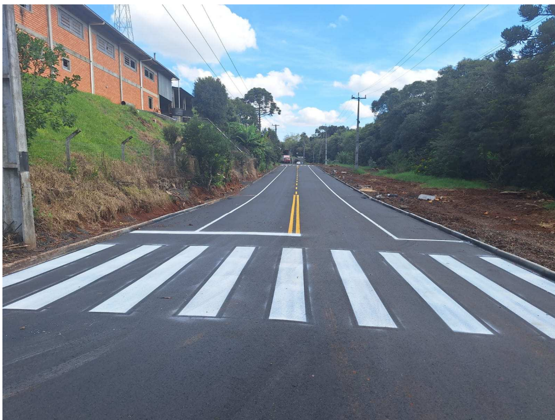
Foto 26: Sinalização Rua Pedro Detoni Trecho 2.
