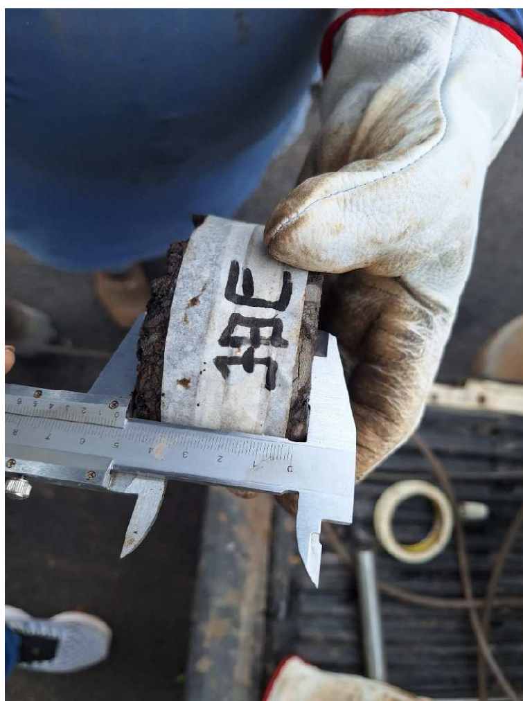
Foto 18: Extração de Corpo de Prova Rua Pedro Detoni Trecho 1.
