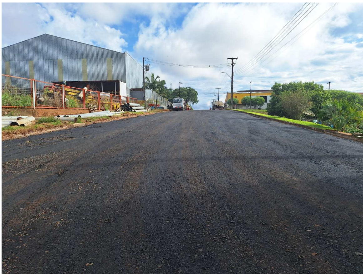
Foto 05: Reperfilagem Rua Ulisses Viganó.
