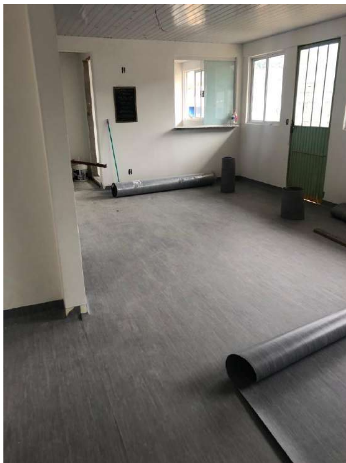
Foto 2: Manta Vinílica e pintura interna.
