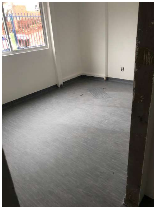
Foto 3: Manta Vinílica e pintura interna.
