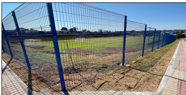
5 | ALAMBRADO E CALÇADA
