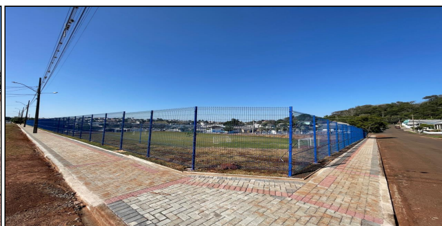
6 | ALAMBRADO E CALÇADA
