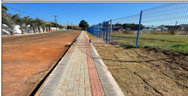
3 | ALAMBRADO E CALÇADA
