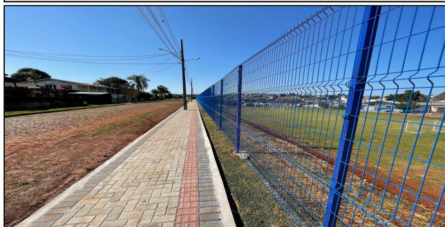
7 | ALAMBRADO E CALÇADA
