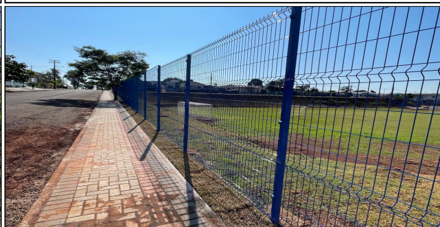
4 | ALAMBRADO E CALÇADA
