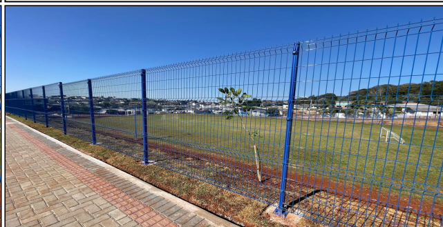
8 | ALAMBRADO E ARVORES
