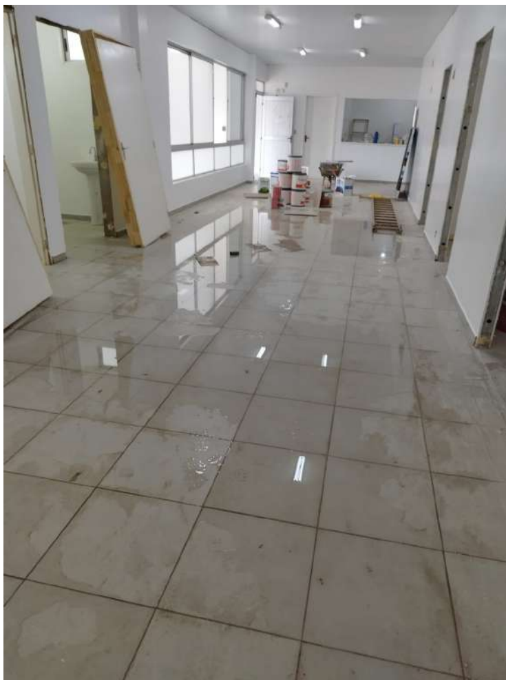
Foto 2: Remoção de portas.
