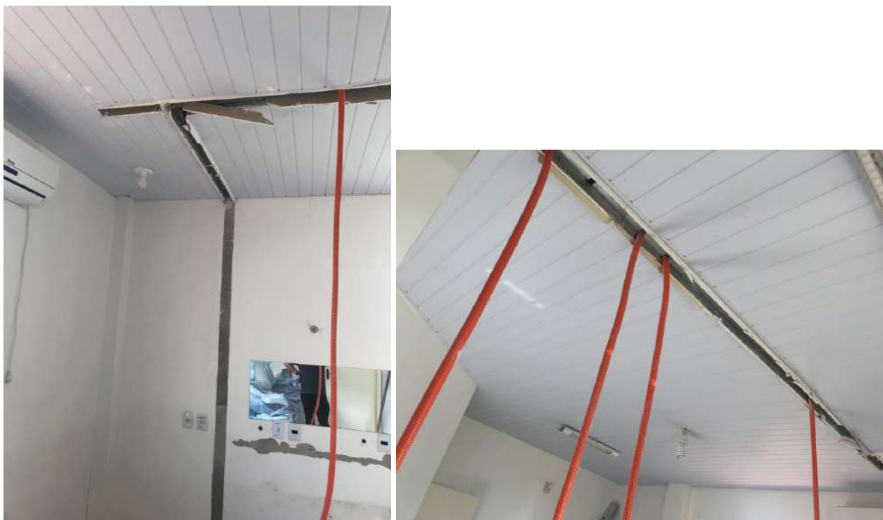
Foto 3: Remoção de forro e de parede.
