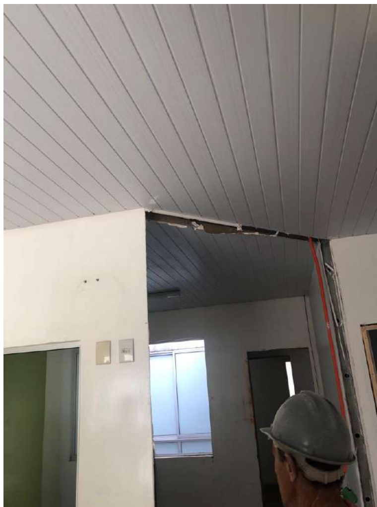
Foto 4: Abertura de portas em parede drywall.
