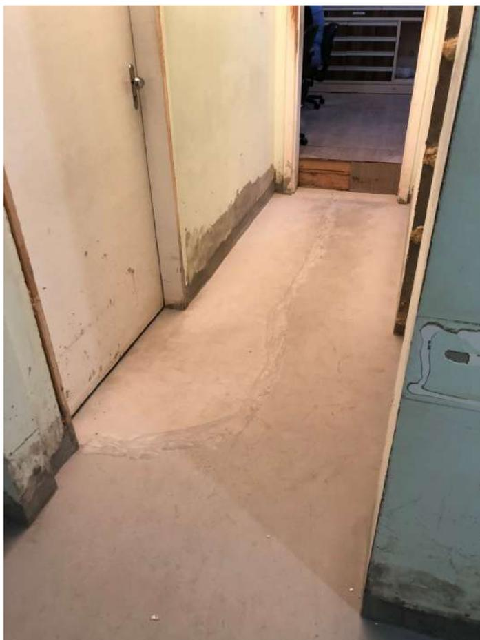
**Foto 3: Regularização do piso e remoção das portas**
