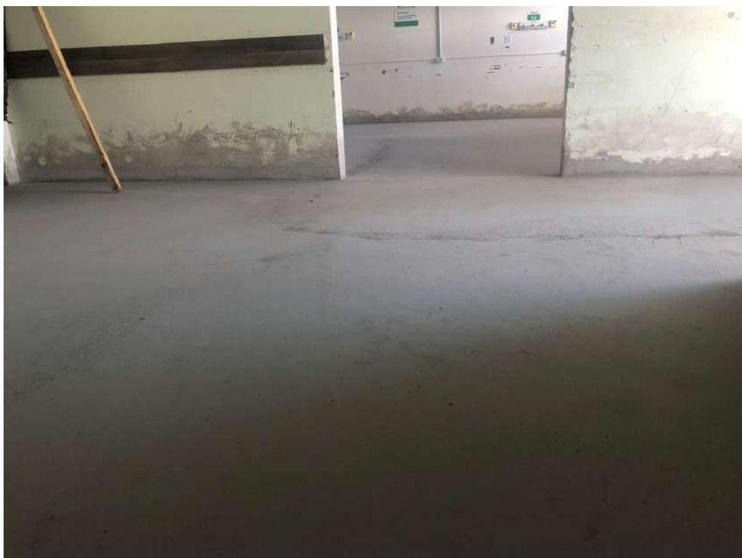
**Foto 3: Regularização do piso e remoção das portas**
