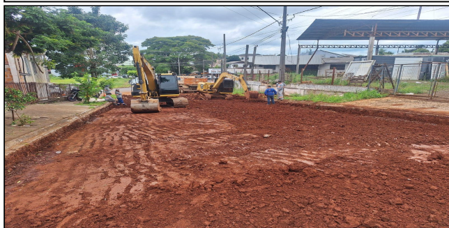
8 | Escavação e Compactação
