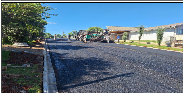
13 | Meio fio e Pintura de Ligação
