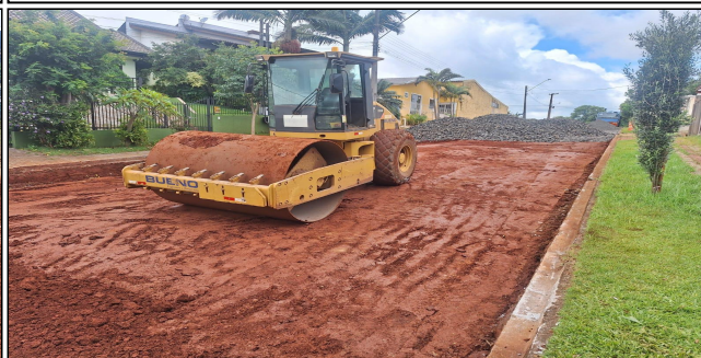
9 | Escavação e Compactação
