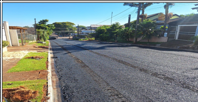
14 | Meio Fio Pintura de Ligação
