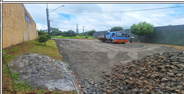
8 | Execução da Base e Sub-base
