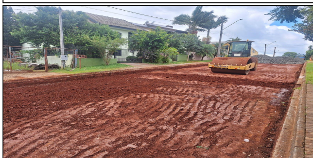
10 | Escavação e Compactação
