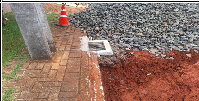
10 | Execução da Base e Sub-base
