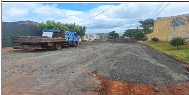
9 | Execução da Base e Sub-base
