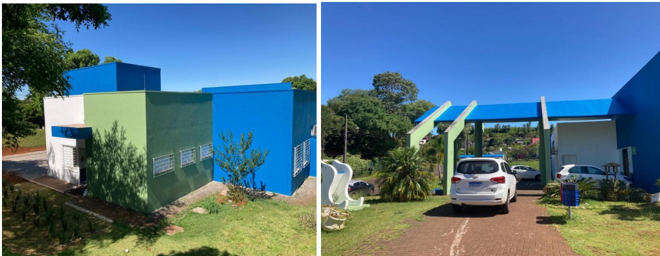
Foto 3: Pintura externa da unidade.
