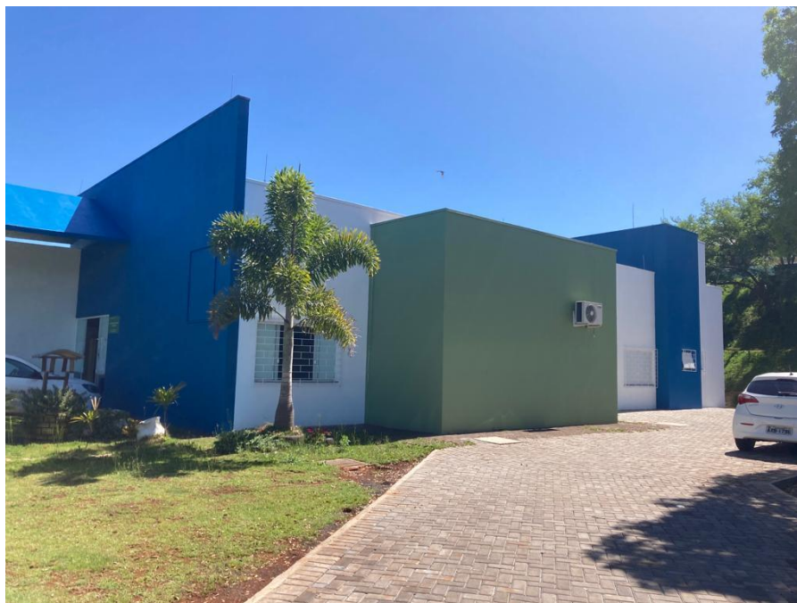
Foto 2: Ampliação do estacionamento
