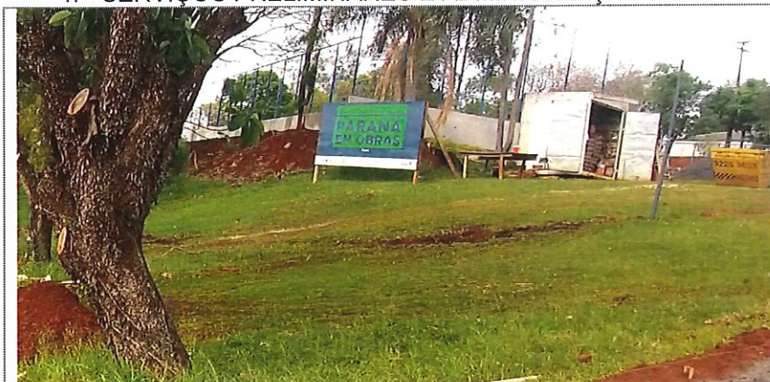
Placa de obra e container para barracão de obra
