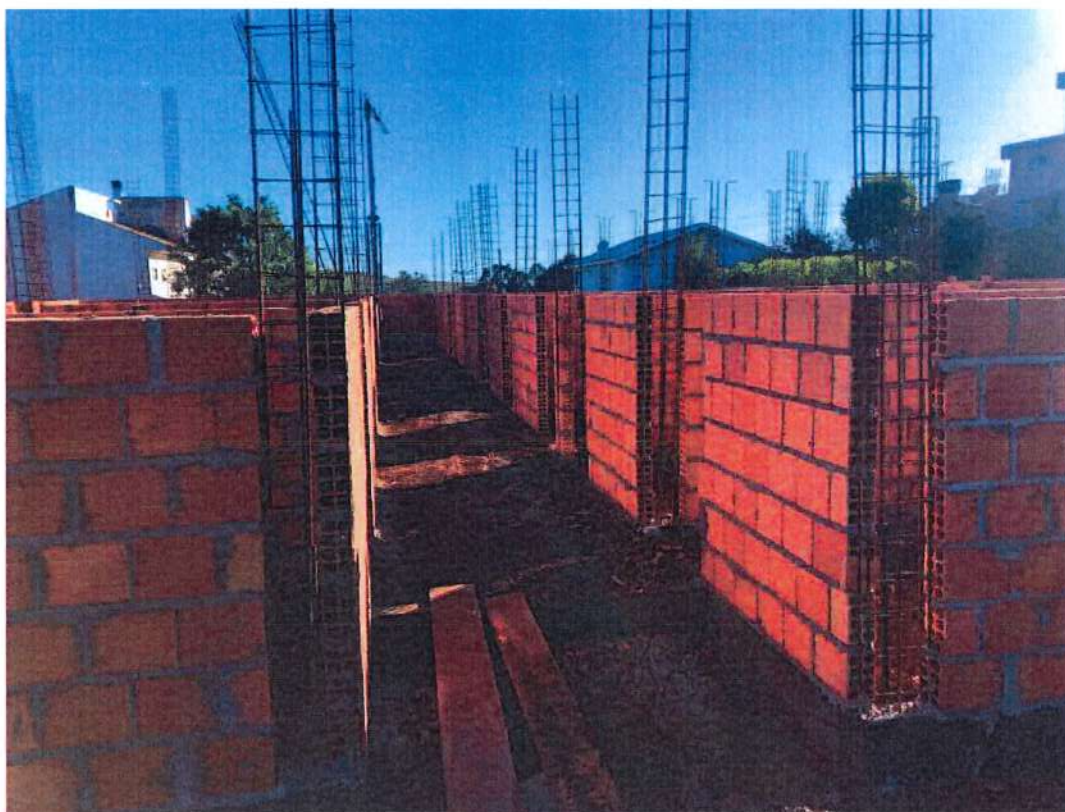
Foto 3: Alvenarias e armação dos pilares.
