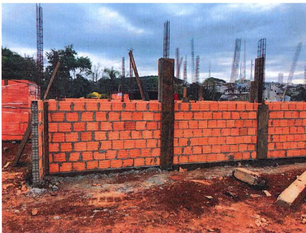
Foto 4: Formas e concretagem dos pilares.
