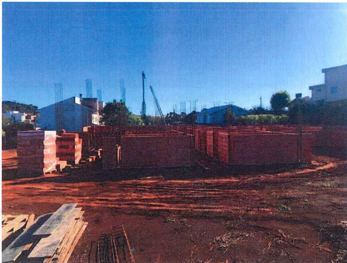
Foto 2: Levantamento de Alvenarias.
