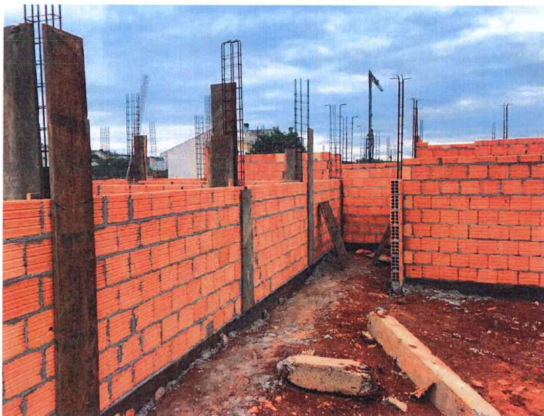
Foto 5: Formas e concretagem dos pilares.
