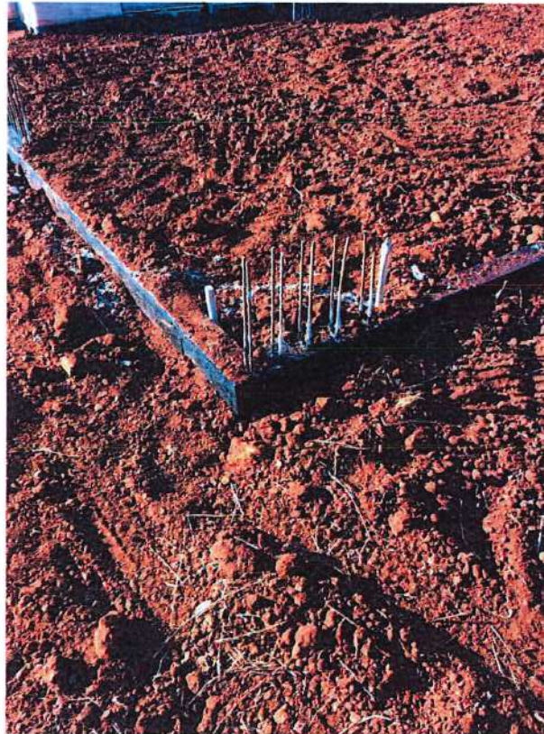
Foto 1: Reaterro e impermeabilização das vigas baldrames.
