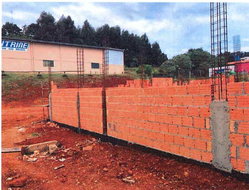
Foto 6: Formas e concretagem dos pilares.
