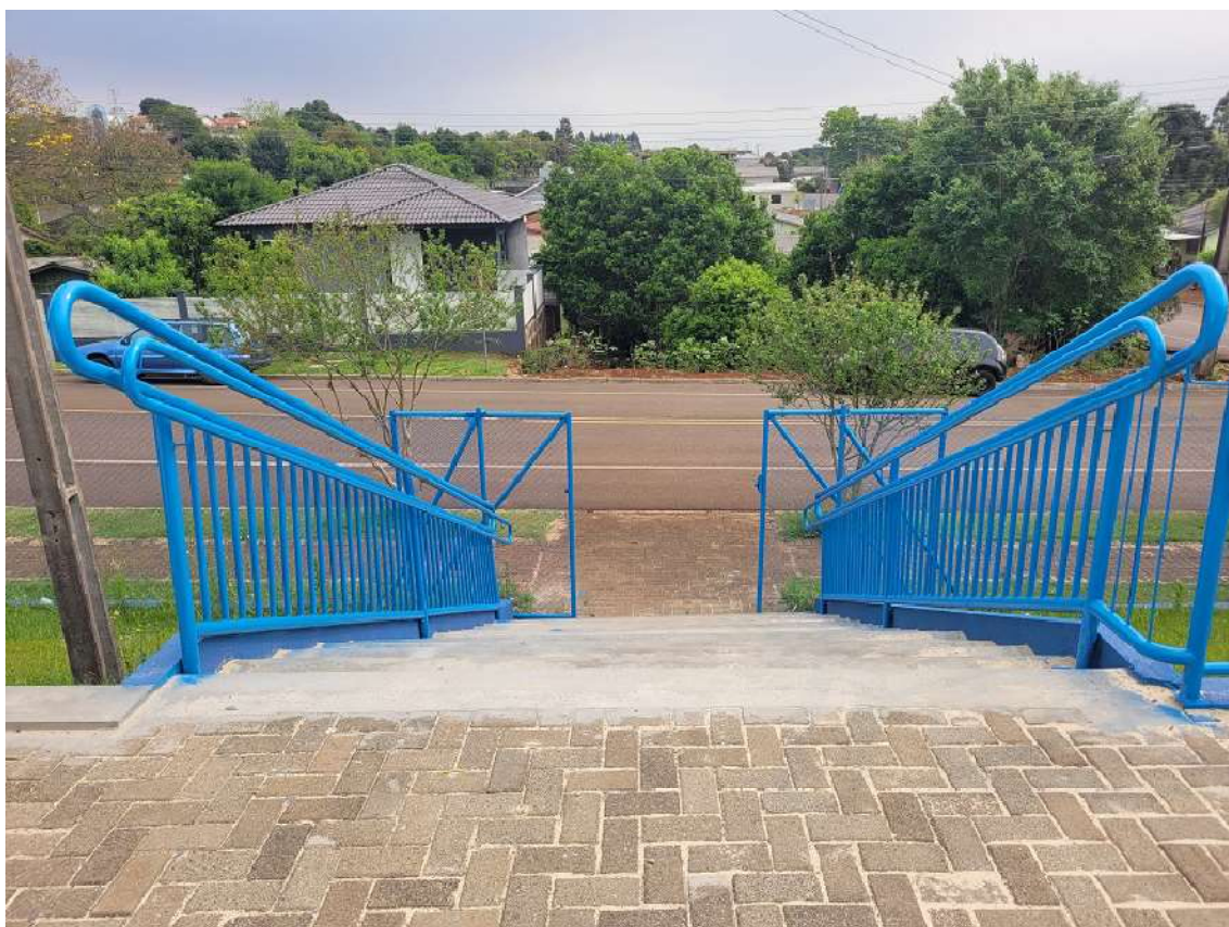
Foto 3: Guarda-corpo nas escadas.
