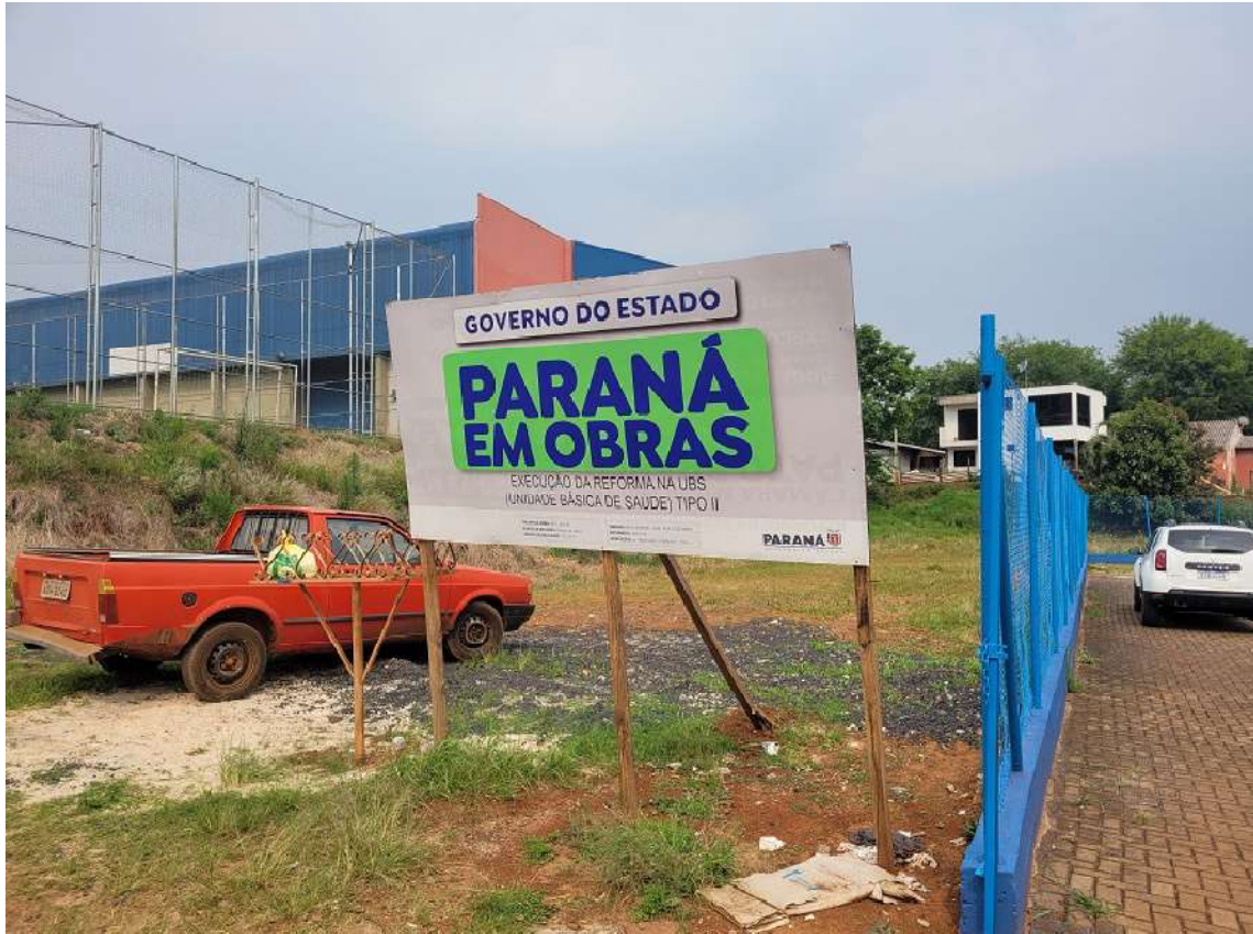
Foto 1: Placa da Obra.
