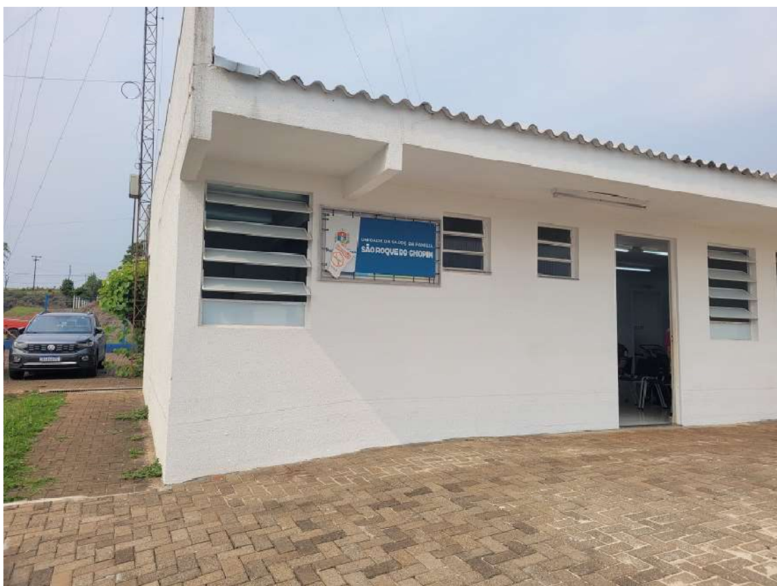
Foto 4: Pintura externa e pavimentação com blocos intertravados.
