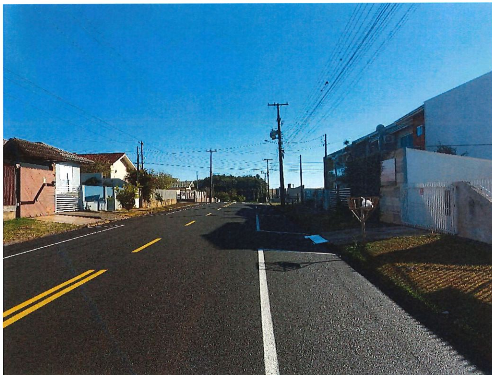
Foto 02: Rua Urbano Wittmann – vista 01
