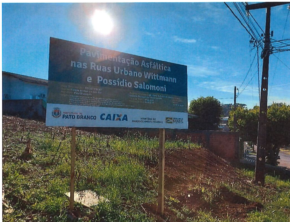
Foto 01: Placa da Obra
