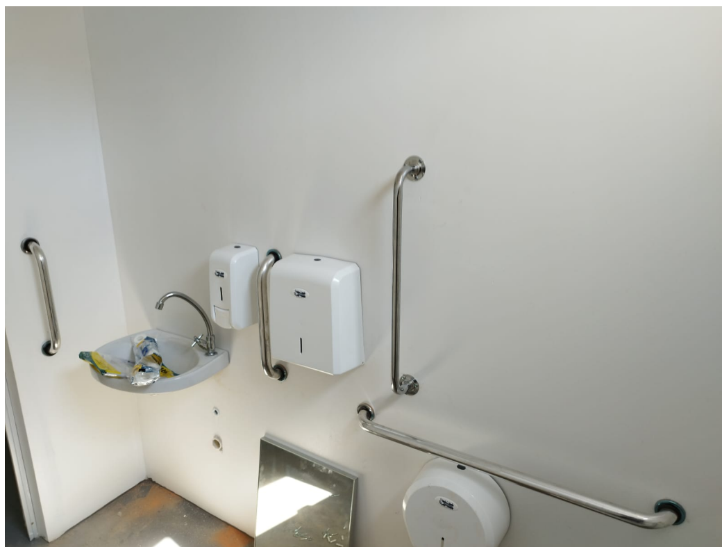
Foto 2: Louças e Metais do Banheiro PCD.
