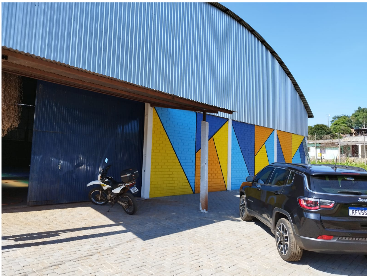
Foto 5: Pintura porta de ferro, pintura externa, troca de telhas e pavimentação externa.
