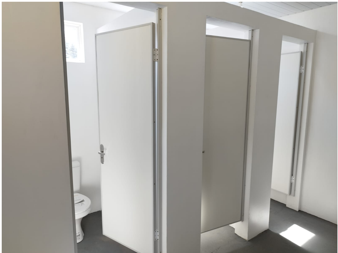
Foto 8: Pintura Interna e portas em banheiros
