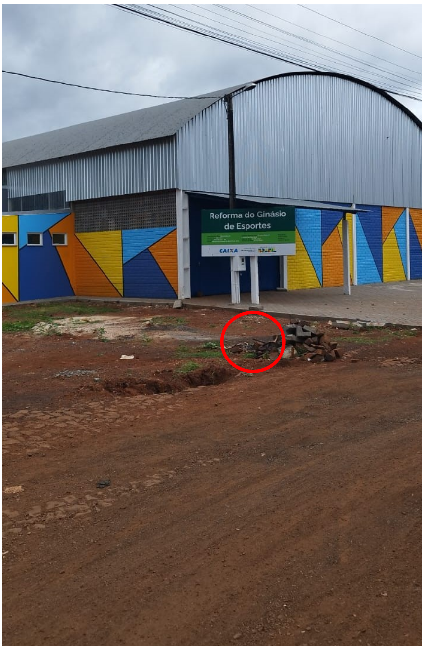
Foto 9: Ponto de esgoto.
