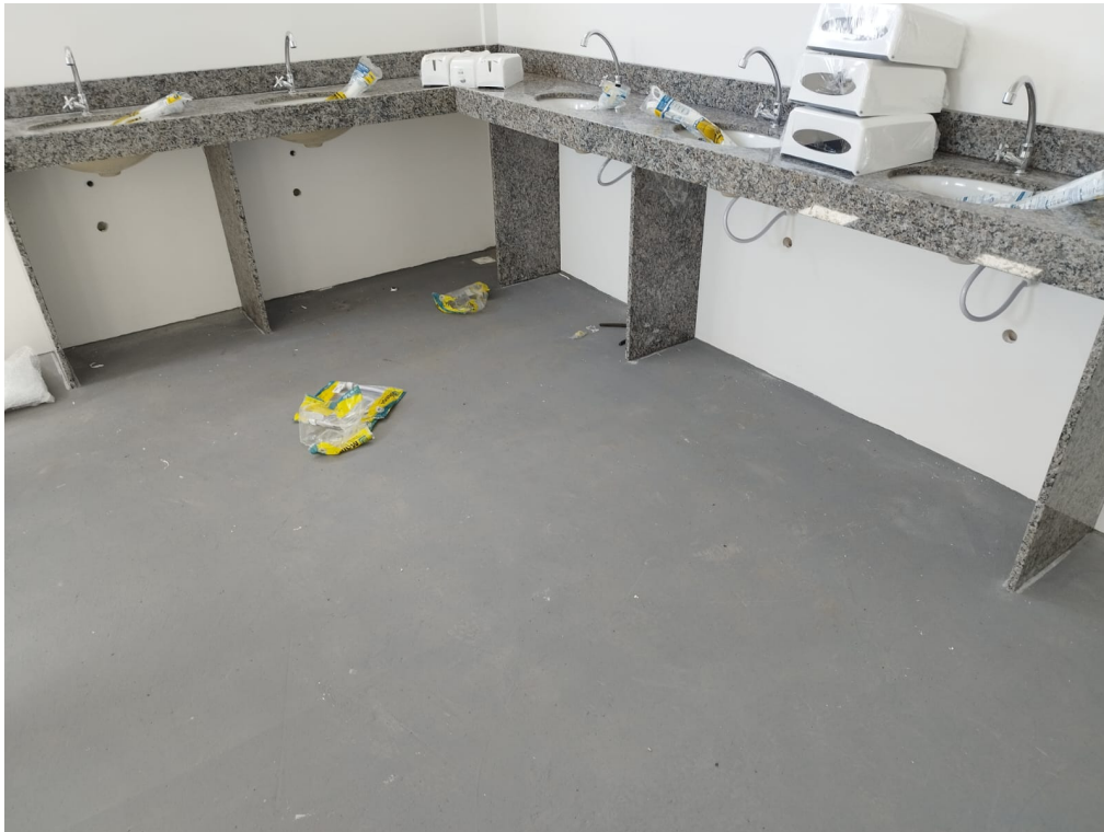
Foto 3: Louças e Metais do Banheiro PCD.
