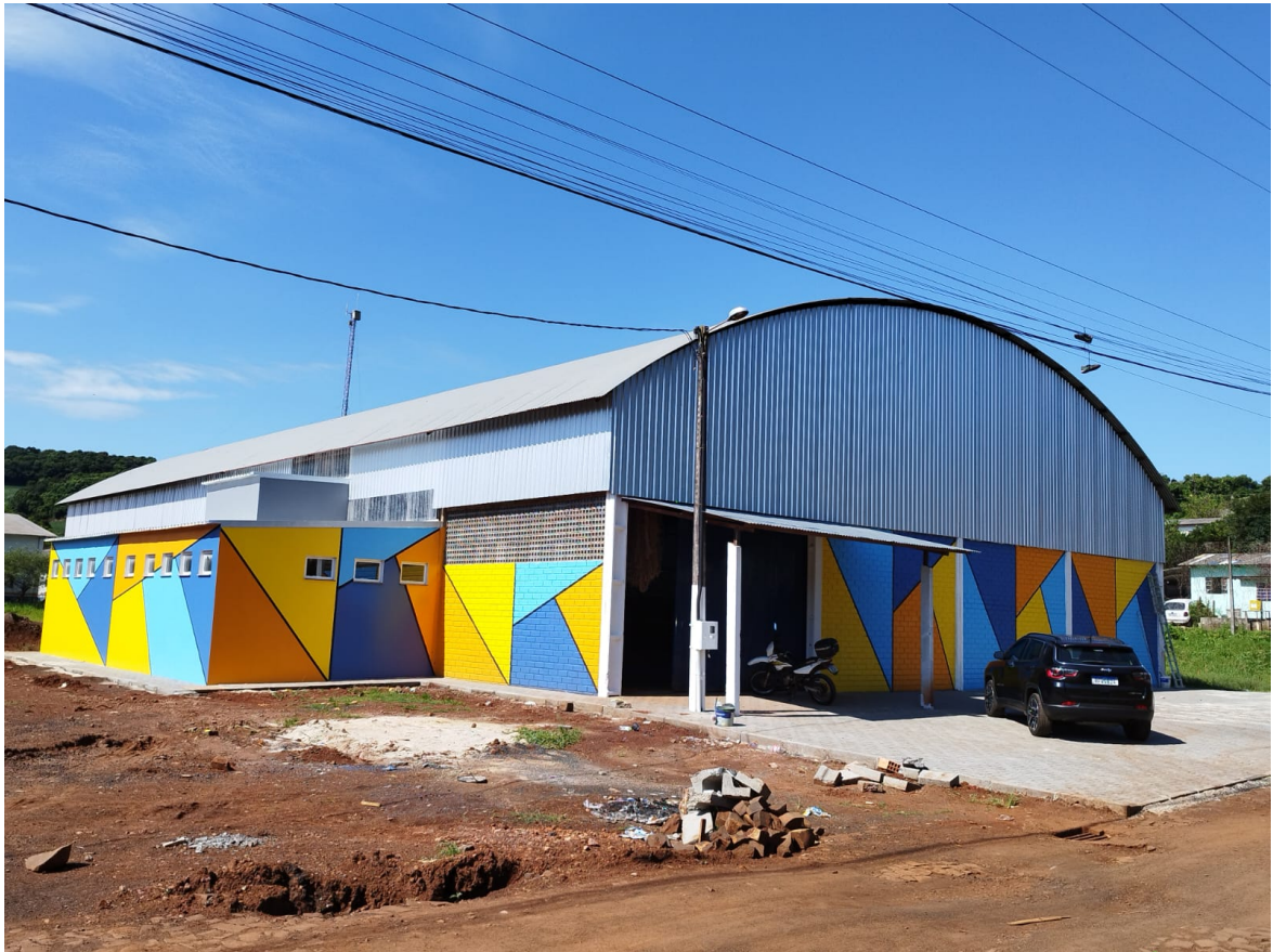
Foto 7: Pintura Externa e pavimentação externa.
