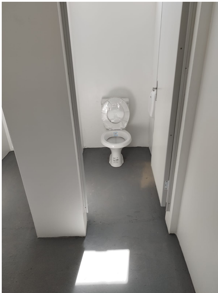
Foto 4: Louças e Metais do Banheiro.
