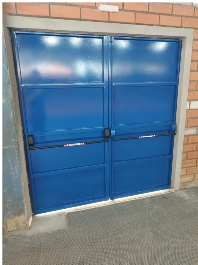
Foto 6: Pintura porta de ferro. (Saída de emergência)
