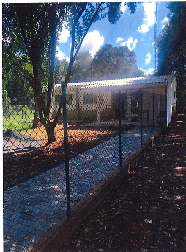
Foto 1: cobertura em telha de fibrocimento, pilares em concreto armado.
