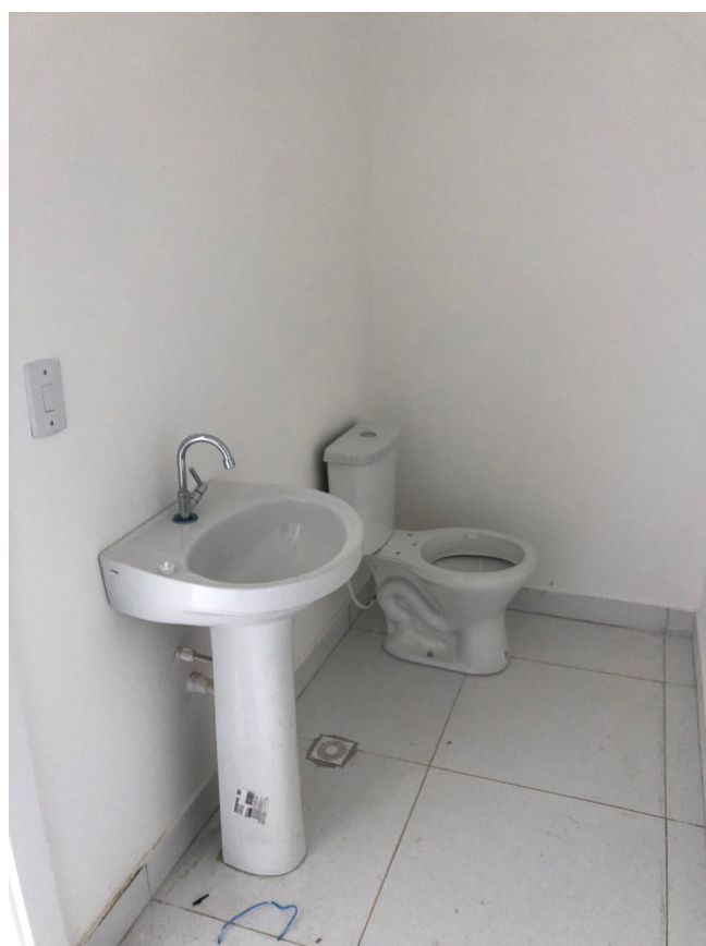
Foto 2: Banheiros. Vaso sanitário, pias).
