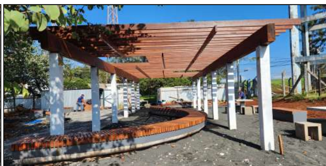
5 | banco de concreto, pergolado, instalações elétricas
