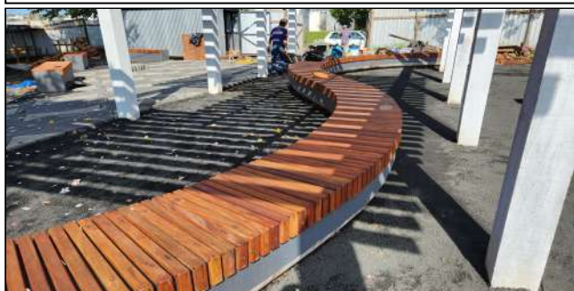
16 | banco de concreto
