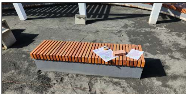
12 | base para piso permeável, banco de concreto
