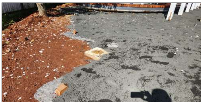
4 | base para piso permeável, instalações elétricas
