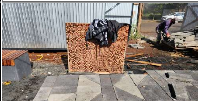
9 | mureta do lavatório
