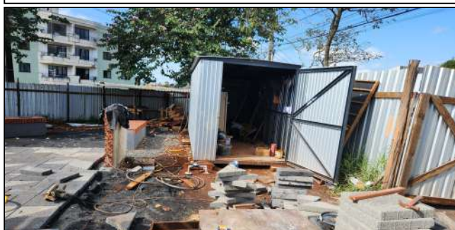
18 | container, mureta do bebedouro, sumidouro
