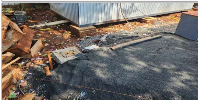
8 | base para piso permeável, instalações elétricas
