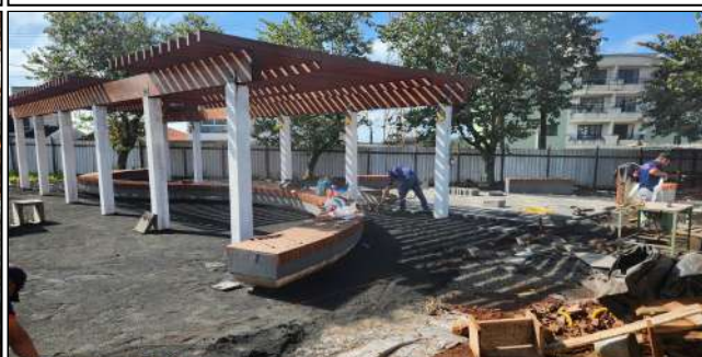
11 | bancos de concreto, pergolado, piso permeável, instalações elétricas
