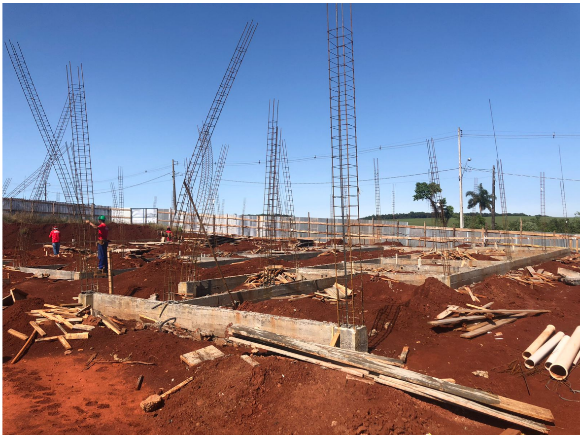
Foto 6: Baldrame e armação de pilares.
