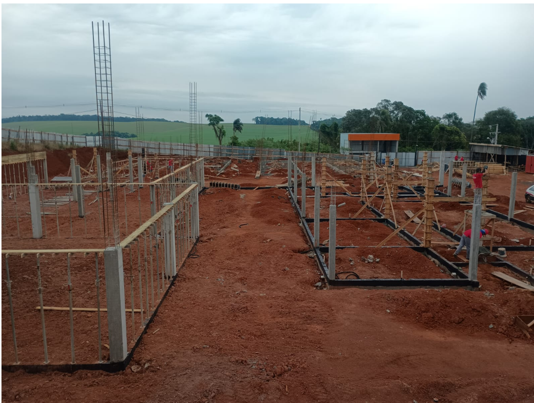
Foto 2: Imagem panorâmica da Obra.
