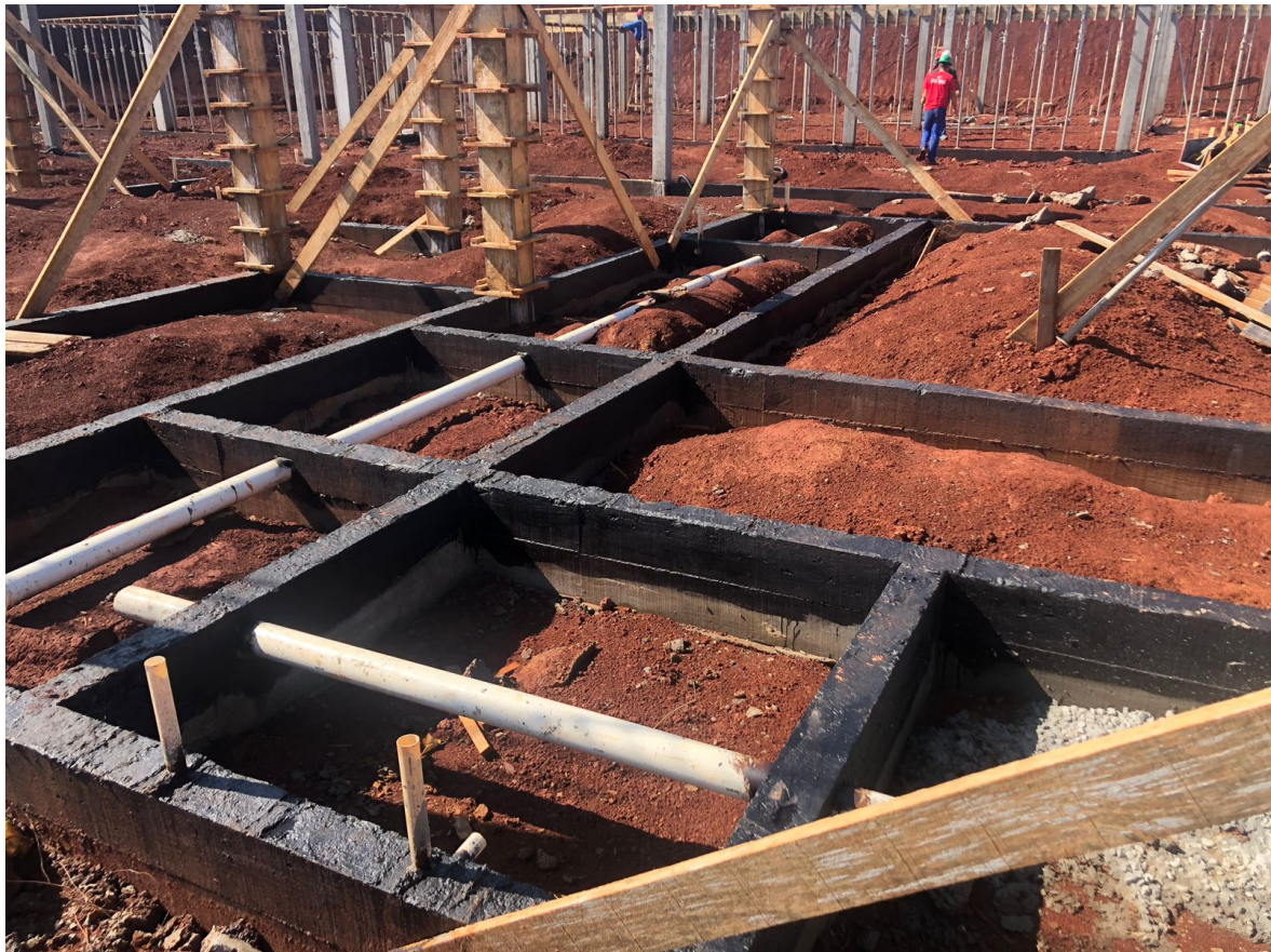
Foto 5: Baldrame e Tubulações de esgoto.
