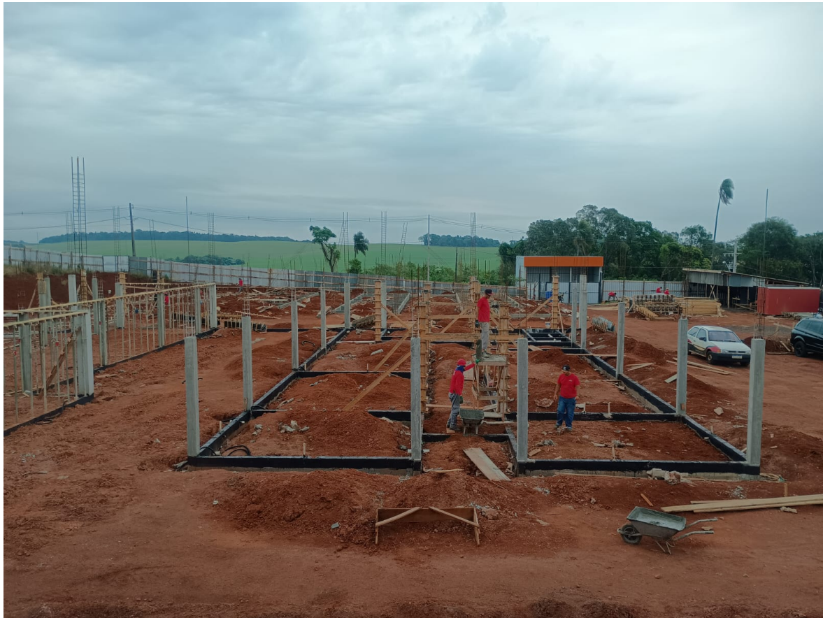
Foto 3: Pilares, vigas baldrame impermeabilizadas e reaterro.
