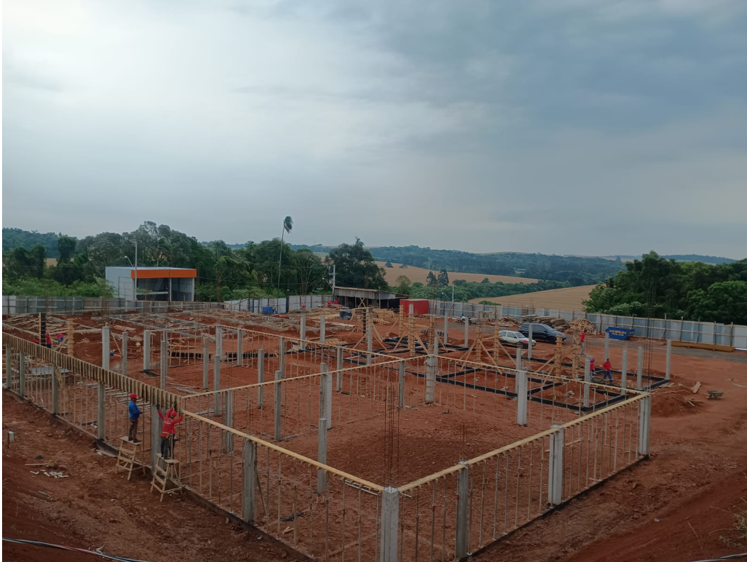
Foto 1: Imagem panorâmica da Obra.
