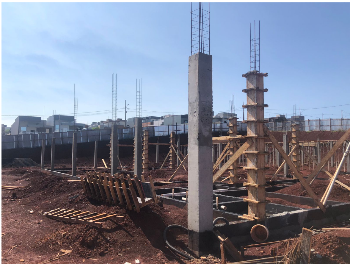
Foto 4: Pilares concretados e vigas baldrame impermeabilizadas.
