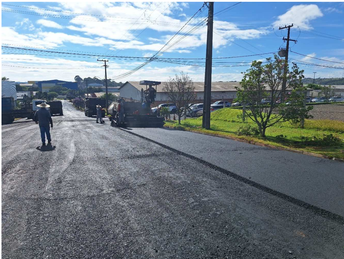
Foto 07: Execução de CBUQ Rua Pioneiro Avelino A. Chioquetta.
