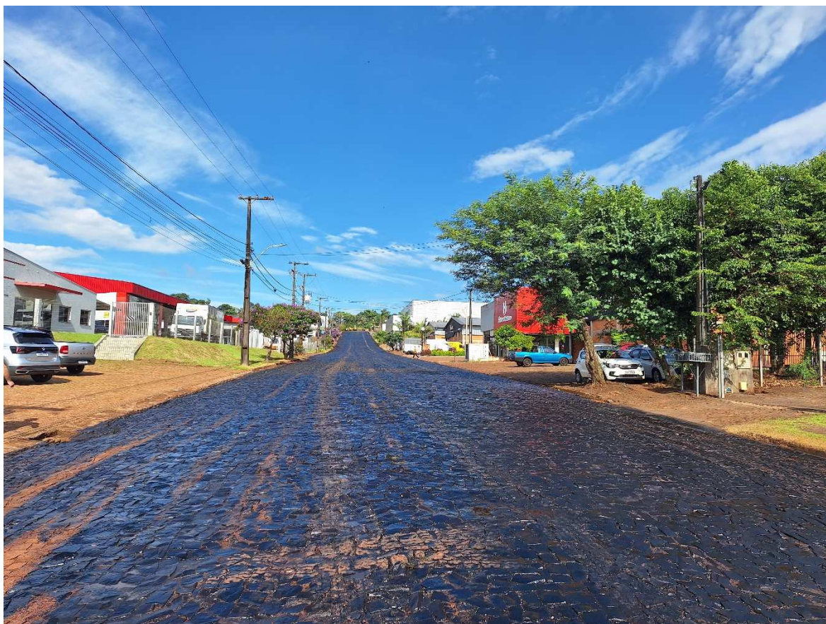
Foto 05: Pintura de Ligação Rua Pioneiro Avelino A. Chioquetta.
