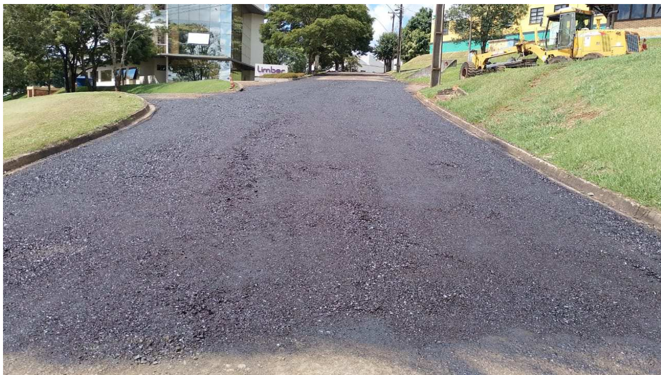
Foto 09: Imprimação Rua C.
