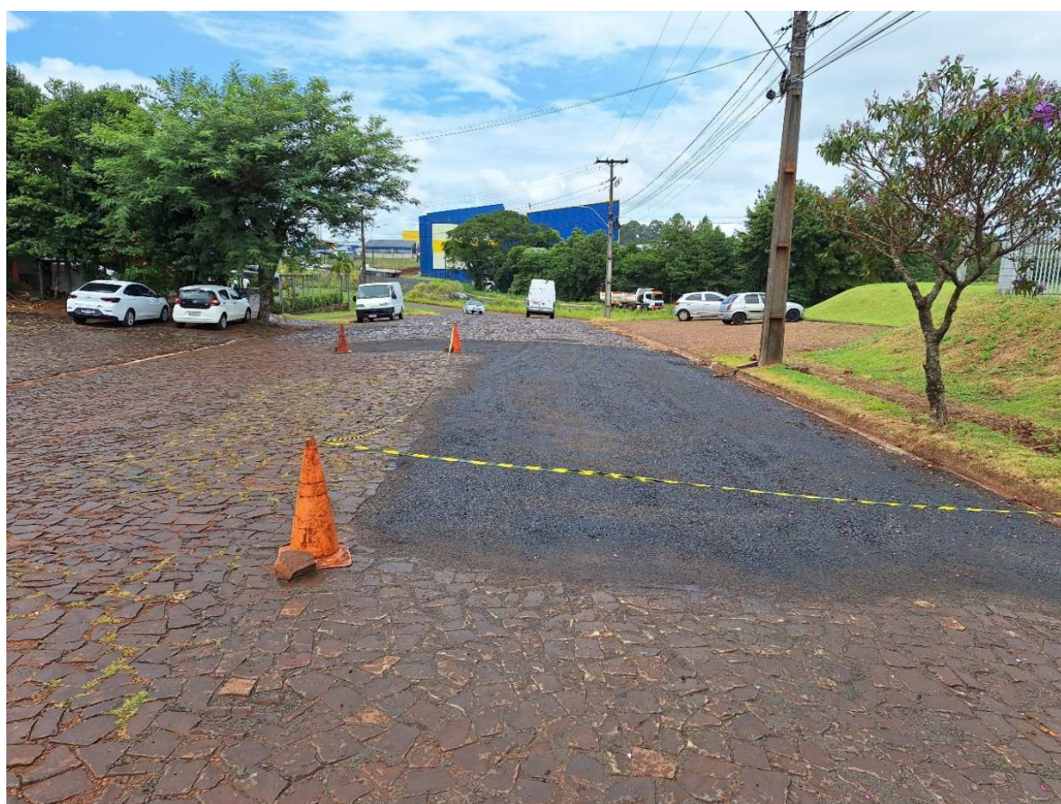
Foto 04: Imprimação Rua Pioneiro Avelino A. Chioquetta.
