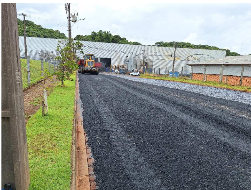
Foto 02: Pintura de Ligação e Reperfilagem Travessa Ademar Cantu.
