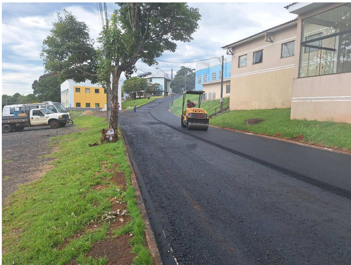
Foto 15: Execução CBUQ Rua C.
