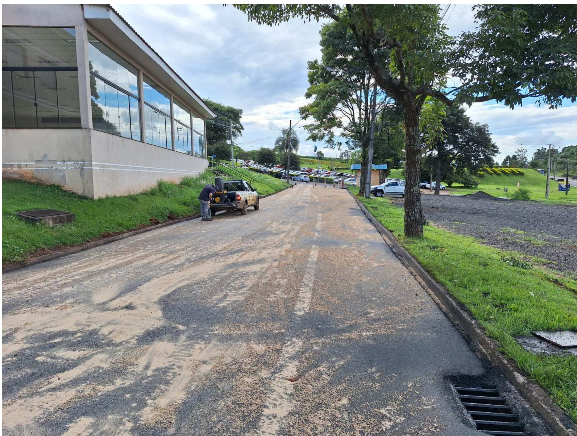
Foto 20: Extração de Corpo de Prova Rua C.
