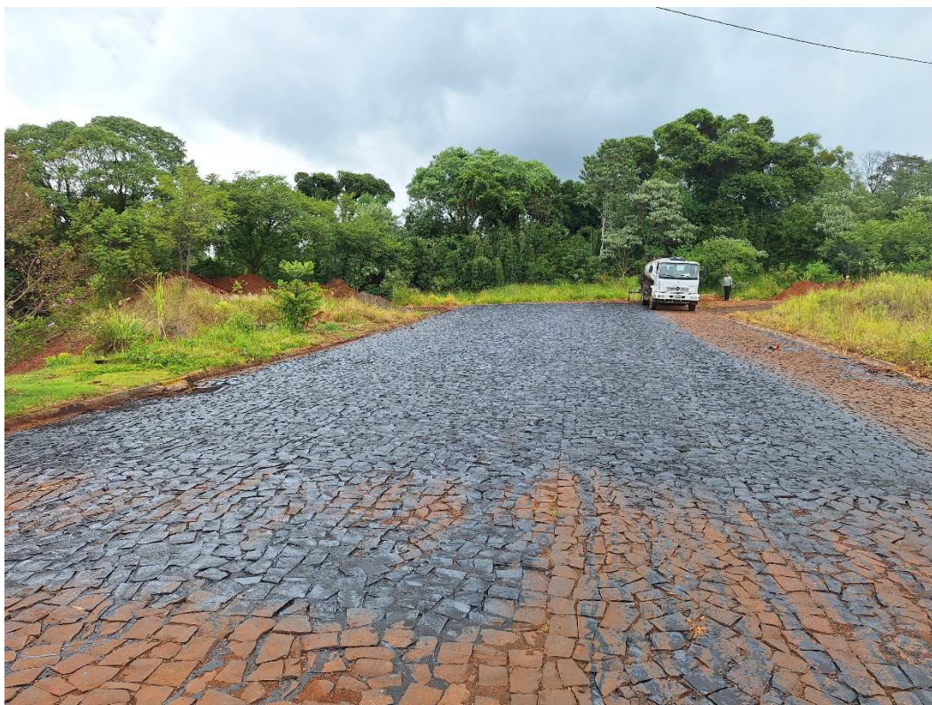
Foto 01: Pintura de Ligação Rua Pioneiro Avelino A. Chioquetta.
