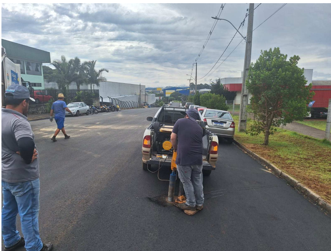
Foto 18: Extração de Corpo de Prova Rua Pioneiro A. A. Chioquetta.
