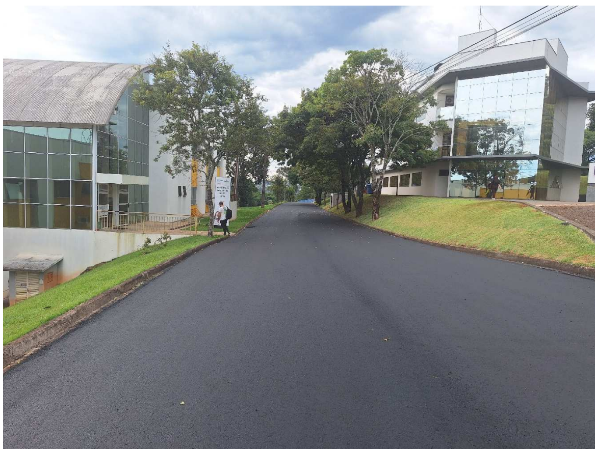
Foto 16: Pavimentação Rua A.
