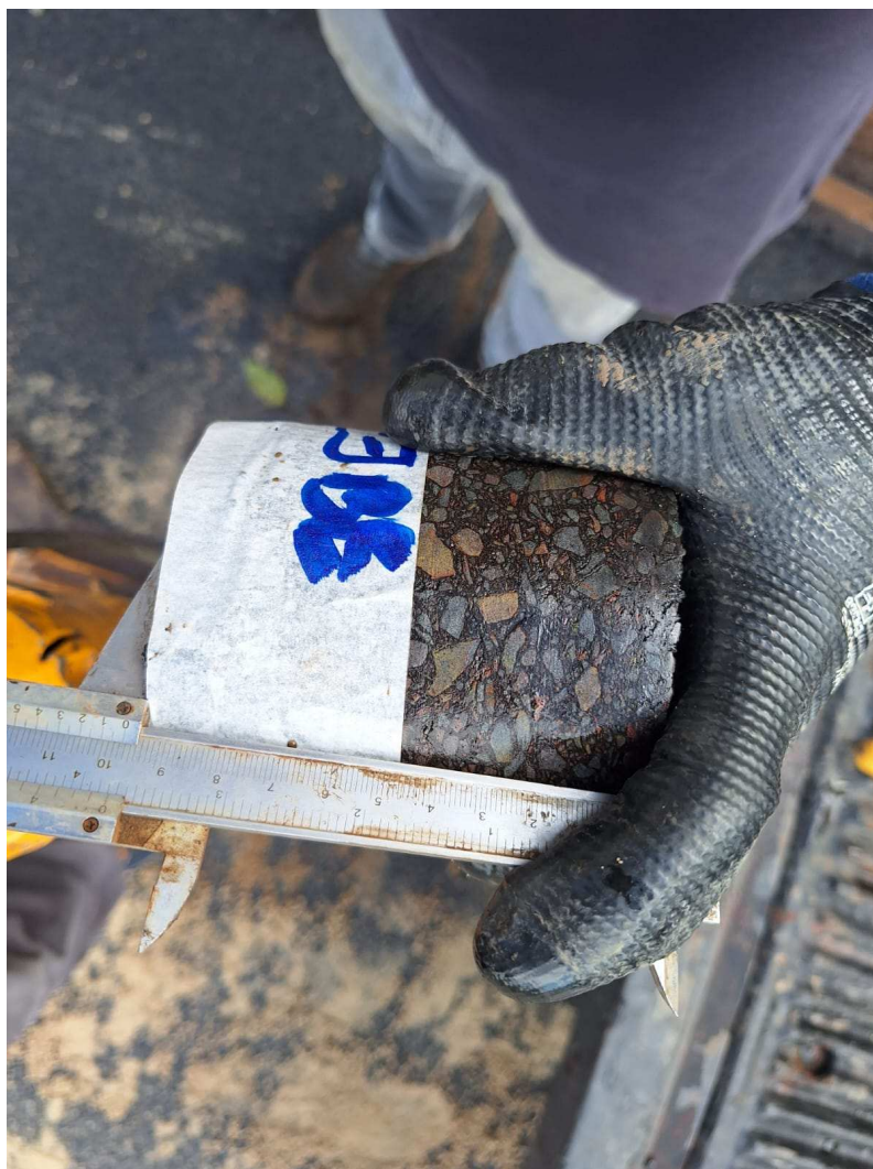
Foto 21: Extração de Corpo de Prova Rua C.
