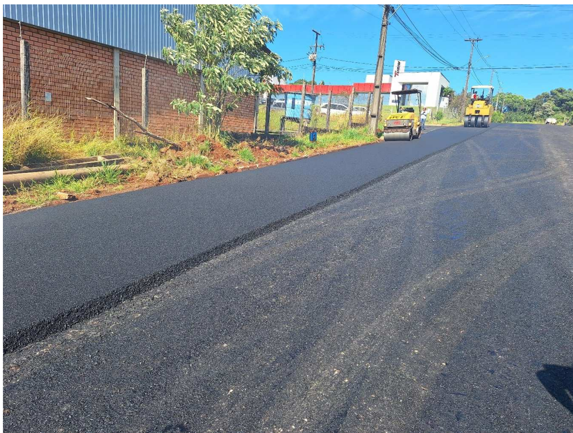
Foto 08: Execução de CBUQ Rua Pioneiro Avelino A. Chioquetta.
