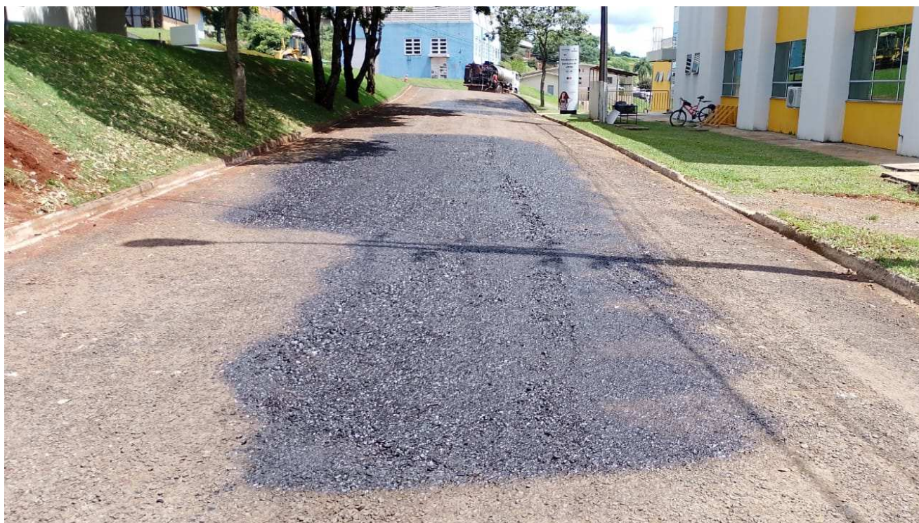
Foto 10: Imprimação Rua A.
