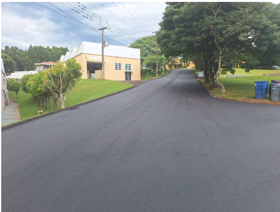
Foto 17: Pavimentação Rua B.
