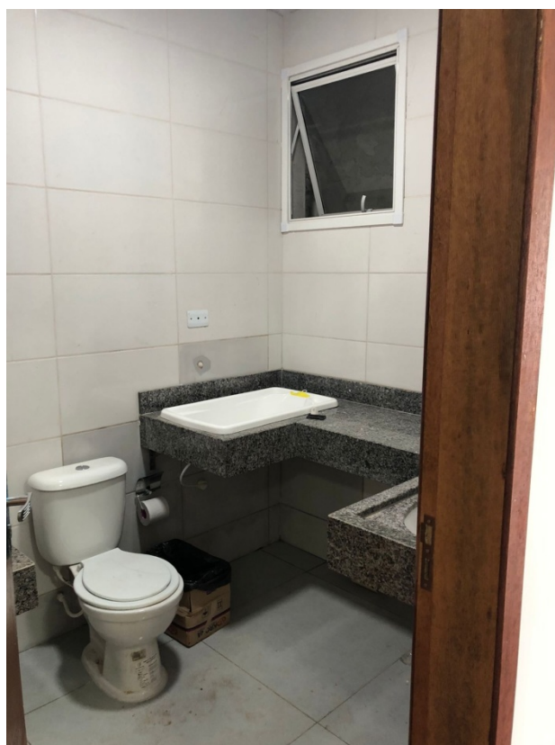
Foto 4: Vaso sanitário com assento. Bancada em granito. Revestimento cerâmico. Janela Basculante.
