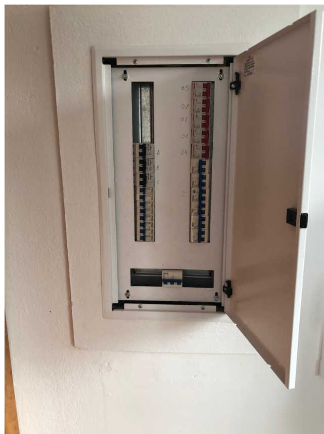
Foto 9: Instalações Elétricas. Disjuntores.
