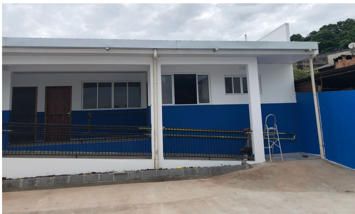
Foto 7: Calhas, Pintura externa, Janelas, Portas.
