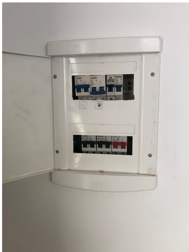
Foto 9: Instalações Elétricas. Disjuntores.
