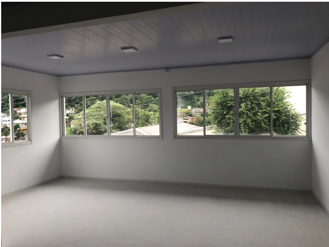
Foto 1: Janelas. Piso Vinílico. Pintura Interna.
