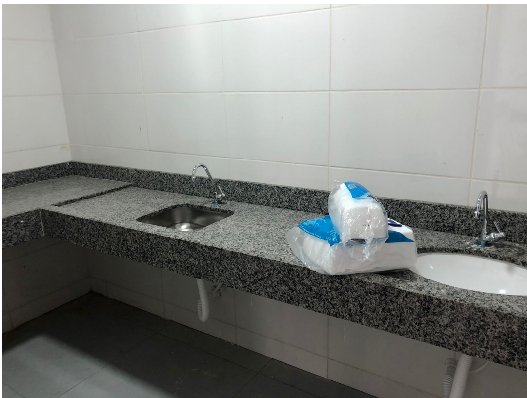
Foto 8: Bancadas em Granito. Cuba de inox. Torneiras e sifão.
