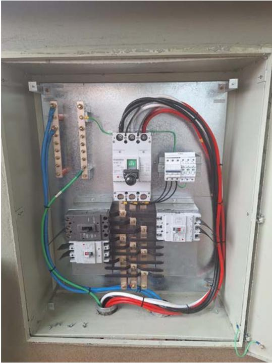
Figura 17 – QD-2 vista interna com barramento e disjuntores
