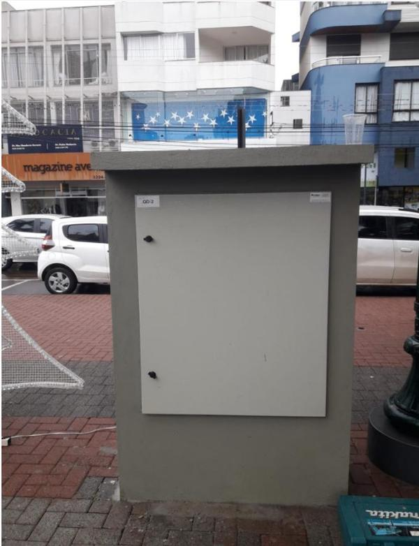
*Figura 11 – QD-1 Com mureta e caixa com tampa*
