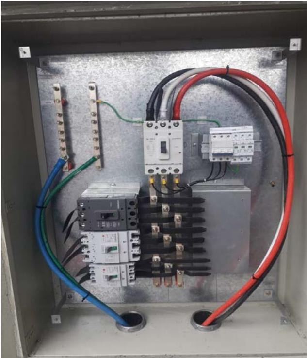
Figura 13 – QD-1 vista interna com barramento e disjuntores
