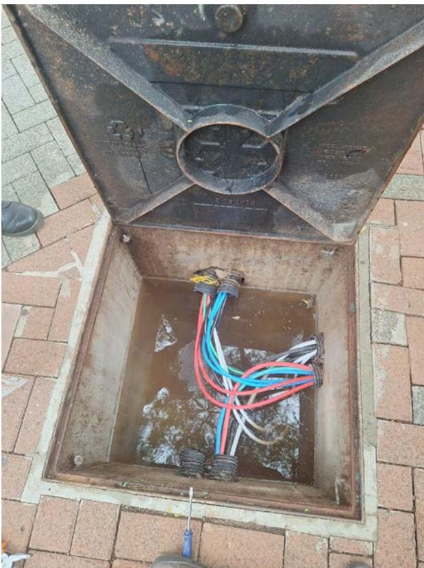
*Figura 10 – Caixa de Passagem Central com cabeamento de derivação para QD-1 e QD-2*
