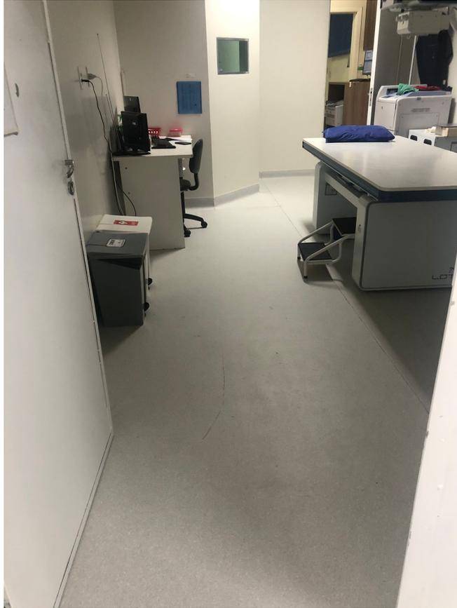
**Foto 1: Manta vinílica instalada Raio-X**
