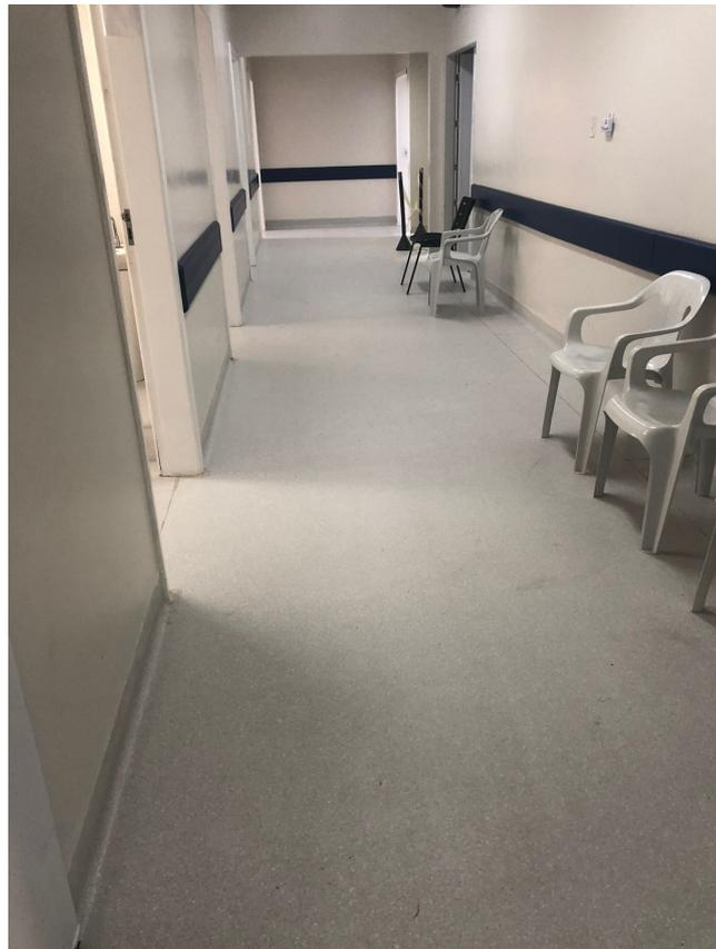
**Foto 2: Manta vinílica e bate-maca instalados.**
