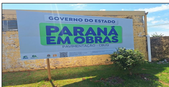
1 | Placa de Obra
