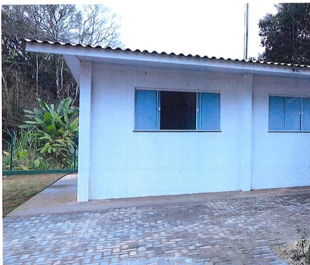
Foto 2: Passeio (calçada) em concreto / Pintura externa.
