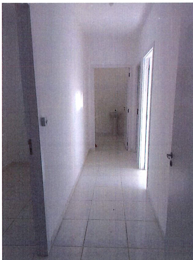
Foto 4: Portas internas / pintura interna / Revestimento cerâmico.
