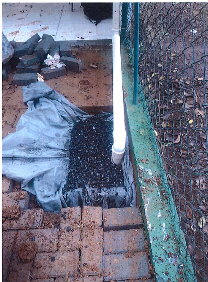
Foto 3: Tubulação de água pluvial.
