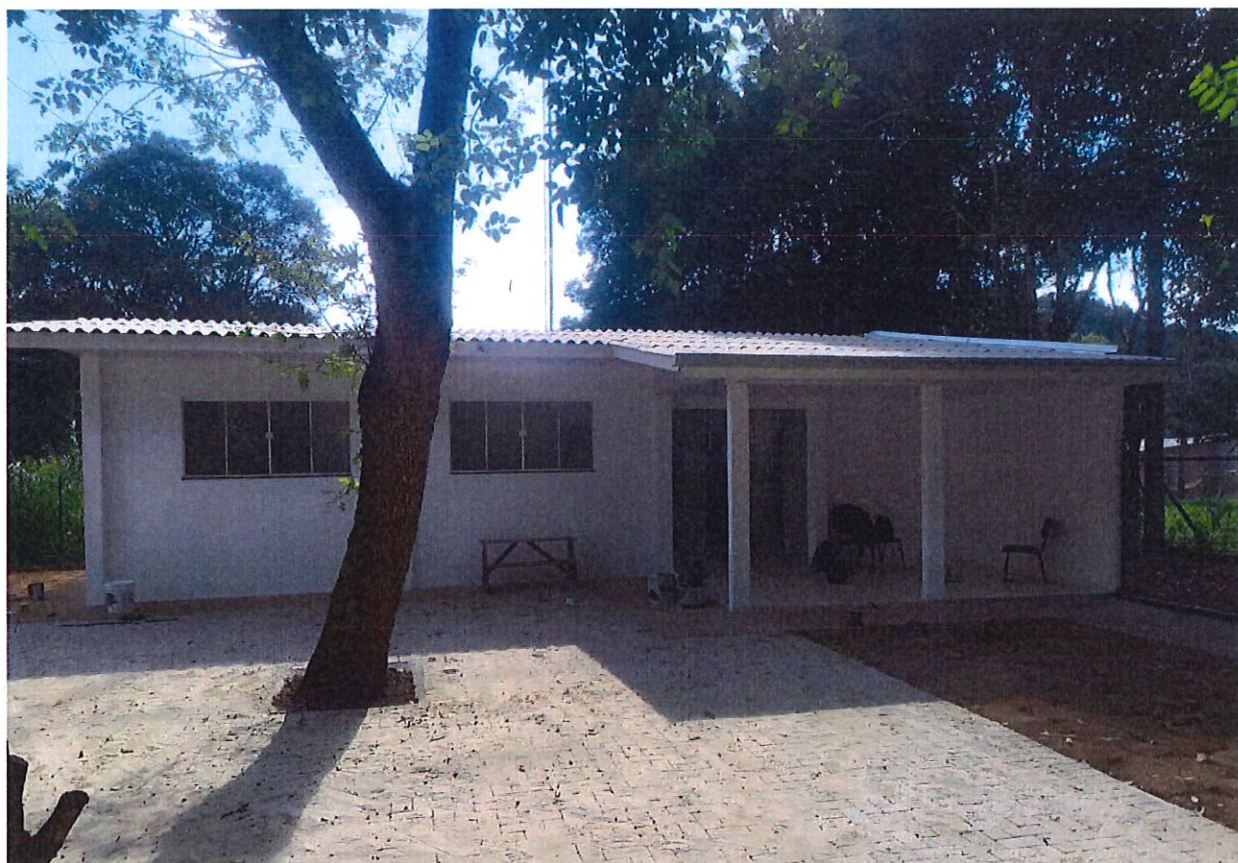
Foto 7: Pintura externa / Paver / Grama / Porta de correr.
