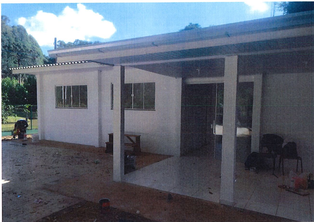
Foto 1: Calha/ piso em concreto/ pintura externa
