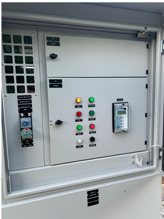
Figura 9 – Chave seccionadora – Visão Frontal.
