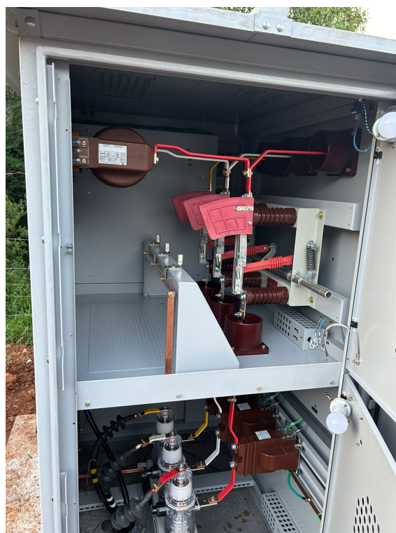
Figura 8 – Chave seccionadora – Visão posterior.
