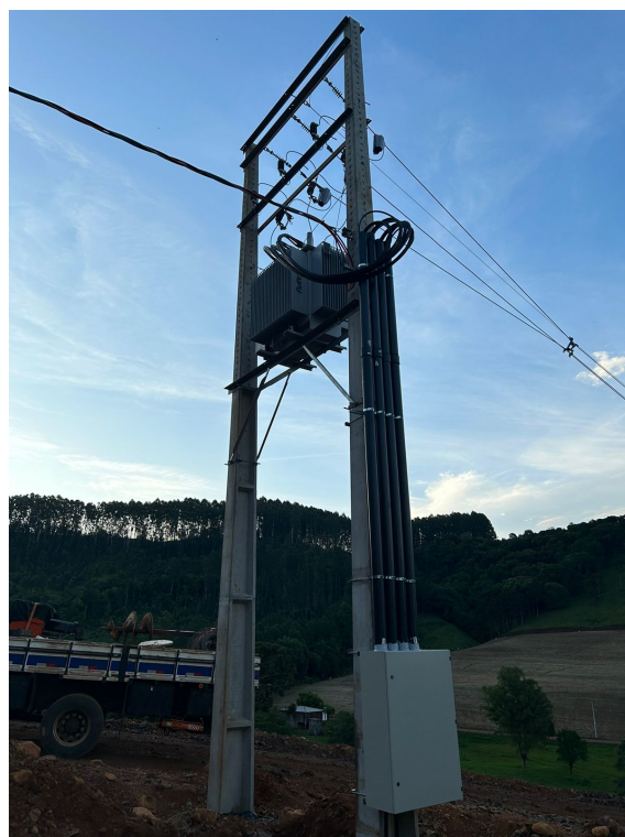
Figura 18: Instalação do Transformador de 750 KVA e quadro geral 1600 A.
