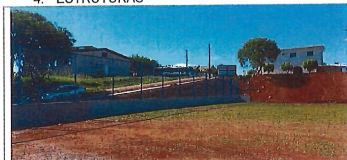
Execução de viga baldrame, pilares e viga da mureta do campo
