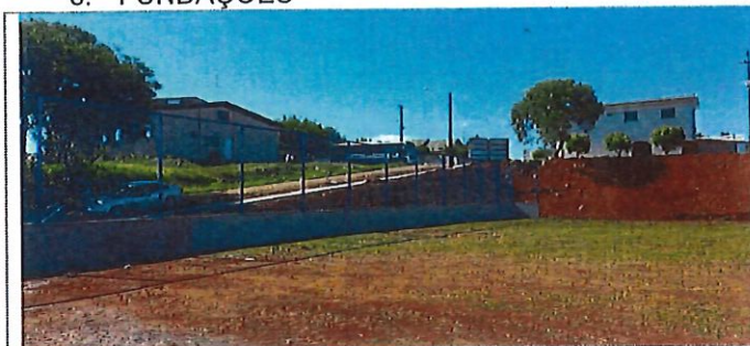
Estaca broca campo
