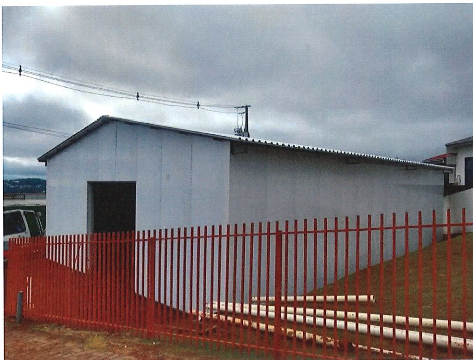
Foto 5: Vista lateral direita do barracão finalizado
