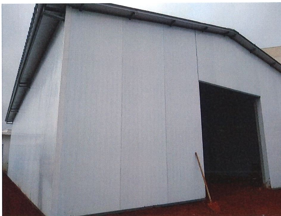
Foto 4: Vista lateral esquerda do barracão finalizado
