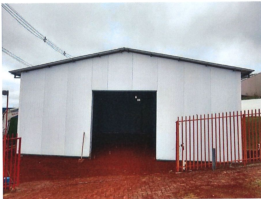
Foto 1: Vista frontal do barracão finalizado
