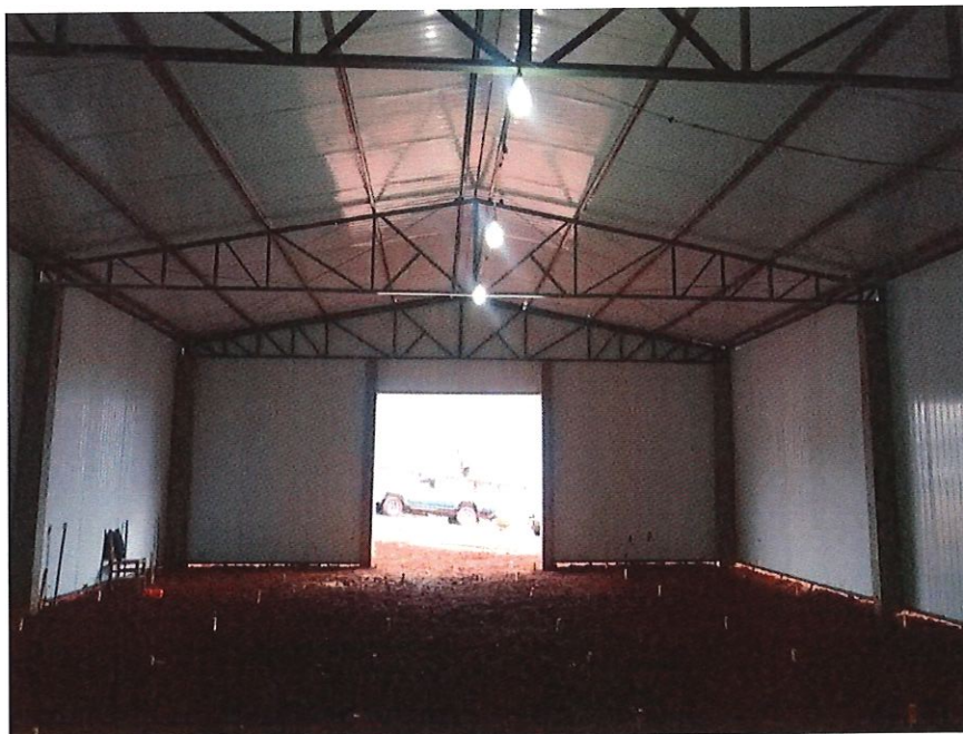
Foto 2: Vista interna frontal do barracão finalizado
