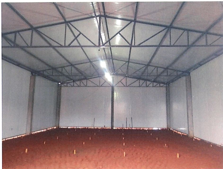
Foto 3: Vista interna posterior do barracão finalizado
