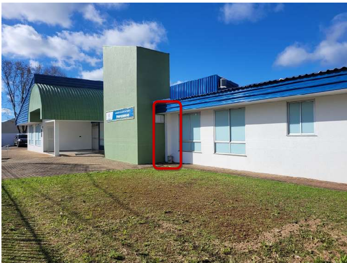
Foto 1: Frente da Obra, Mocheta em alvenaria
