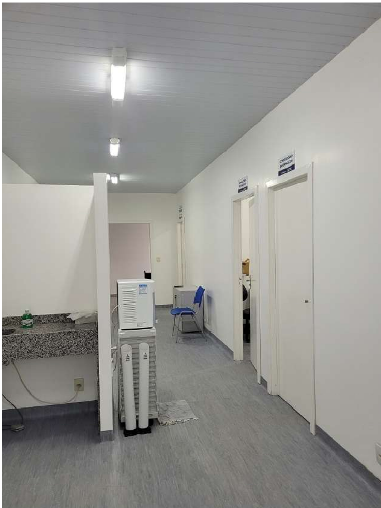
Foto 2: Área interna. Pontos de água e esgoto.
