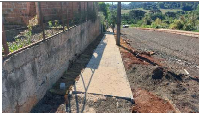
EXECUÇÃO DAS CALÇADAS RUA ANDRÉ CAVALLI (FOTO 18)
