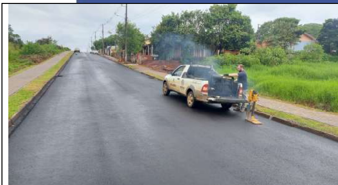
EXECUÇÃO DE ENSAIOS TECNOLÓGICOS RUA ANDRE CAVALLI (FOTO 31)
