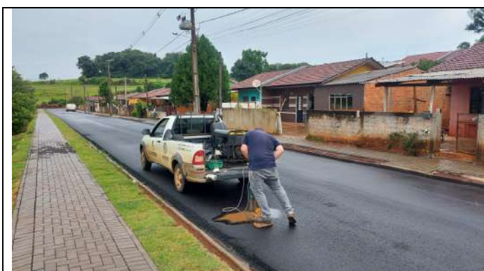
EXECUÇÃO DE ENSAIOS TECNOLÓGICOS RUA ANDRE CAVALLI (FOTO 33)
