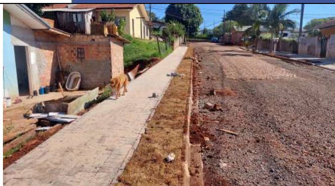
EXECUÇÃO DAS CALÇADAS RUA ASSIS ANDREATTA (FOTO 19)
