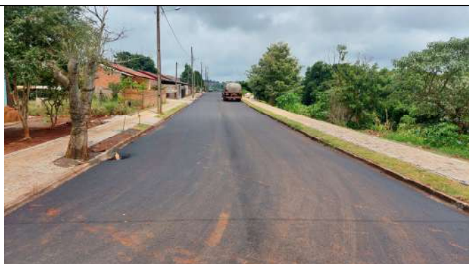
PAVIMENTAÇÃO EM CBUQ RUA ANDRÉ CAVALLI (FOTO 23)
