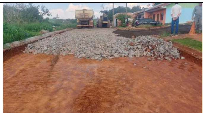
EXECUÇÃO DO MACADAME RUA ANDRÉ CAVALLI (FOTO 6)
