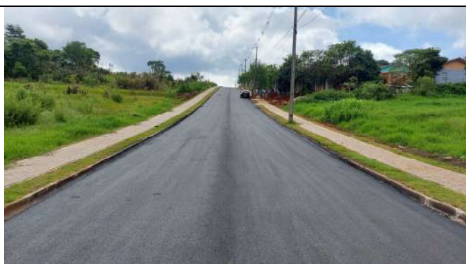
PAVIMENTAÇÃO EM CBUQ RUA ANDRÉ CAVALLI (FOTO 22)
