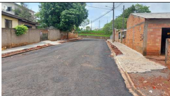
CALÇADAS RUA ASSIS ANDREATTA (FOTO 30)
