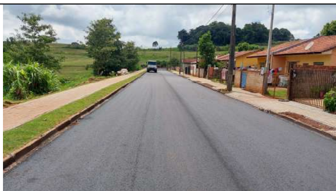
PAVIMENTAÇÃO EM CBUQ RUA ANDRÉ CAVALLI (FOTO 24)
