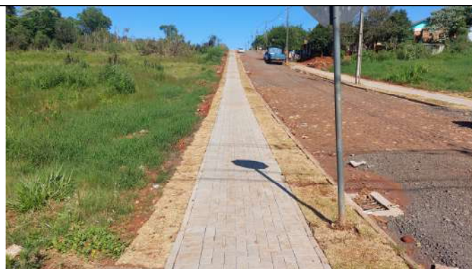
EXECUÇÃO DAS CALÇADAS RUA ANDRÉ CAVALLI (FOTO 16)
