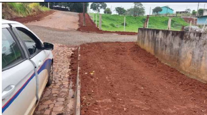
EXECUÇÃO DA BASE E REGULARIZAÇÃO DAS CALÇADAS RUA JOÃO LORA (FOTO 13)
