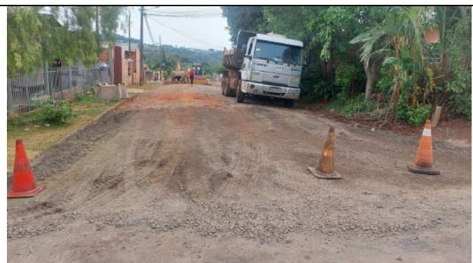
EXECUÇÃO DA BASE RUA ASSIS ANDREATTA (FOTO 4)
