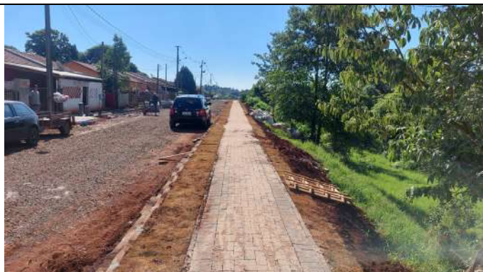
EXECUÇÃO DAS CALÇADAS RUA ANDRÉ CAVALLI (FOTO 17)
