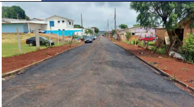
REPERFILAGEM EM CBUQ RUA CELESTE MOCELIN (FOTO 25)
