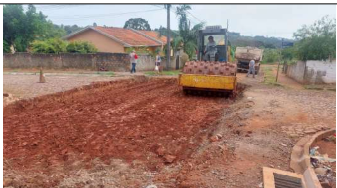
ESCAVAÇÃO E COMPAC. RUA ASSIS ANDREATTA (FOTO 3)
