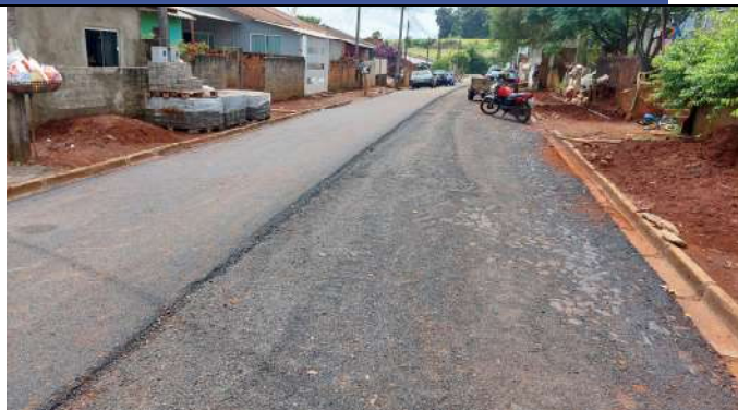
REPERFILAGEM E PAVIMENTAÇÃO EM CBUQ RUA CELESTE MOCELIN (FOTO 26)
