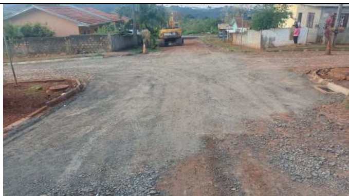
EXECUÇÃO DA BASE RUA ASSIS ANDREATTA (FOTO 9)
