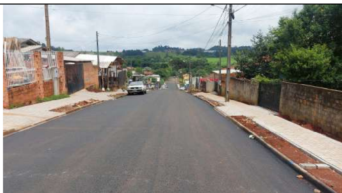
PAVIMENTAÇÃO EM CBUQ E CALÇADAS RUA CELESTE MOCELIN (FOTO 27)
