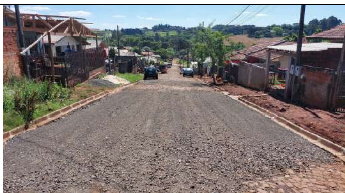
EXECUÇÃO DA BASE RUA CELESTE MOCELIN (FOTO 11)
