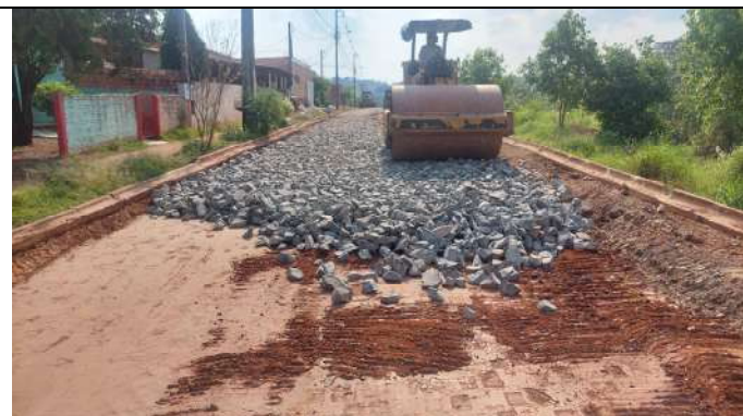
EXECUÇÃO DO MACADAME RUA ANDRÉ CAVALLI (FOTO 8)
