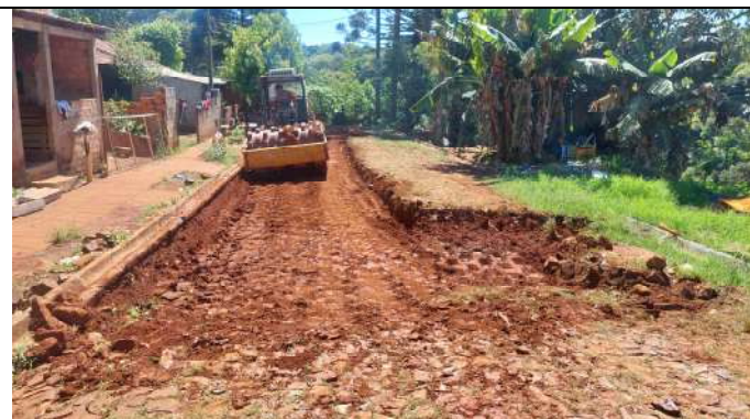
ESCAVAÇÃO E COMPAC. RUA CELESTE MOCELIN (FOTO 10)
