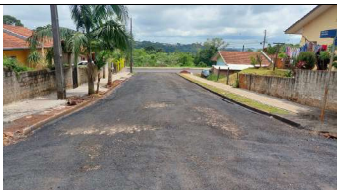
CALÇADAS RUA ASSIS ANDREATTA (FOTO 29)
