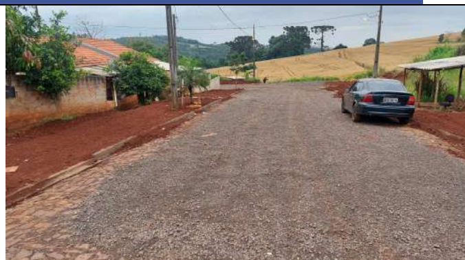
EXECUÇÃO DA BASE E REGULARIZAÇÃO DAS CALÇADAS RUA JOÃO LORA (FOTO 14)
