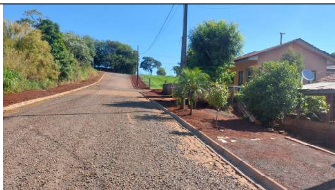
EXECUÇÃO DE MEIO-FIOS RUA JOÃO LORA (FOTO 15)
