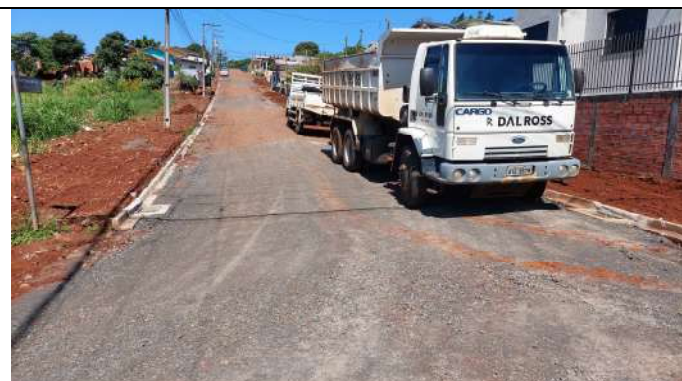
EXECUÇÃO DA BASE RUA CELESTE MOCELIN (FOTO 12)
