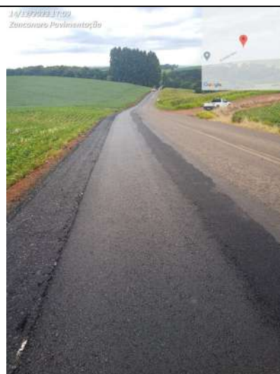
FOTO 18: PAVIMENTAÇÃO EM CBUQ
