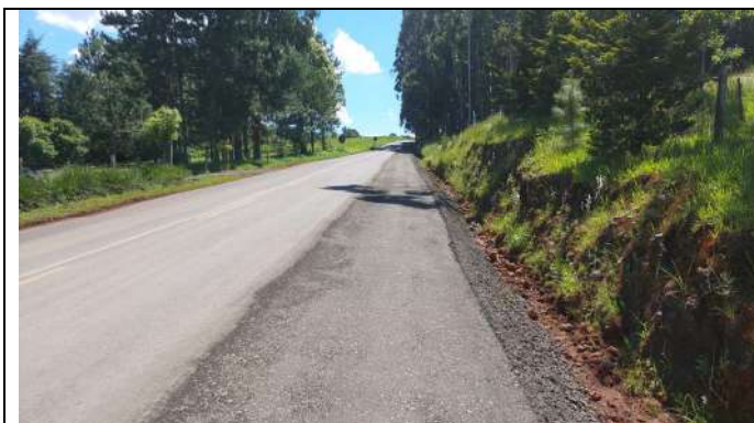
FOTO 05: BASE DE BRITA GRADUADA
