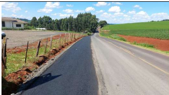
FOTO 07: BASE DE BRITA GRADUADA E IMPRIMAÇÃO
