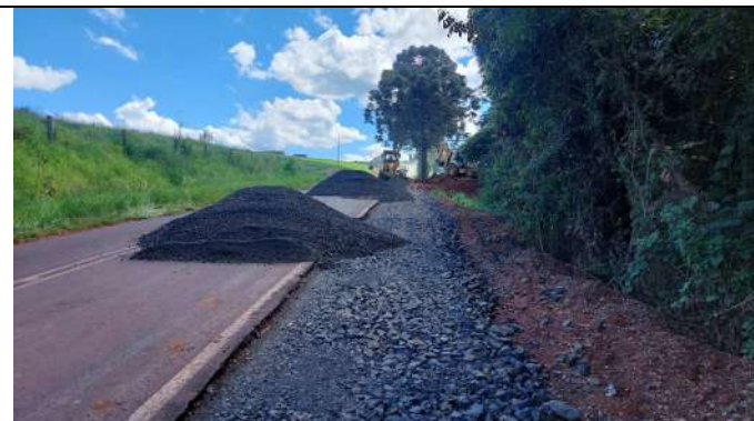
FOTO 08: EXECUÇÃO DE BASE DE BRITA GRADUADA
