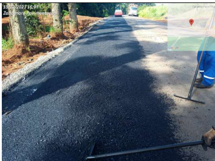
FOTO 17: PAVIMENTAÇÃO EM CBUQ
