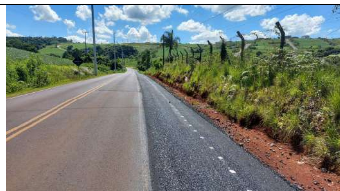
FOTO 03: BASE DE BRITA GRADUADA E IMPRIMAÇÃO
