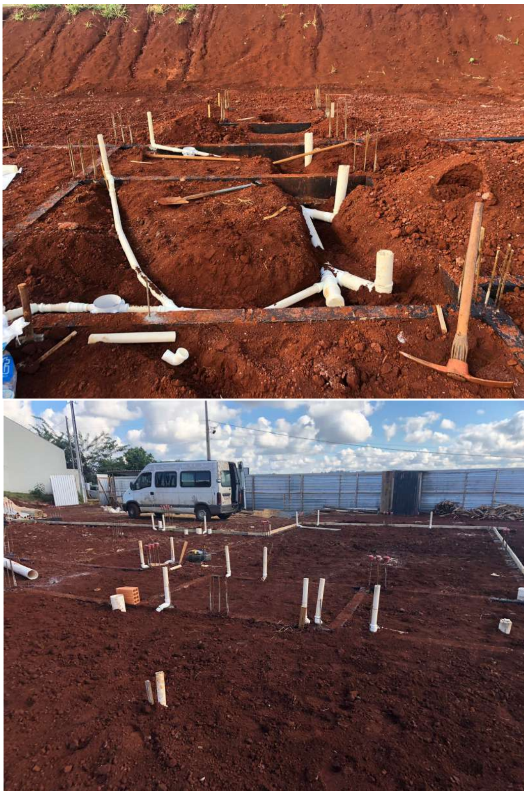
Foto 3: Instalações hidráulicas.
