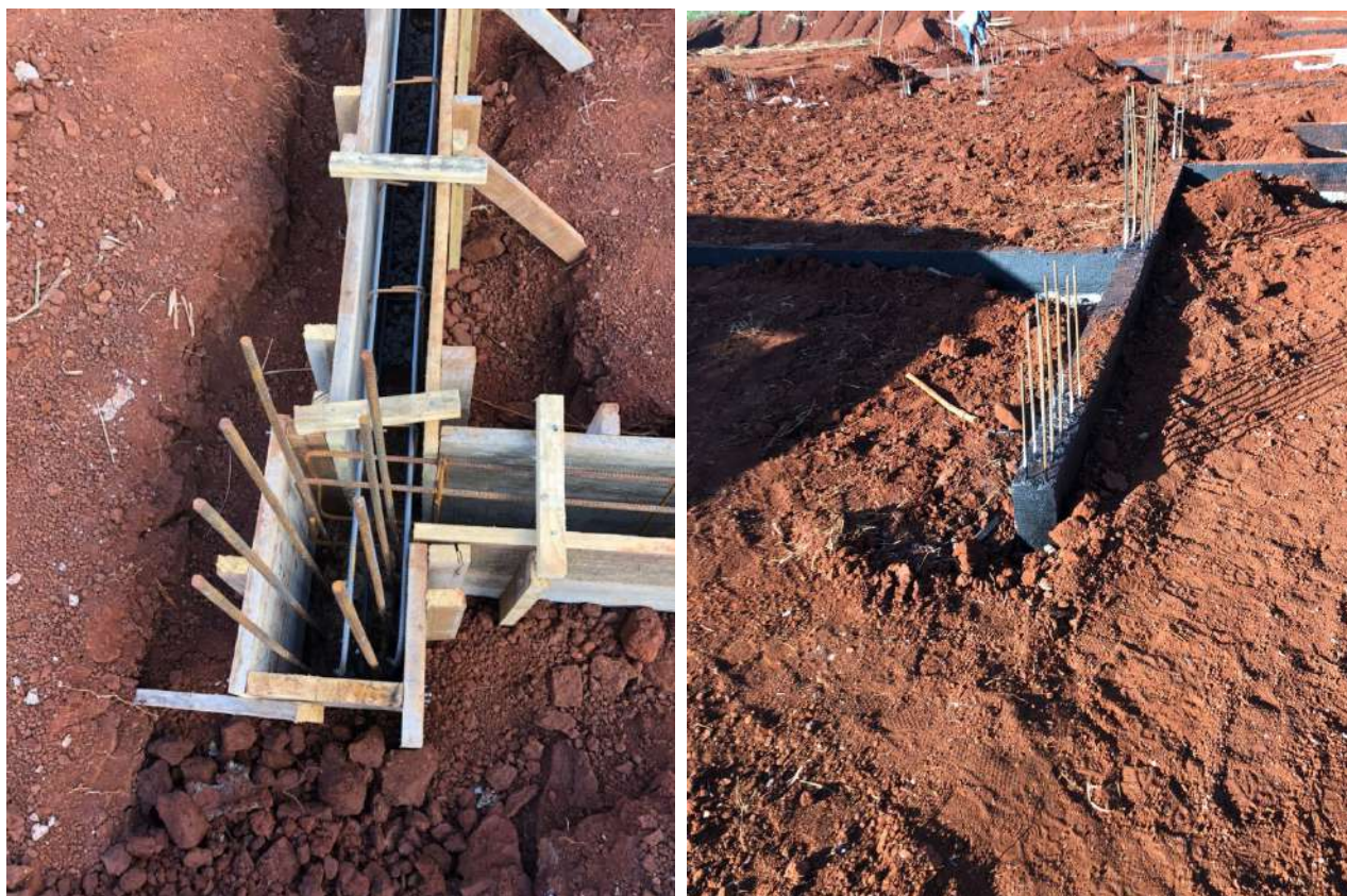
Foto 2: Formas vigas baldrame e impermeabilizações.
