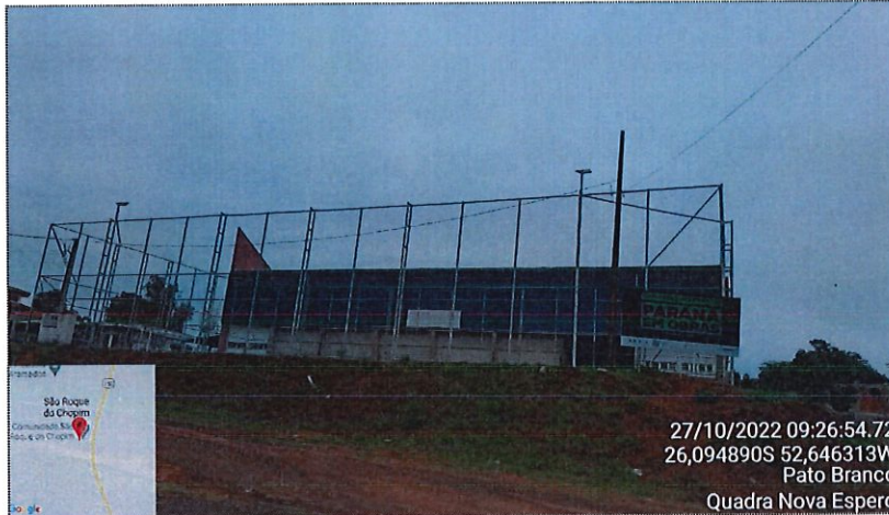
Imagem 07: Alambrado / Grama sintética / Iluminação / Placa de obra
