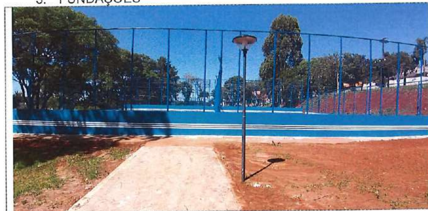
Execução de parte da parede do campo de vôlei que estava faltando
