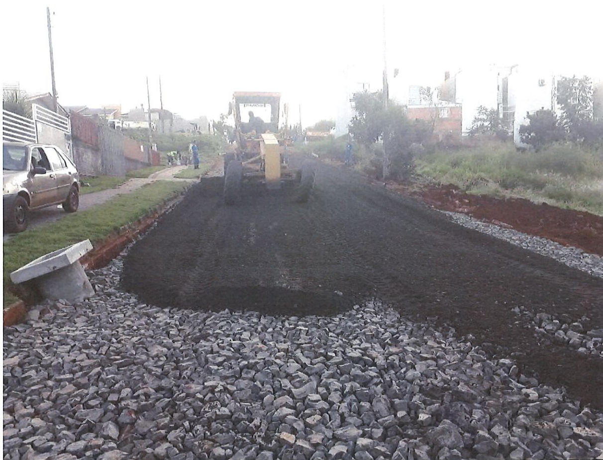
Foto 03: Execução da Base em Brita Graduada.
