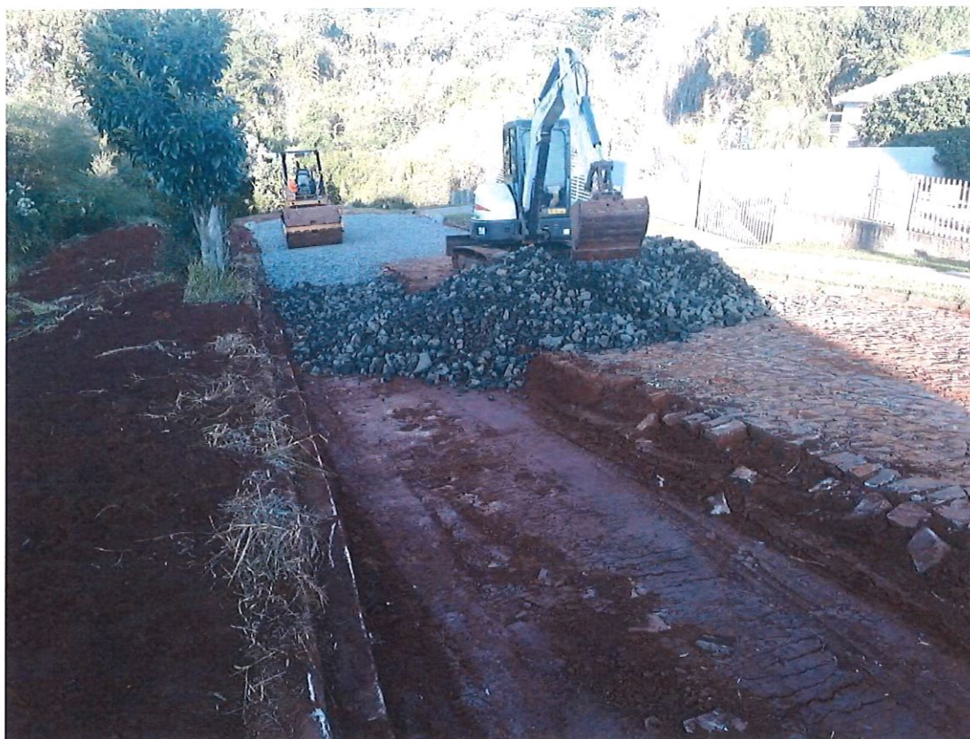
Foto 02: Execução da Sub-base em Macadame.
