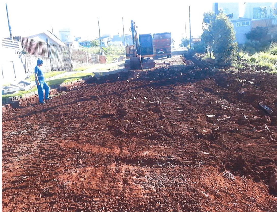
Foto 01: Escavação do Reforço de Base.
