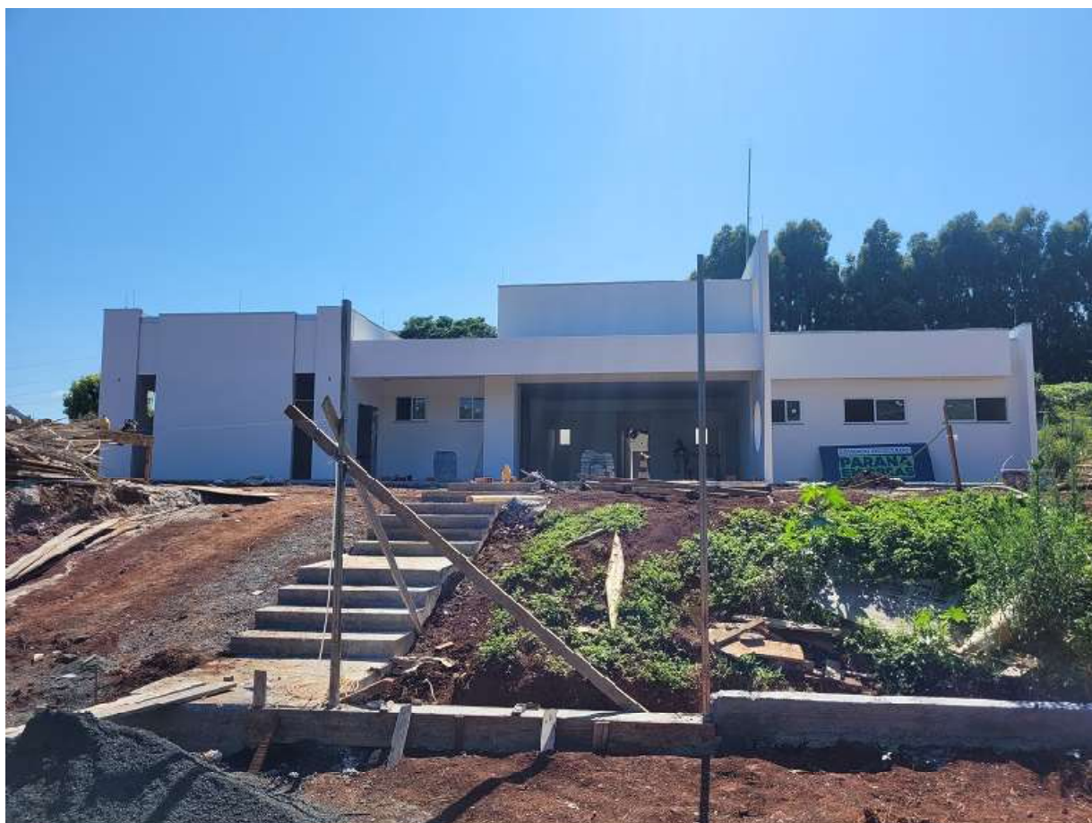
Foto 1: Fachada da Obra (execução da pintura externa, cercamento)
