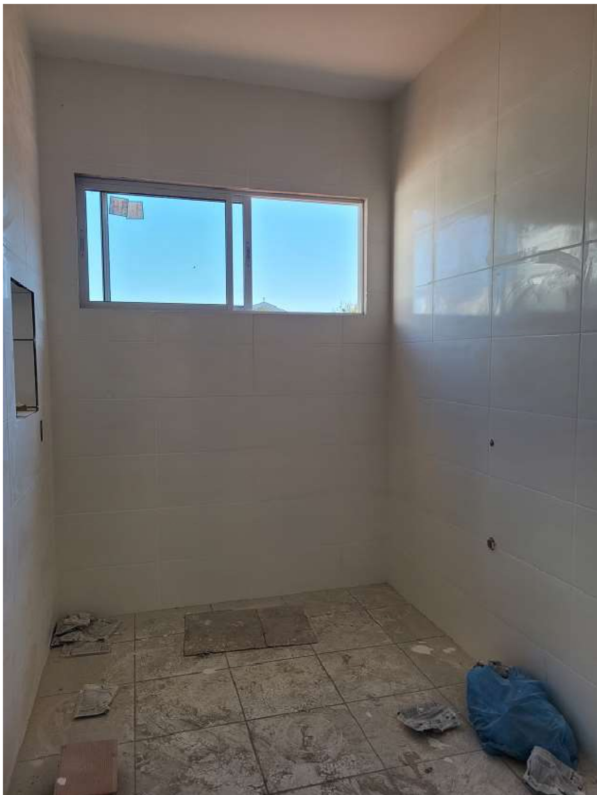
Foto 8: Recepção e Lavagem (revestimento interno).
