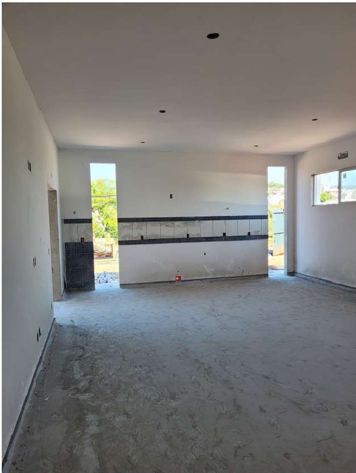
Foto 6: Espaço em saúde (revestimentos internos).
