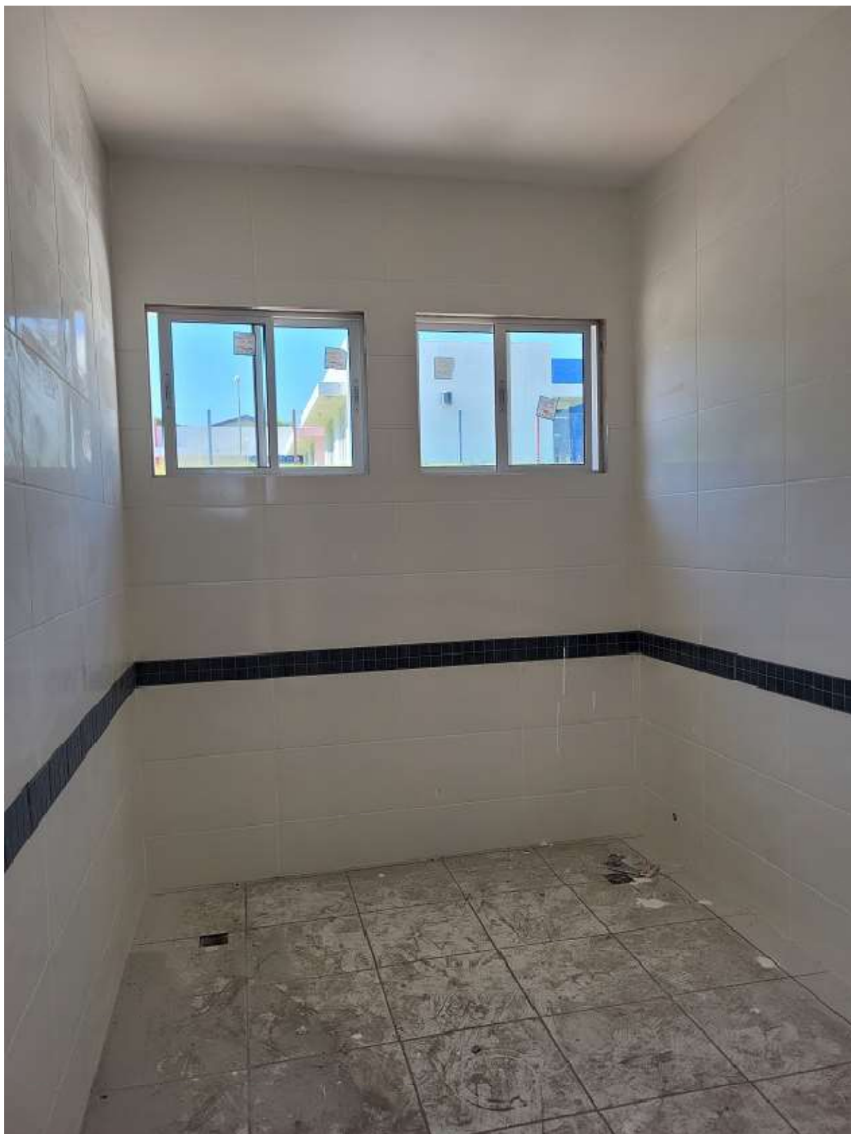
Foto 7: Banheiro (revestimento interno, janelas).
