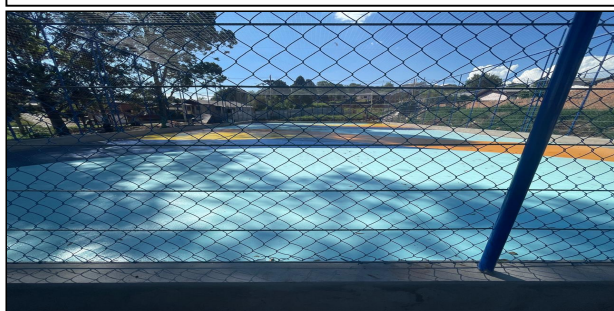
9 | quadra e alambrado
