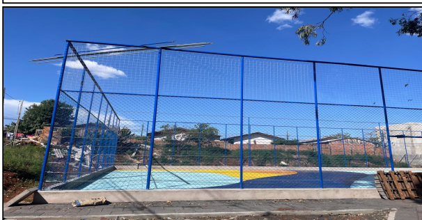
2 | quadra e alambrado
