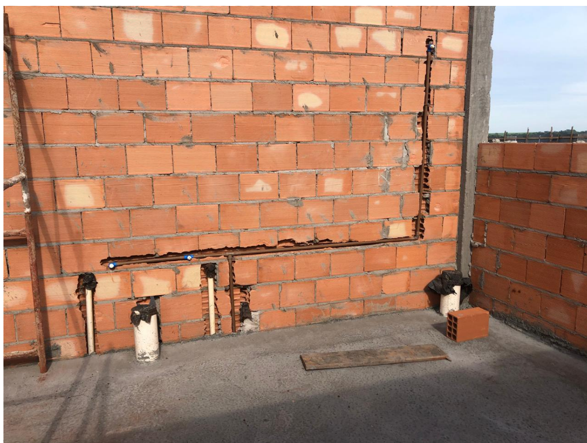
Foto 6: Ligações de água e esgoto..
