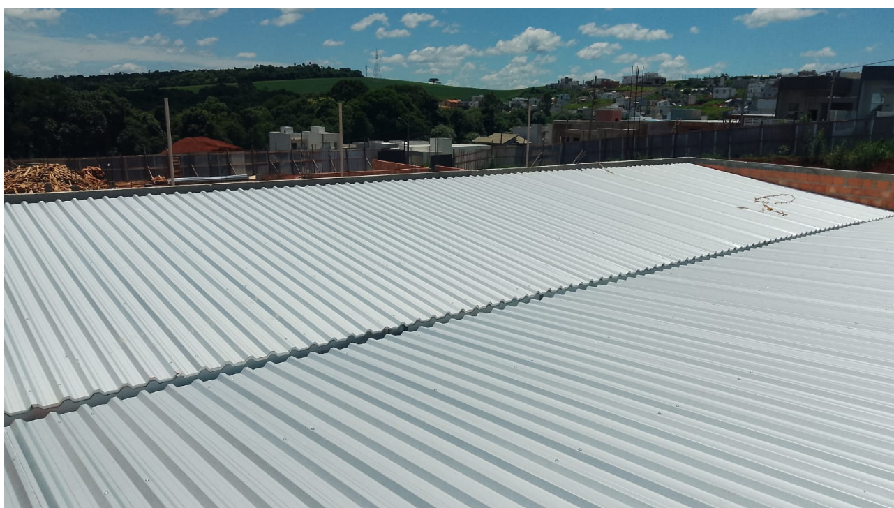
Foto 4: Estrutura Metálica e Telhamento.
