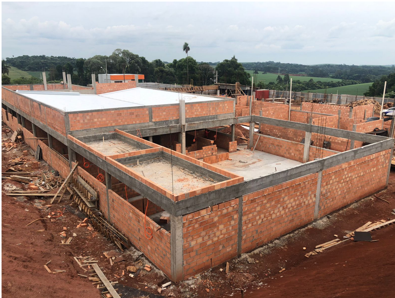
Foto 1: Foto Panorâmica da Obra.
