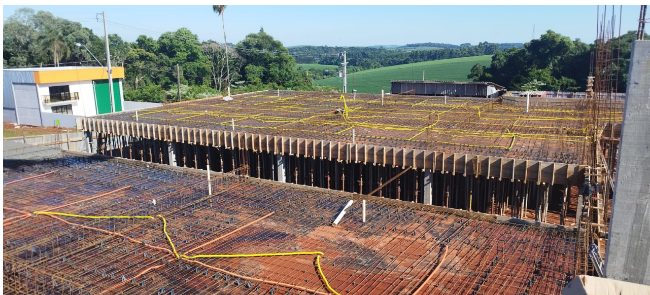
Foto 5: Laje – Fôrmas, Armaduras, Eletrodutos.
