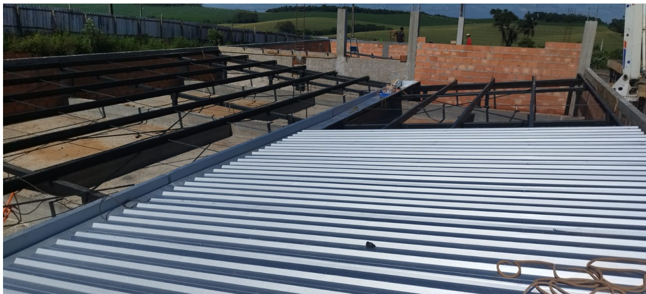
Foto 3: Estrutura Metálica e Telhamento.
