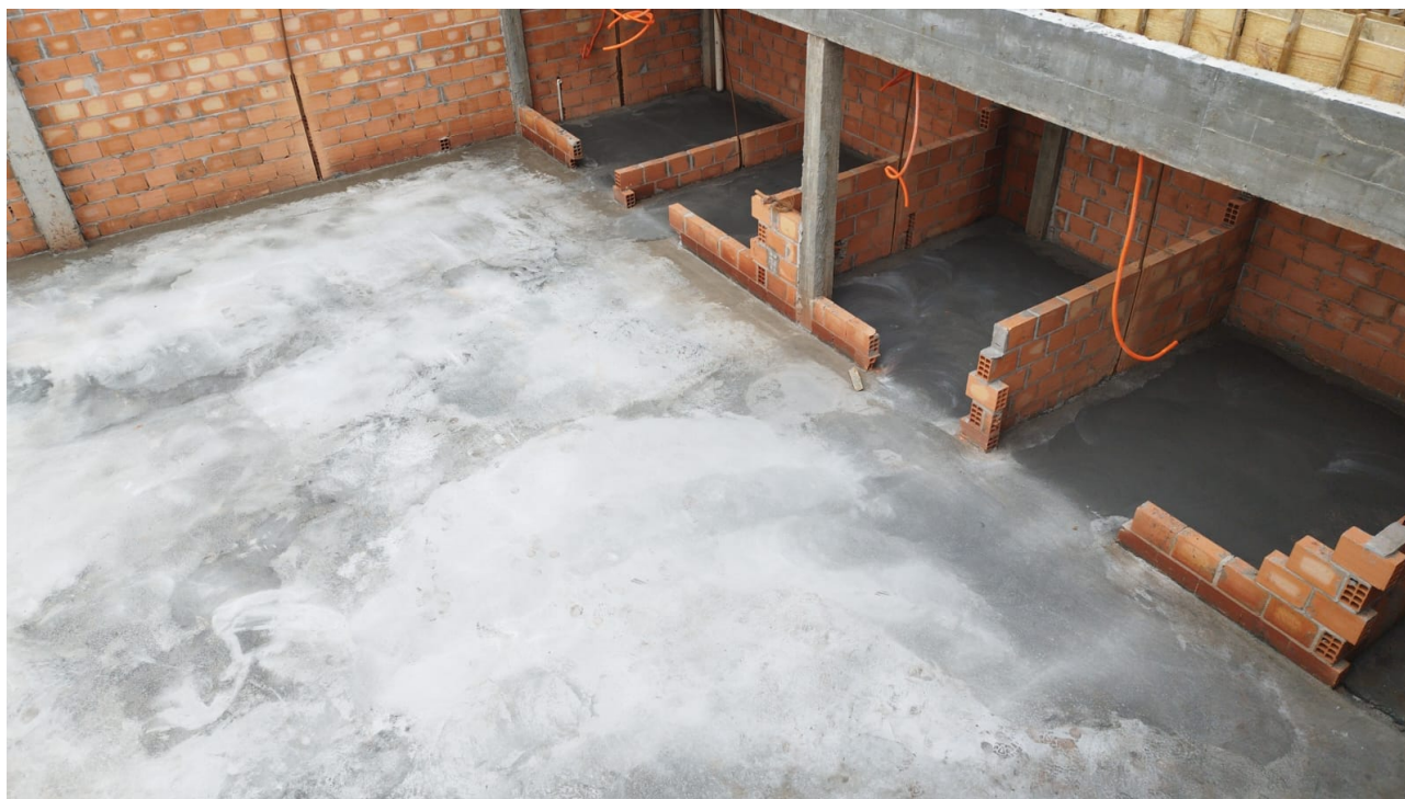
Foto 10: Piso e alvenarias.
