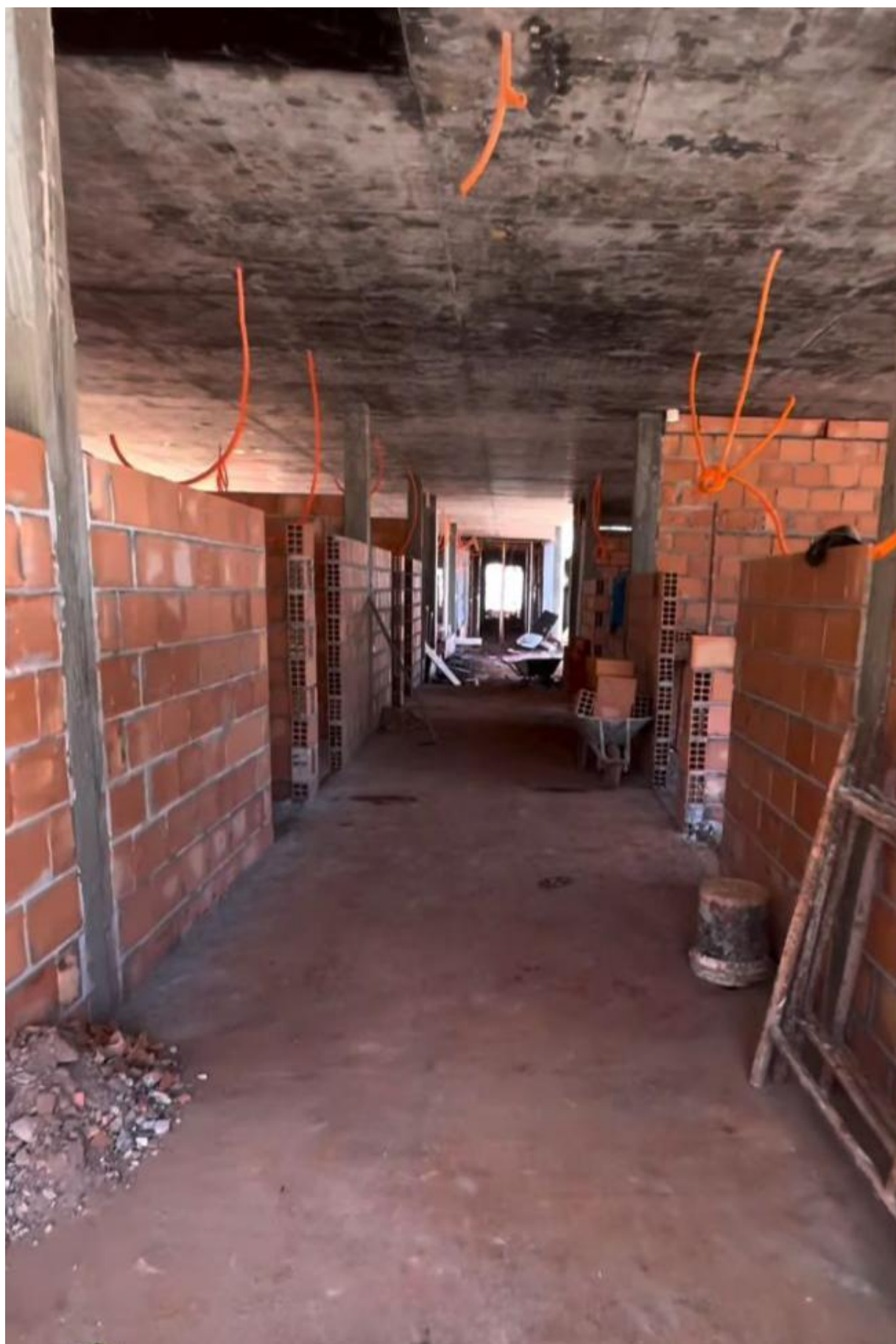
Foto 9: Piso e alvenarias.
