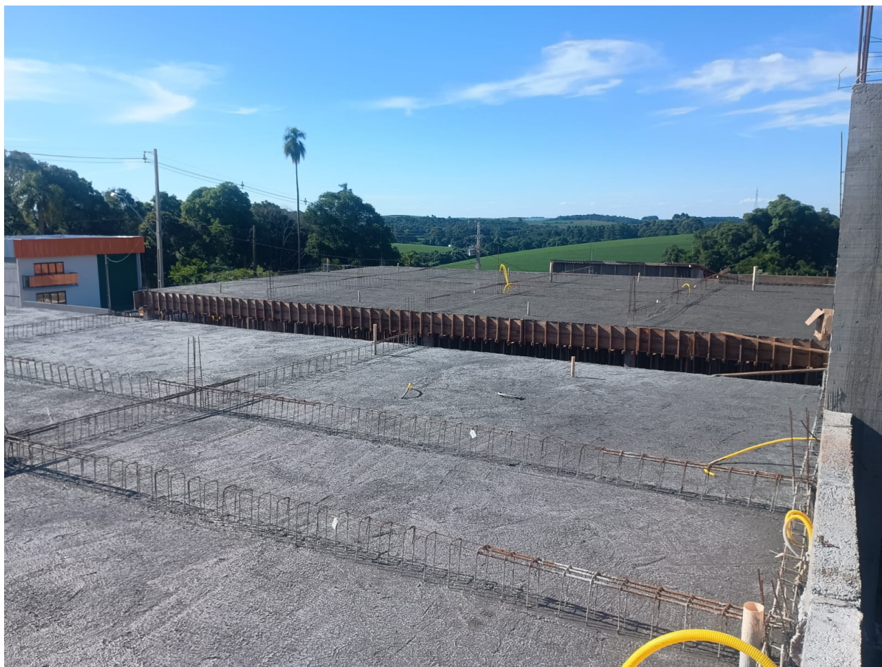
Foto 7: Laje concretada.
