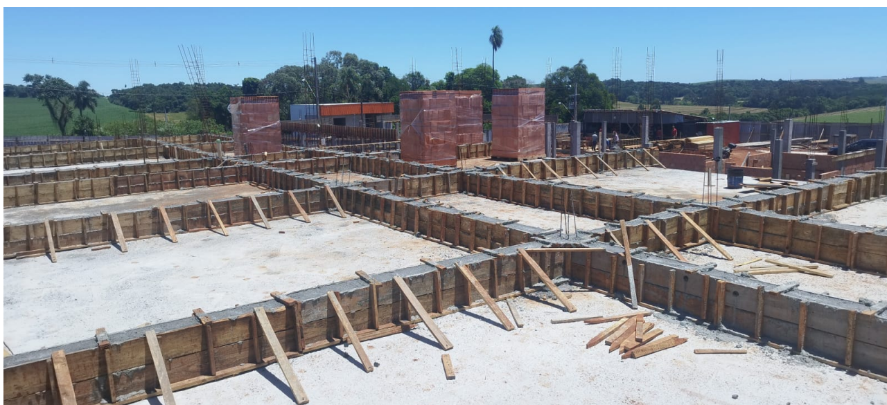
Foto 2: Laje 1 e vigas concretadas.
